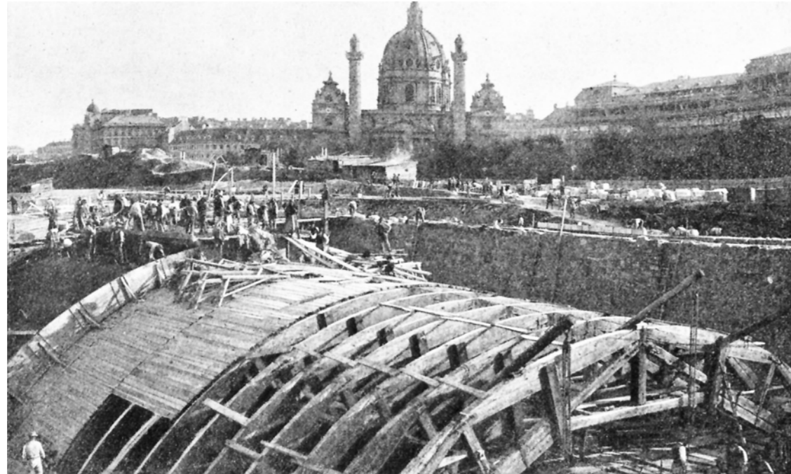
Abb. 10: Wienfluss-Einwölbung bei der ehemaligen Elisabethbrücke beim Karlsplatz (Kortz, 1905) S.339/Abb.341
