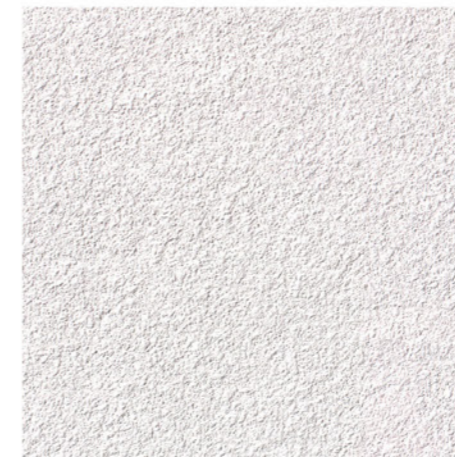
Abb. 91: Außenwand: Scheibenputz (Kornstärke 1,5 mm)
