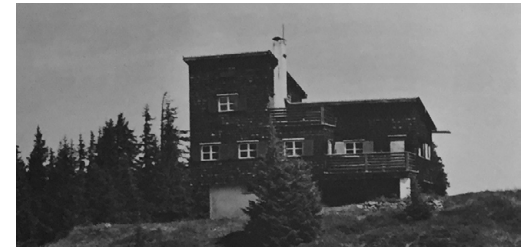
Berghaus am Hahnenkamm, Clemens Holzmeister, 1930
