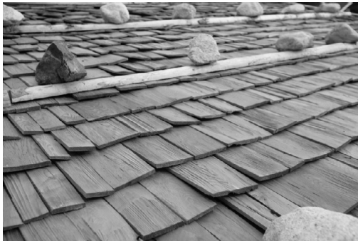
Detailfoto Legschindeldach mit Steinen und Schwarzstangen
