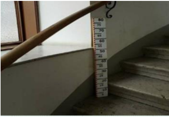
Abb. 8: Beispiel Absturzsicherung, Aufstiegshilfe –OIB-RL 4
