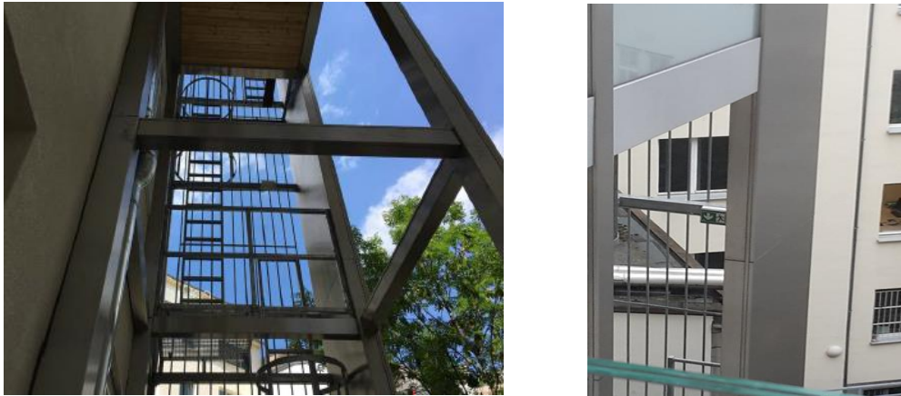
Abb. 19: Rettungswegsystem mit Fluchtwegorientierung
