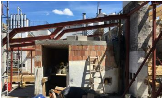
Abb. 17: Errichtung Dachgeschoß Stahlkonstruktion
