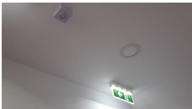
Abb. 20: Fluchtwegorientierungsbeleuchtung
