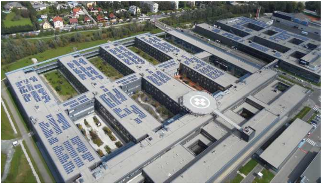
Abbildung 6: Photovoltaikanlagen auf dem Flachdach des Klinikums Klagenfurt (Foto: KABEG)
