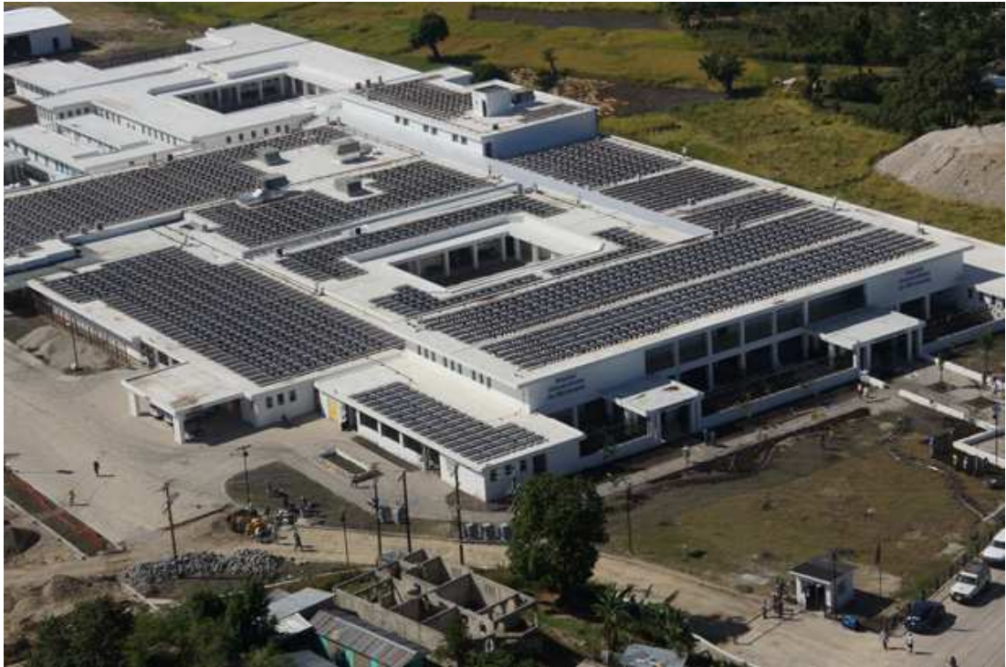
Abbildung 11: Solarbetriebenes Krankenhaus in Haiti (Bild: Partners in Health)
