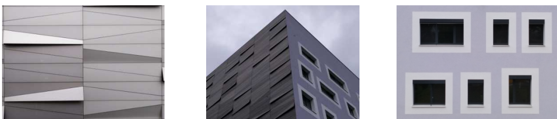
Abbildung 17: Bestandsfassaden Institutsgebäude (Fotos: SALK, Martin Weber)
