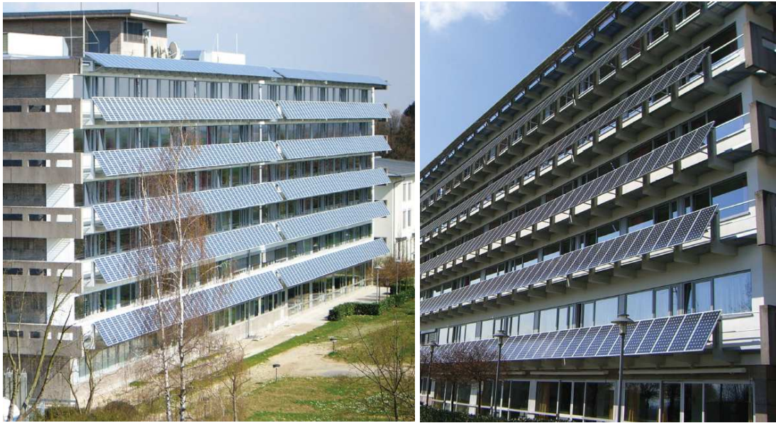
Abbildung 7: PV-Anlage zur Beschattung der Patientenzimmer der Südfassade des Krankenhauses Mühlacker (Foto: BUND Gütesiegel Poster)
