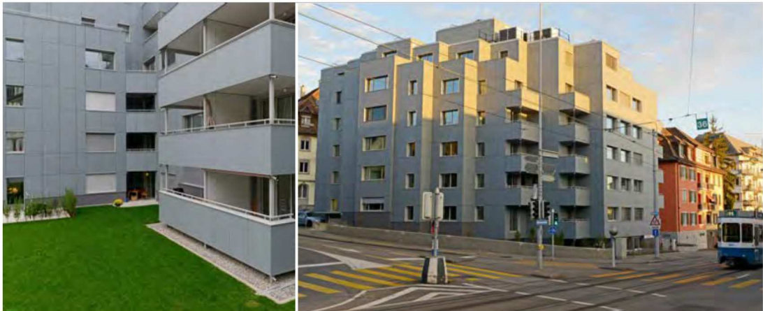
Abbildung 30: BIPV mit Sondermodulen als aktive Glasfassade. BFE-Leuchtturmprojekt: Photovoltaik Fassade an PlusEnergieBau Sanierung Zürich (Viridén K. , 2018)
