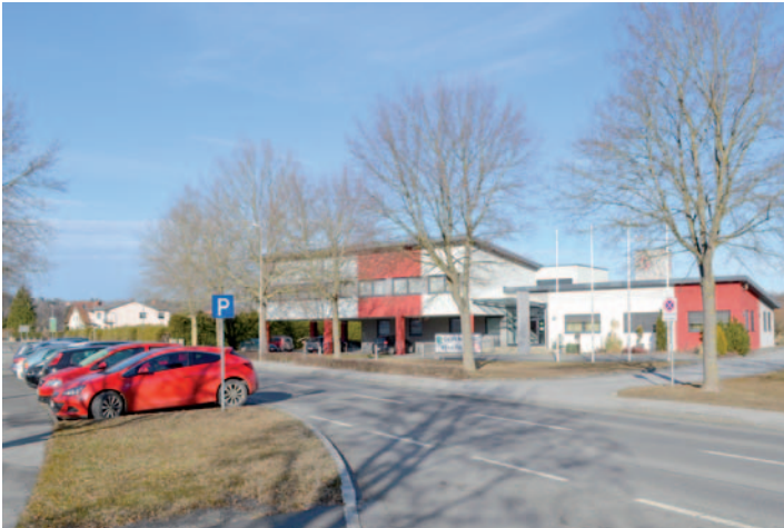
Abb. 74 (links): Ansicht des neu erreichten Gemeindeamts mit Feuerwehr, Arzt- und Mehrzweckräumen Gemeindeplatz 1
