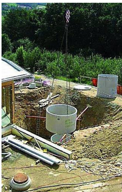
Abb. 48 Einbau einer Zisterne (Retter Seminarhotel Bio Restaurant 2018: online)
