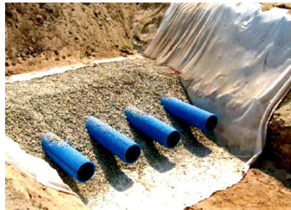
Abb. 33 Rohr-Rigolenversickerung (Freie und Hansestadt Hamburg 2006: online)
