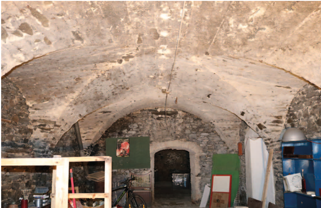
Übersicht EG.20 Blick nach Norden
