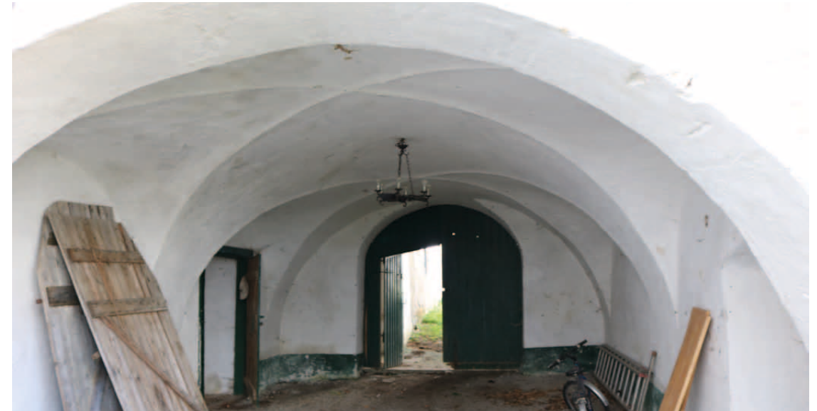
Abb.63: zweijochiges Kreuzgratgewölbe in der Durchfahrt EG.22
