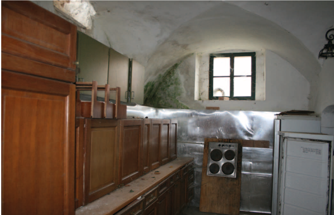
Übersicht EG.17 Blick nach Nordosten
