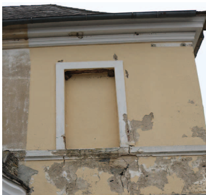
Abb.65: Blindfenster von 1.OG 05/06 an der Westfassade
