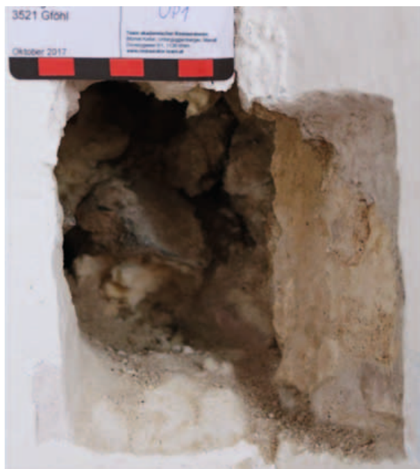
Abb.56: Untersuchungspunkt 1, EG.06, Kompartimentmauerwerk direkt hinter Putz
