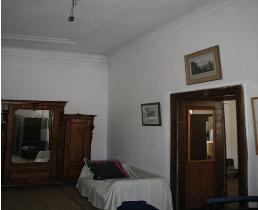
Übersicht 1.OG.18 Blick nach Nordosten
