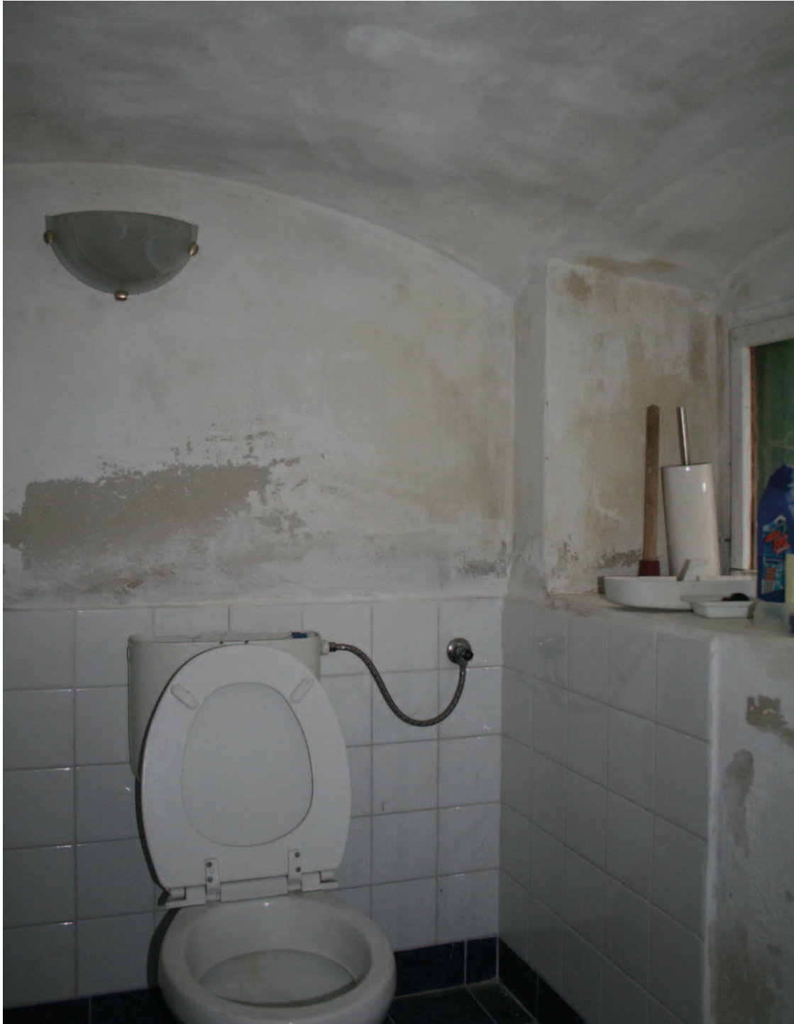
Übersicht EG.02 Blick nach Nordosten
