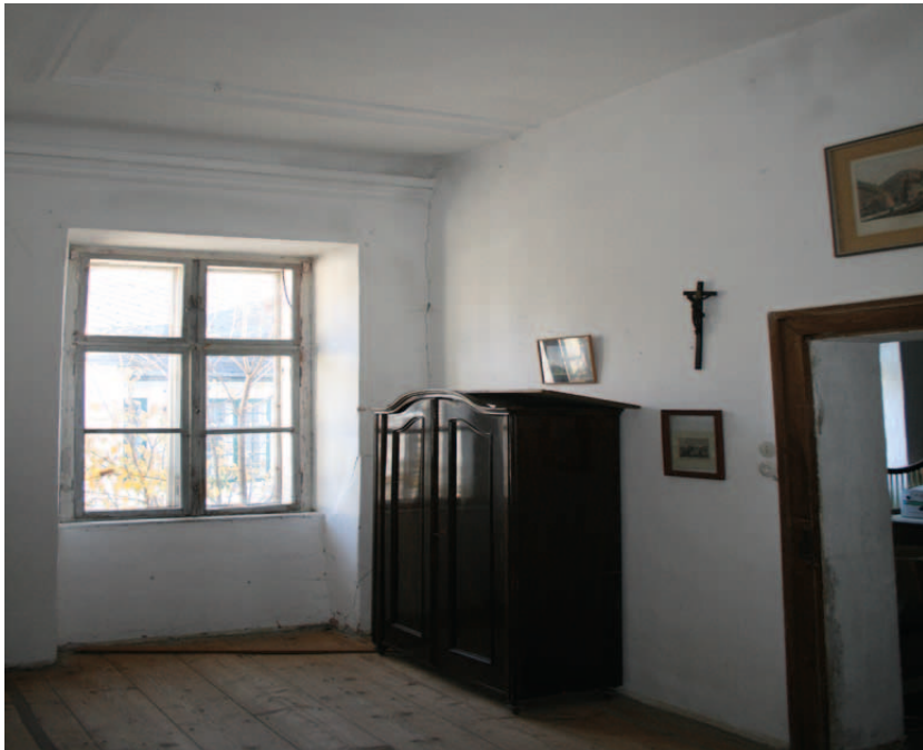
Übersicht 1.OG.18 Blick nach Südwesten
