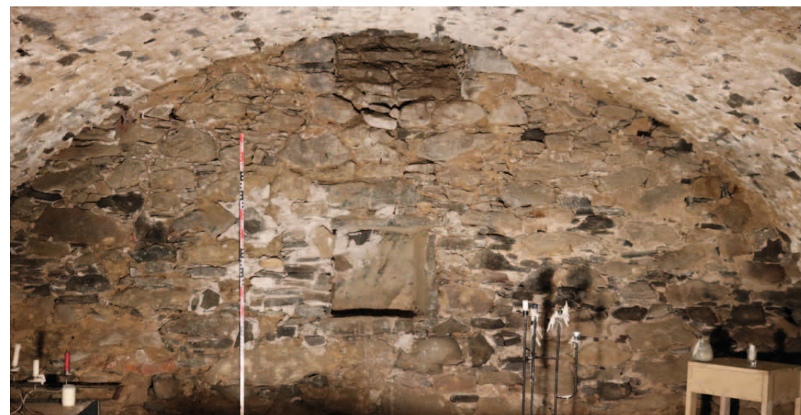
Abb.76: EG.21 Nordwand mit Luftschlitz in 1.OG.27
