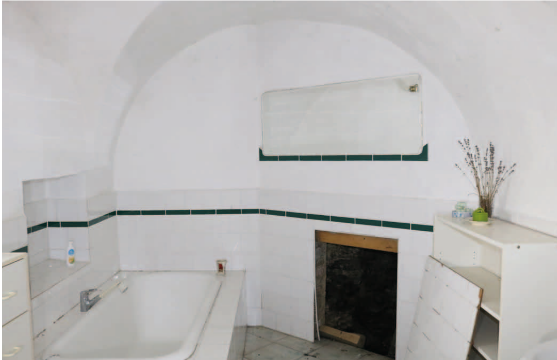
Übersicht EG.08 Blick nach Osten
