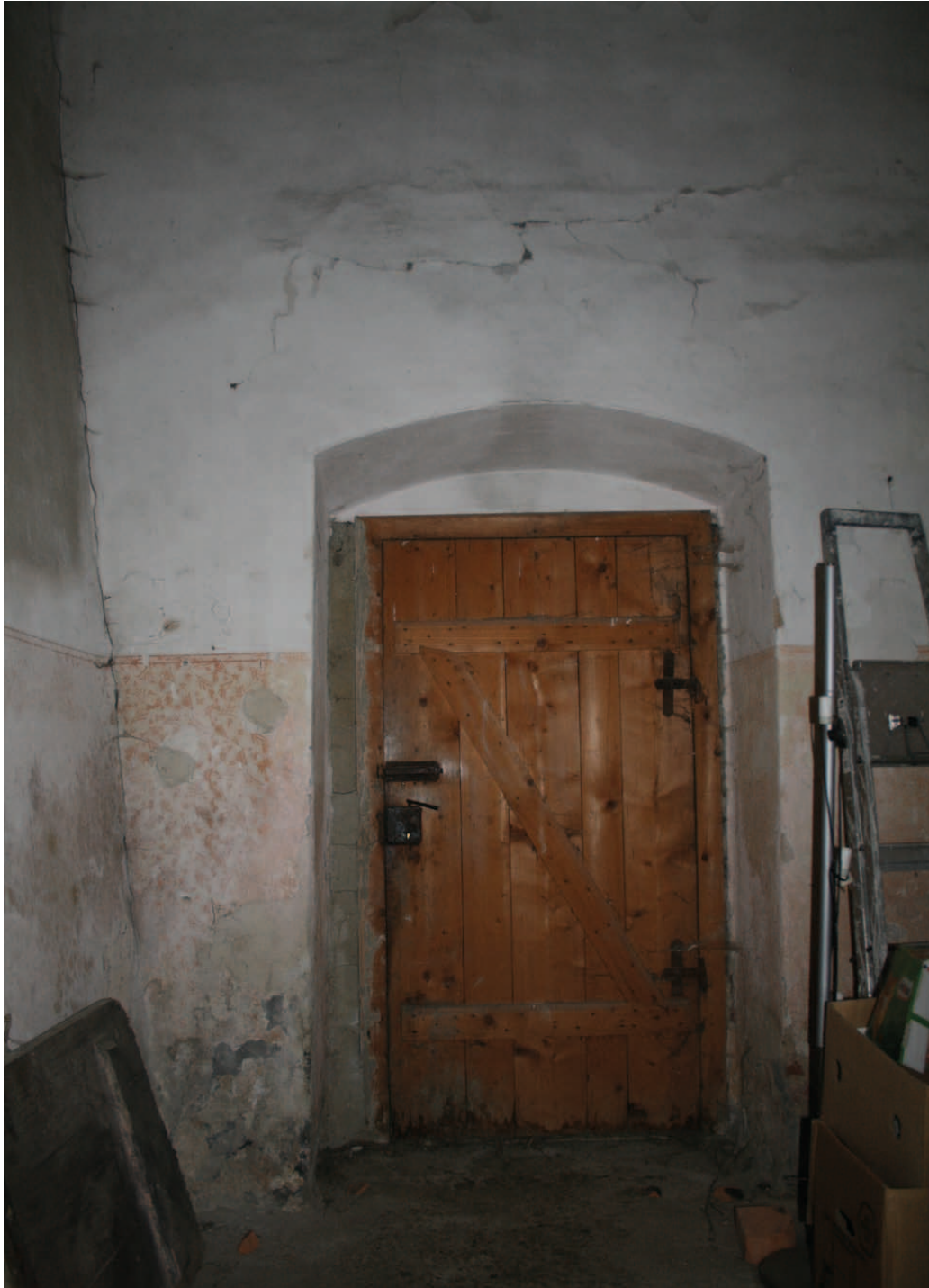
Übersicht 1.OG.24 Blick nach Süden
