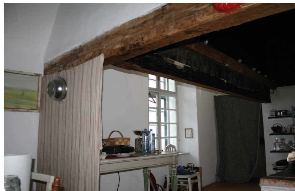
Abb.71: 1.OG.29 mit den Unterzügen als Trennung der Rauchküche, Blick nach Nordwesten
