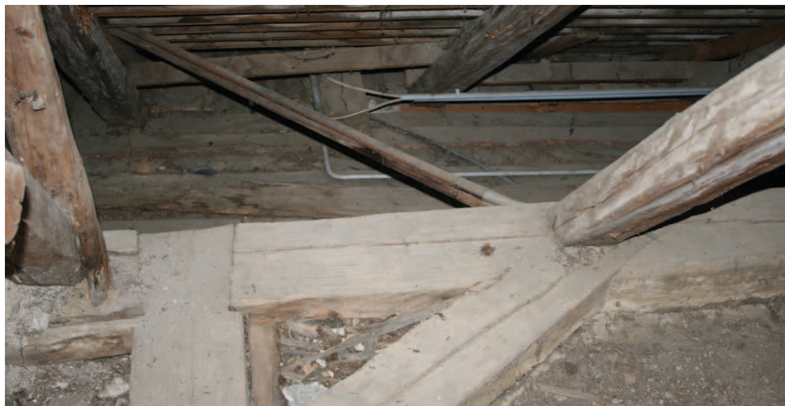
Abb.29: östliche Fußpunkt des Dachstuhles vom Westtrakt und Gang
