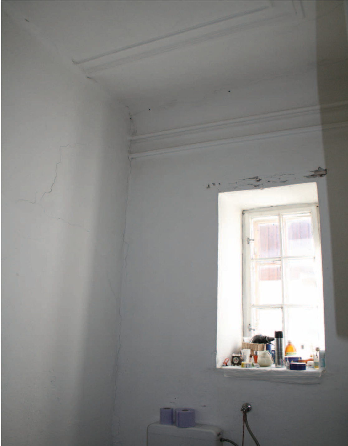
Übersicht 1.OG.08 Blick nach Südosten
