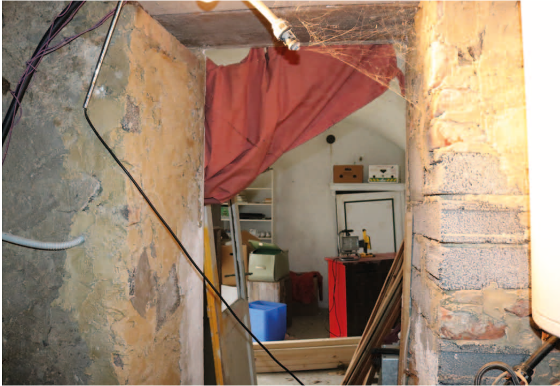
Übersicht EG.11 Blick nach Norden
