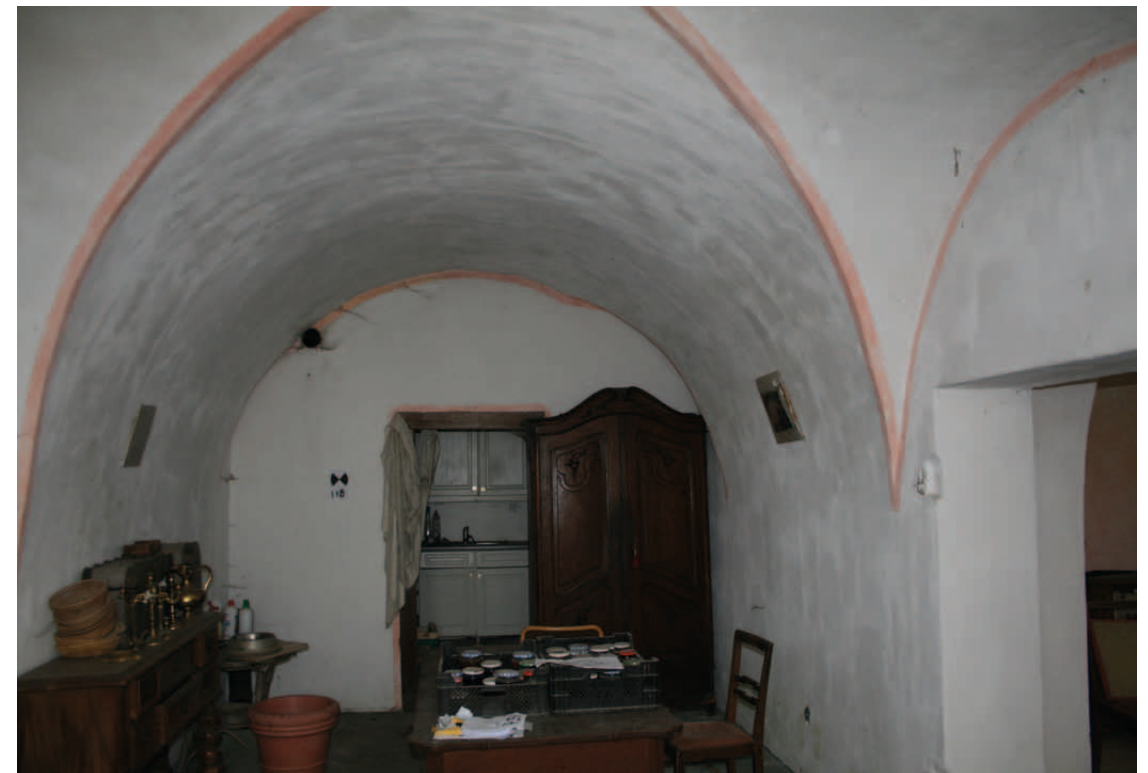
Übersicht EG.15 Blick nach Norden
