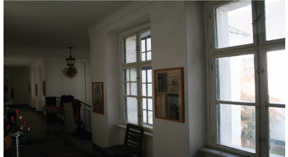
Übersicht 1.OG.01a Nordwand, Blick nach Südwesten
