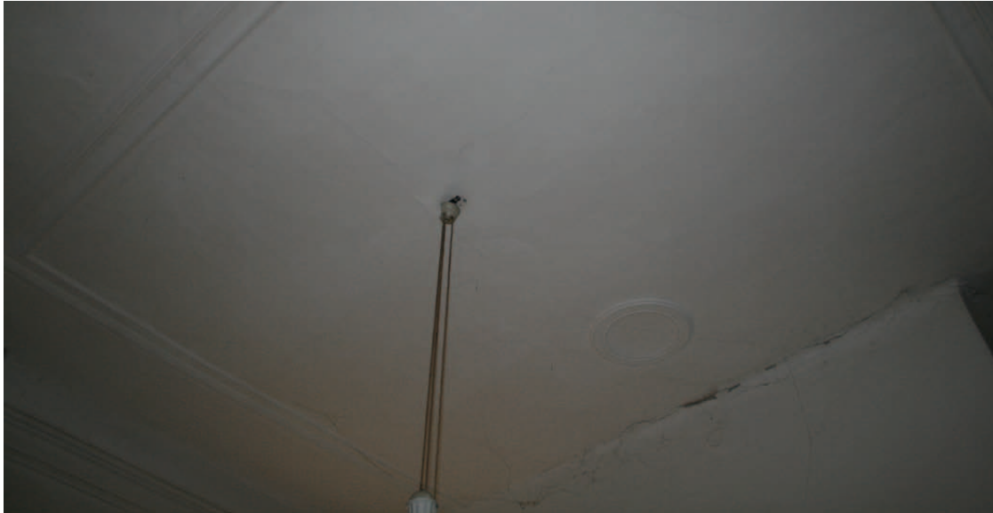
Übersicht 1.OG.07 Decke mit Stuckverzierung und eingebauter Badwand
