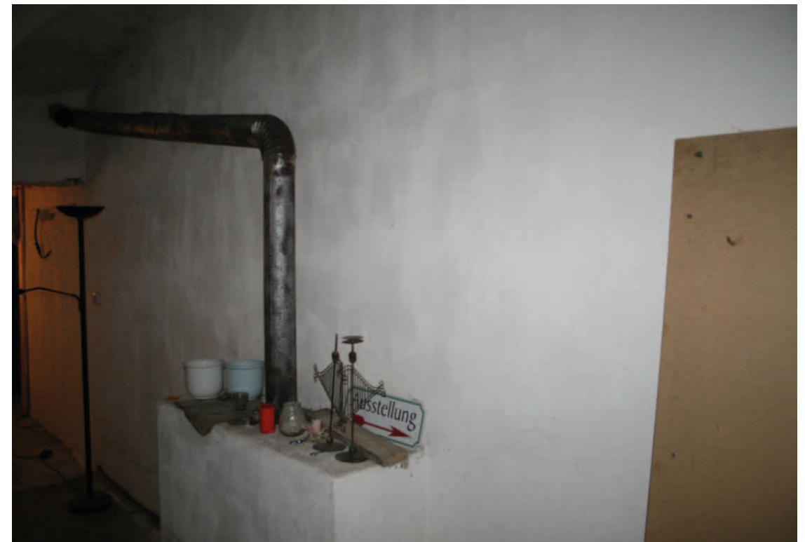
Übersicht EG.19 Blick nach Südosten
