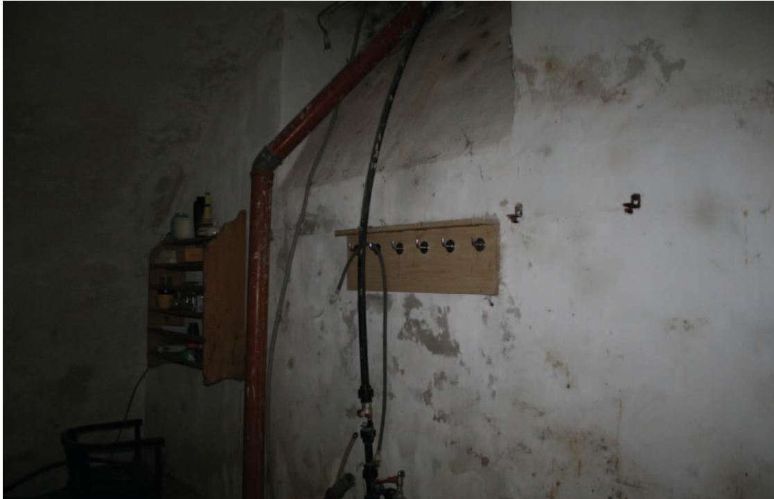
Übersicht EG.19 Blick nach Nordwesten
