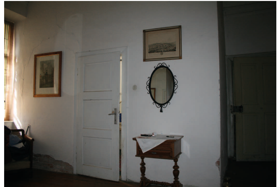
Übersicht 1.OG.07 Blick nach Nordwesten
