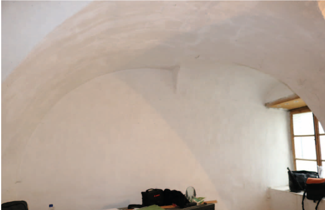
Übersicht EG.26 Blick nach Norden
