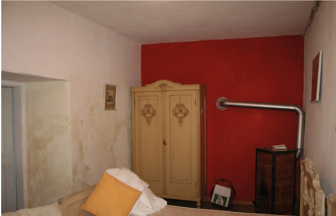
Übersicht EG.06 Blick nach Nordosten
