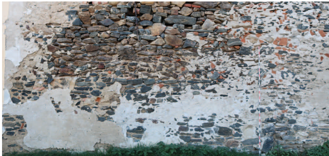
Abb.55: Ostfassade Detailfoto Kompartimentmauerwerk
