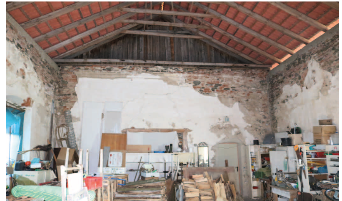
Übersicht 1.OG.27 Südwand
