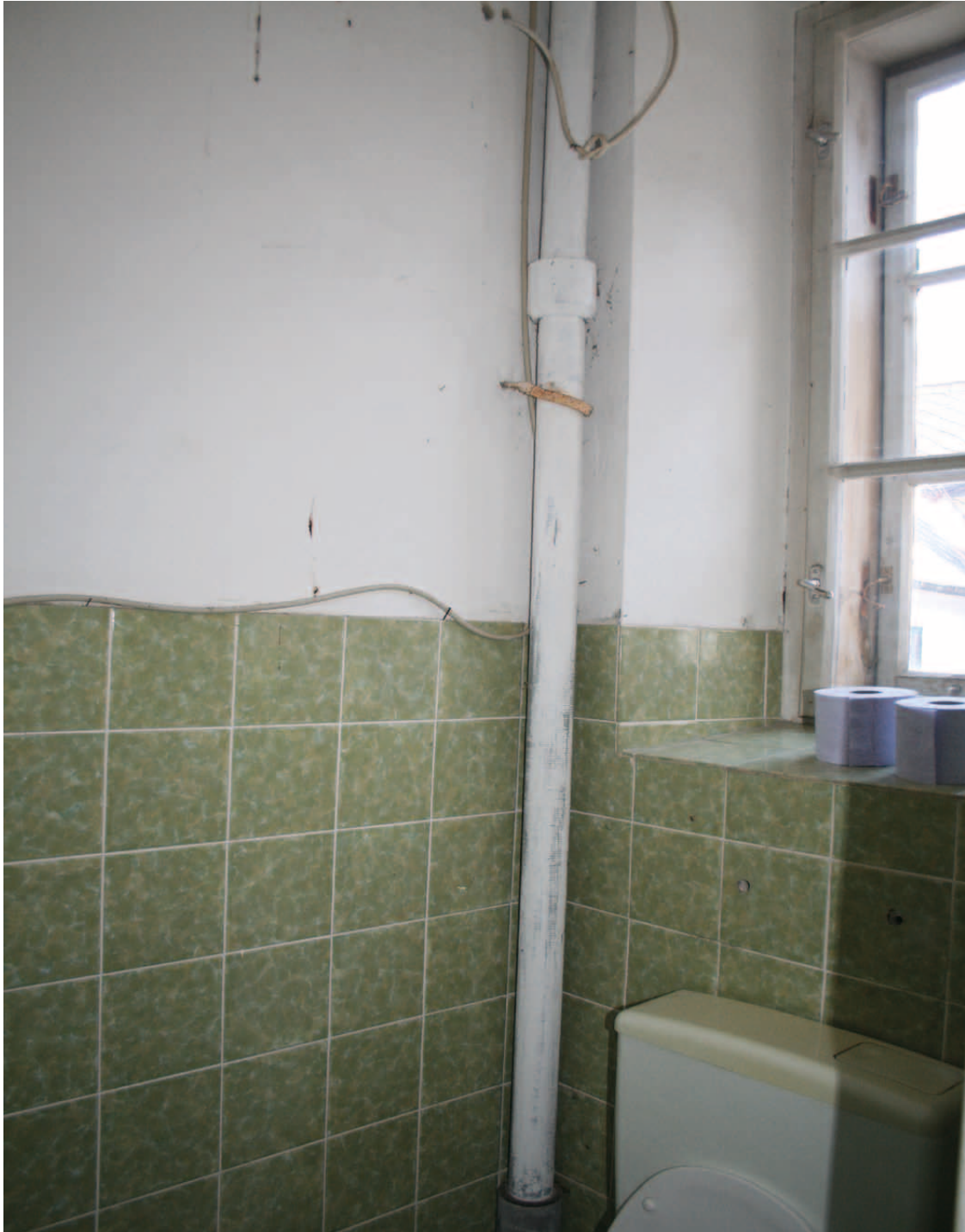
Übersicht 1.OG.014 Blick nach Südosten
