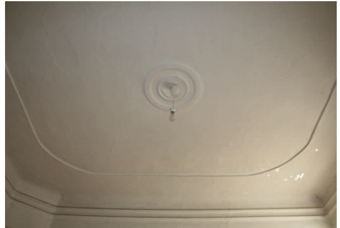
Übersicht 1.OG.12 Decke
