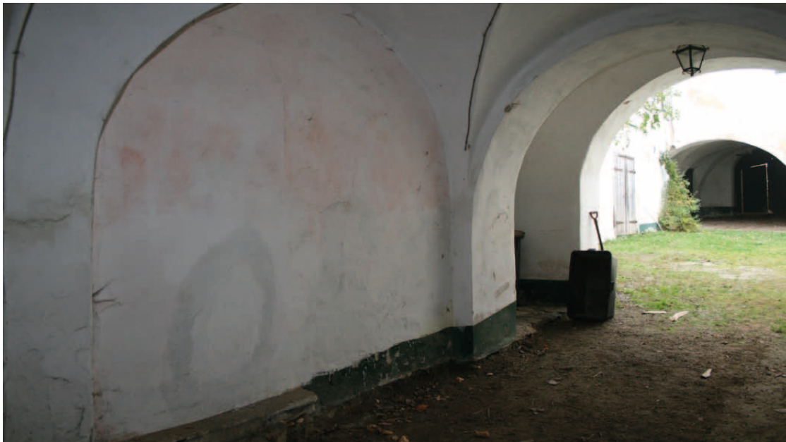
Übersicht EG.30 Blick nach Nordosten
