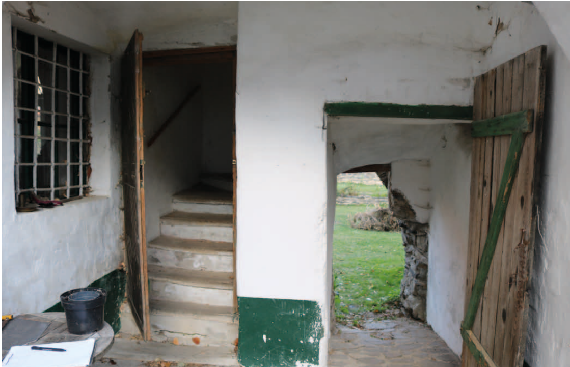
Übersicht EG.13 Blick nach Osten
