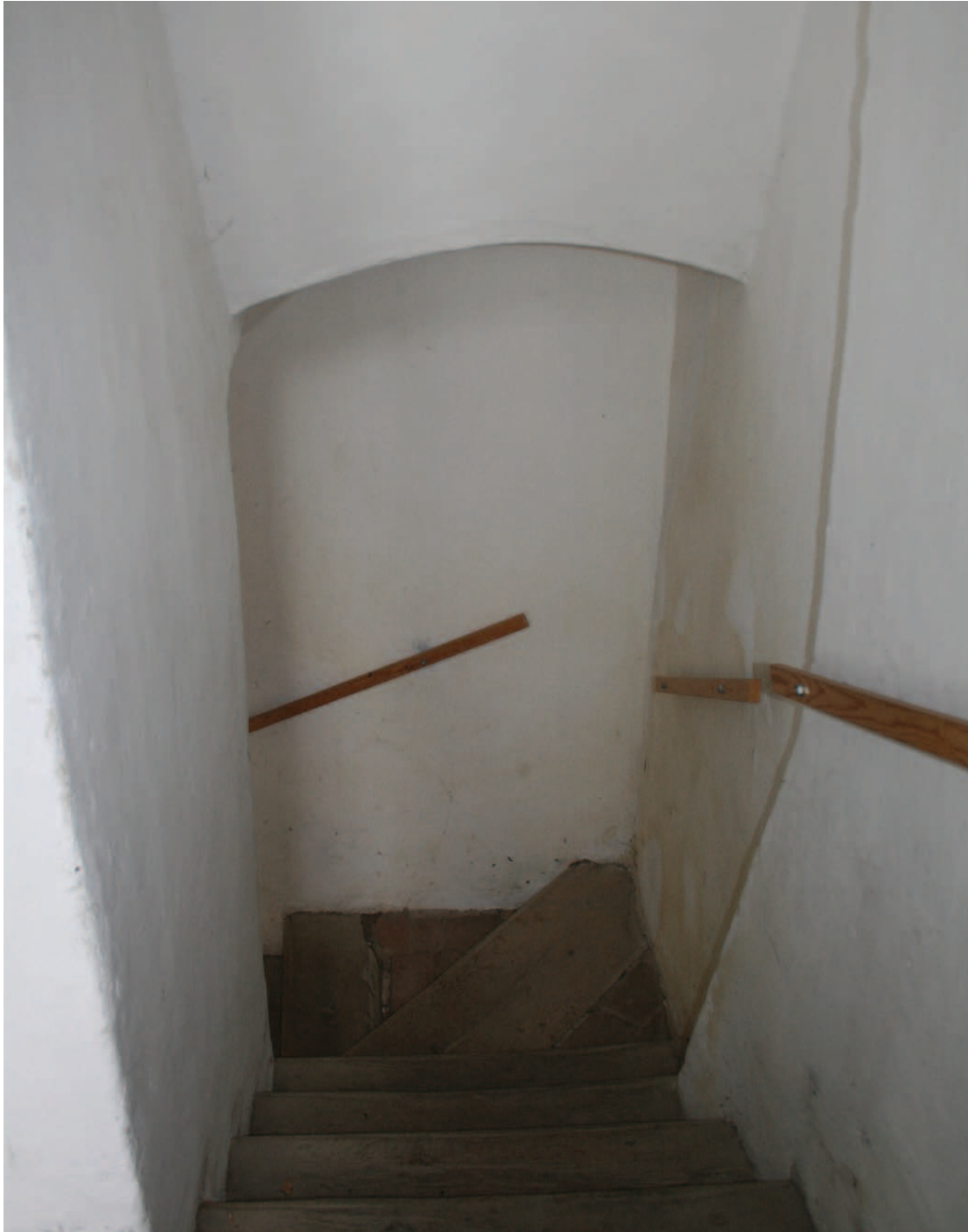
Übersicht EG.12 Blick vom OG in das Stiegenhaus, Richtung Osten
