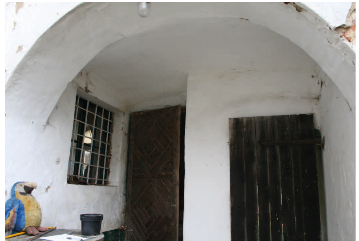
Übersicht EG.12 Blick nach Osten
