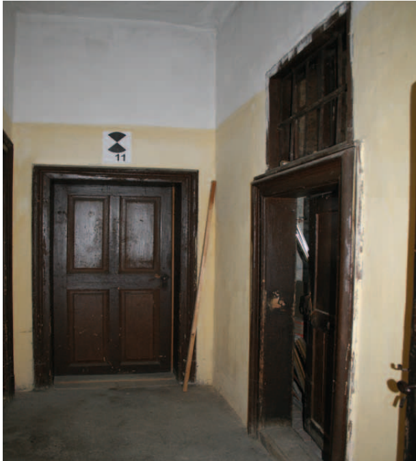
Übersicht 1.OG.21 Blick nach Nordosten
