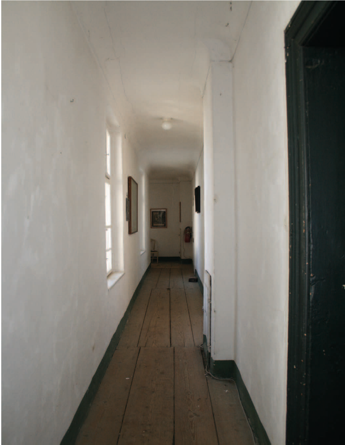
Übersicht 1.OG.01b Südwand, Blick nach Süden
