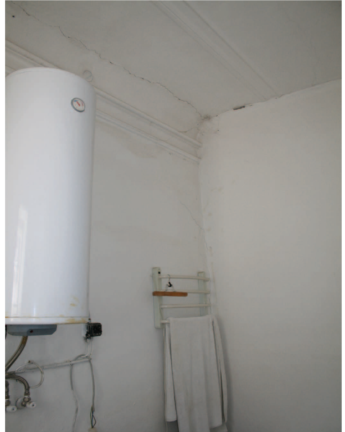
Übersicht 1.OG.08 Blick nach Nordwesten
