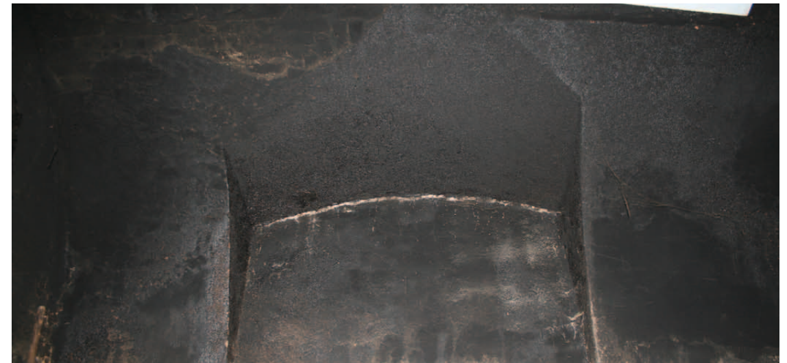
Abb.82: Rauchküche in 1.OG.29 mit zugemauerten Fenstern in Richtung Ostfassade.
