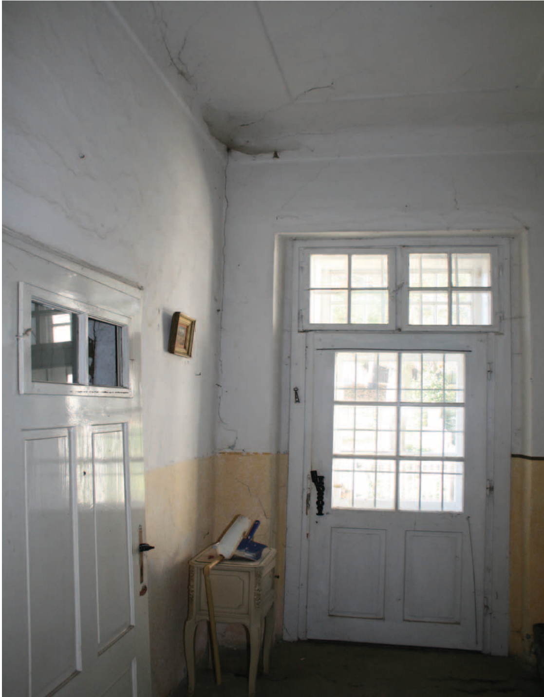
Übersicht 1.OG.16 Blick nach Nordwesten
