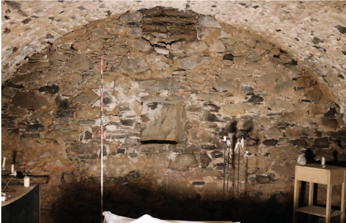
Übersicht EG.21 Blick nach Norden
