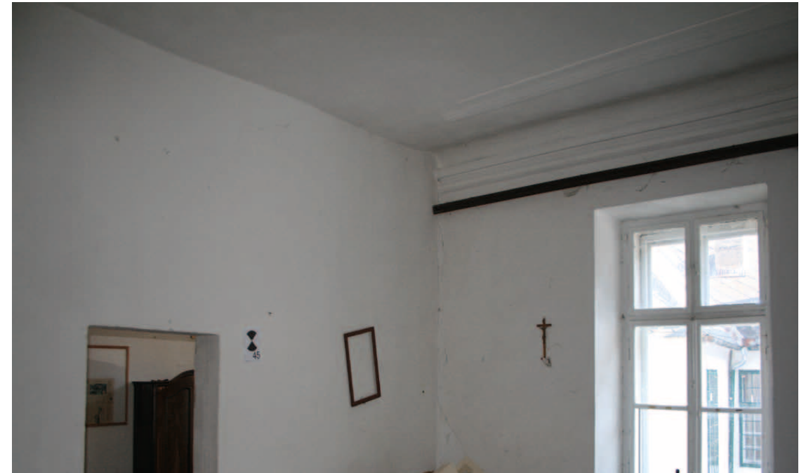
Übersicht 1.OG.18 Wandprofilierung läuft an die nachträglich angestellte Westwand
