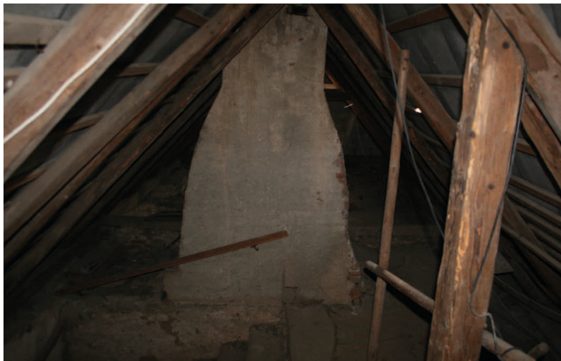
Abb.37: Dachstuhl des Osttraktes mit sekundär eingebautem Kamin über der Küche
