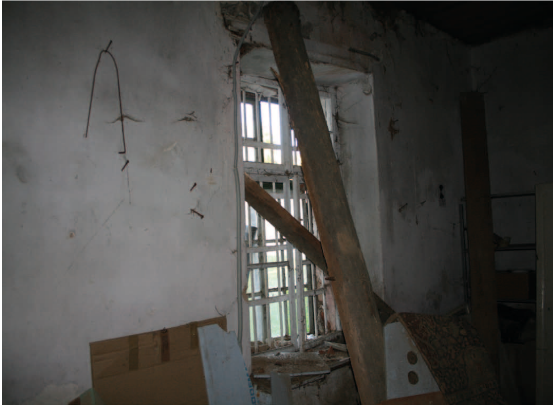
Übersicht 1.OG.25 Blick nach Nordosten
