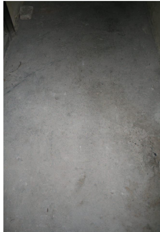
Übersicht 1.OG.21 Betonboden
