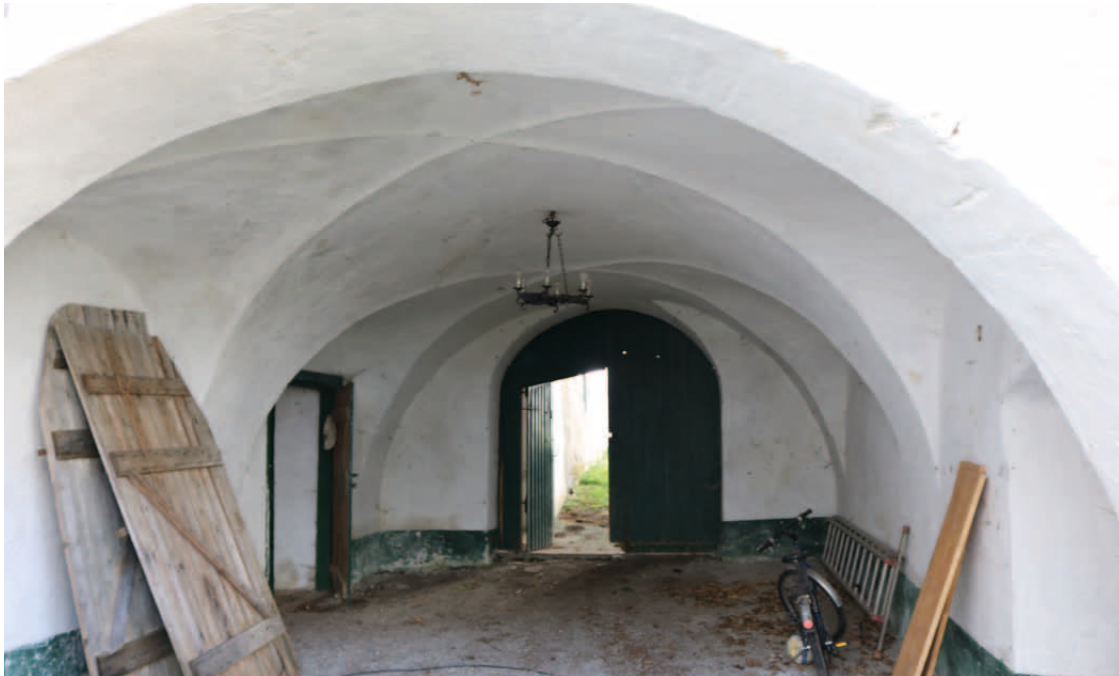
Übersicht EG.22 Blick nach Norden
