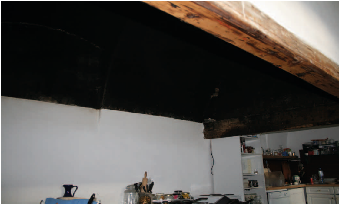
Übersicht 1.OG.29 Ostwand hinter der Rauchküche
