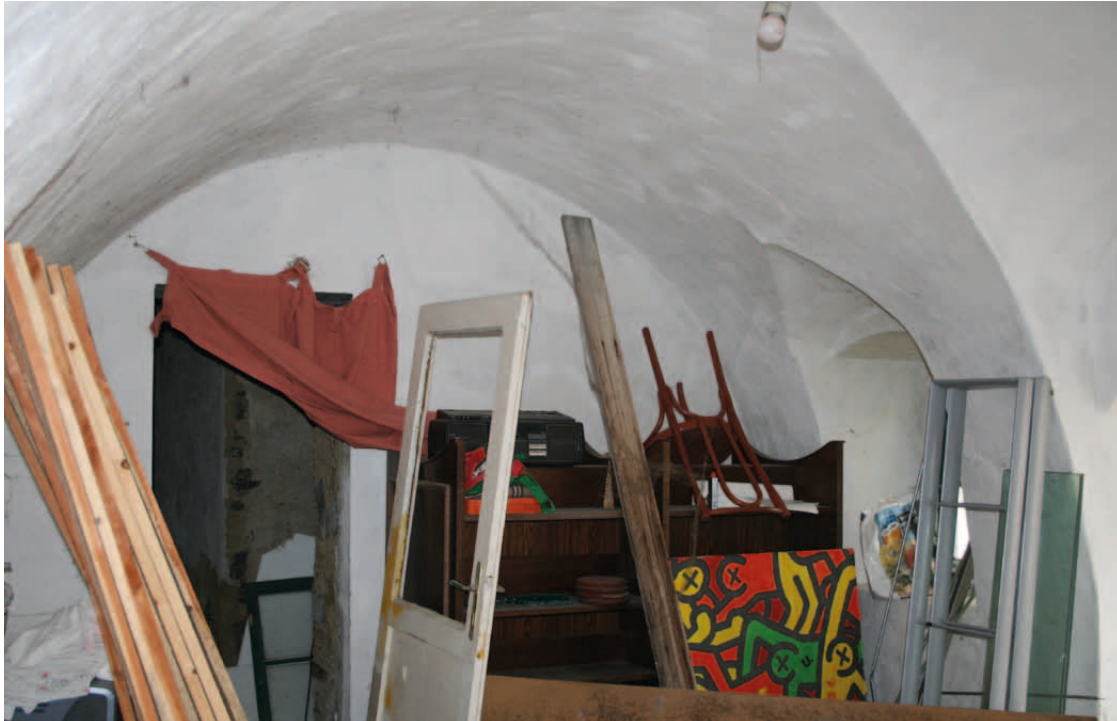
Übersicht EG.10 Blick nach Norden
