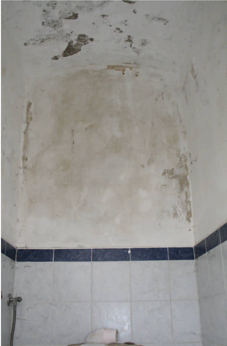
Übersicht EG.09 Blick nach Osten
