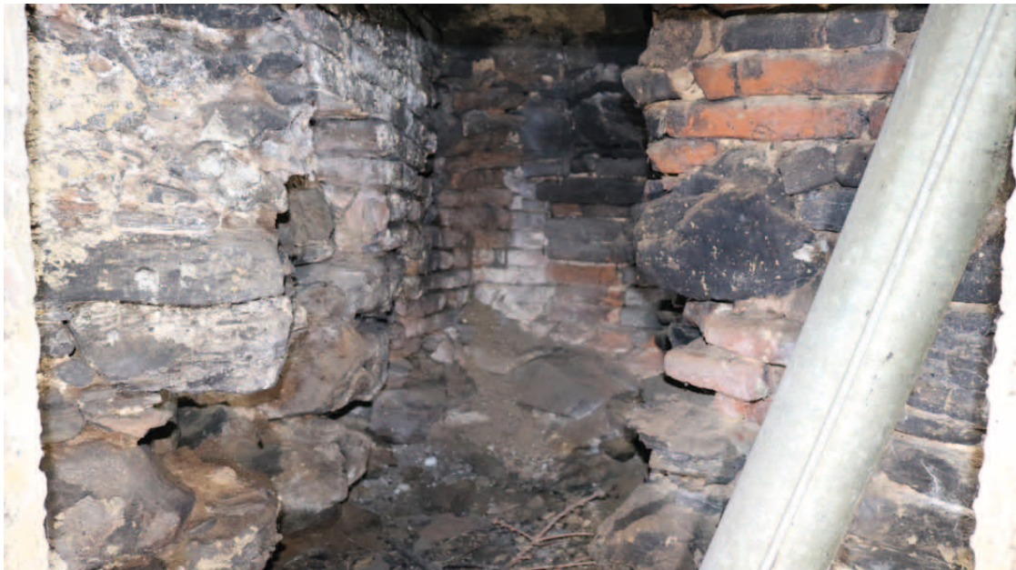
Boden EG.08 Kaminschacht
