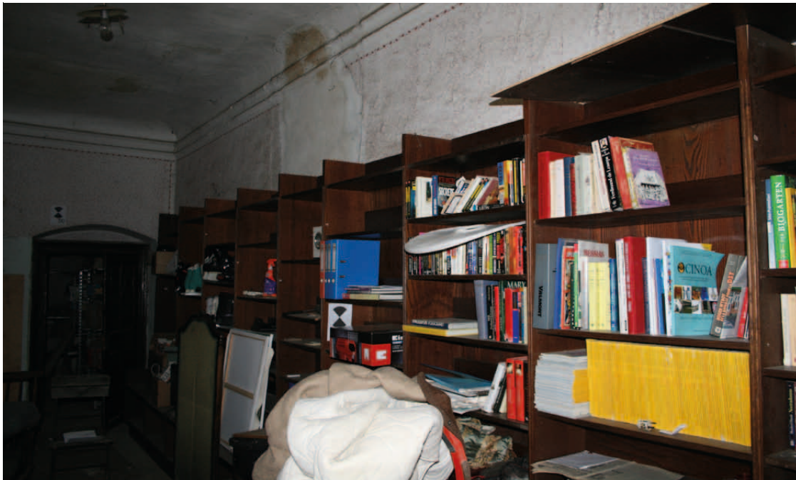
Übersicht 1.OG.26 Blick nach Nordwesten
