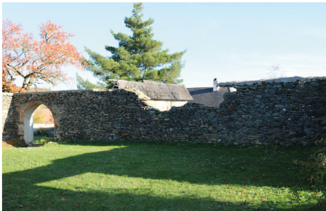
Abb.67: Noch erhaltene Mauern im Erdgeschoß des nördlichen Wirtschaftsbaus
