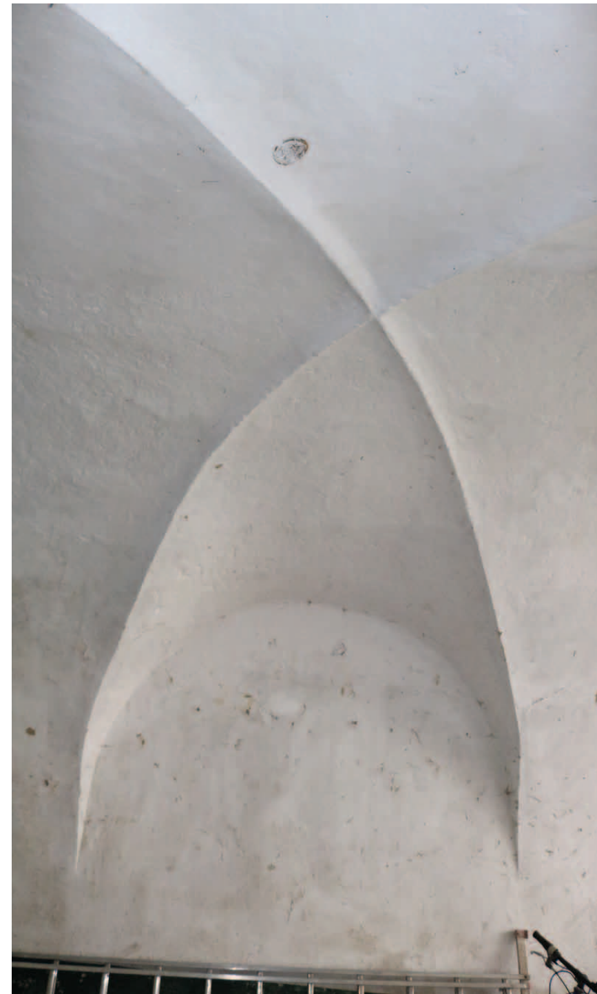
Übersicht EG.22 Kreuzgratgewölbe
