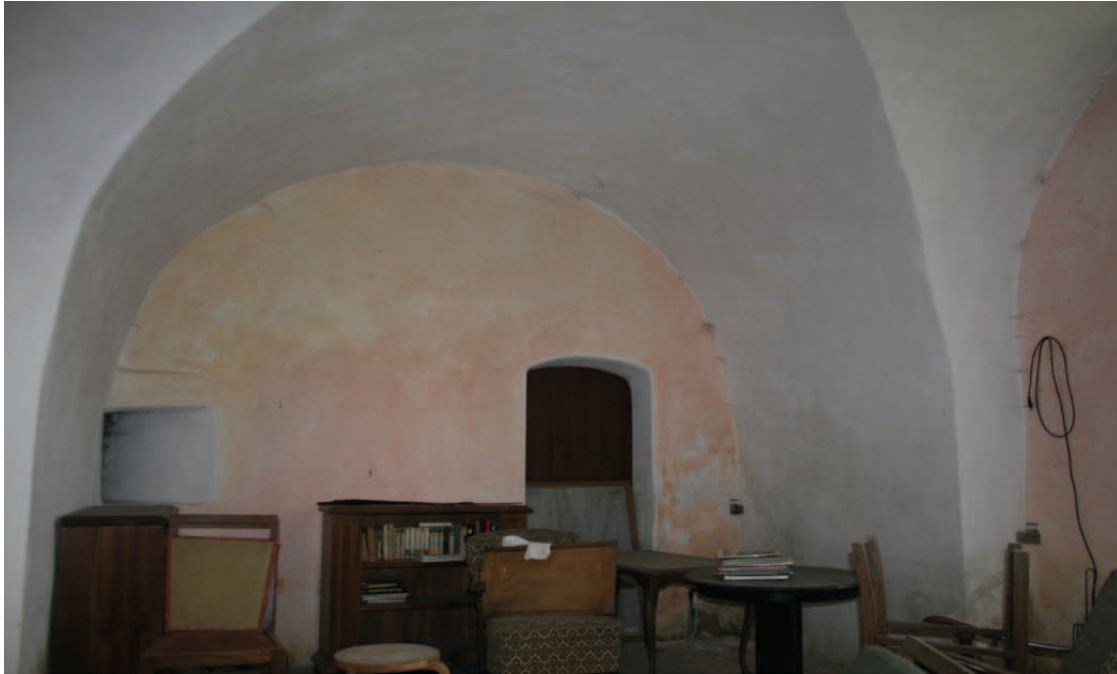
Übersicht EG.14 Blick nach Norden
