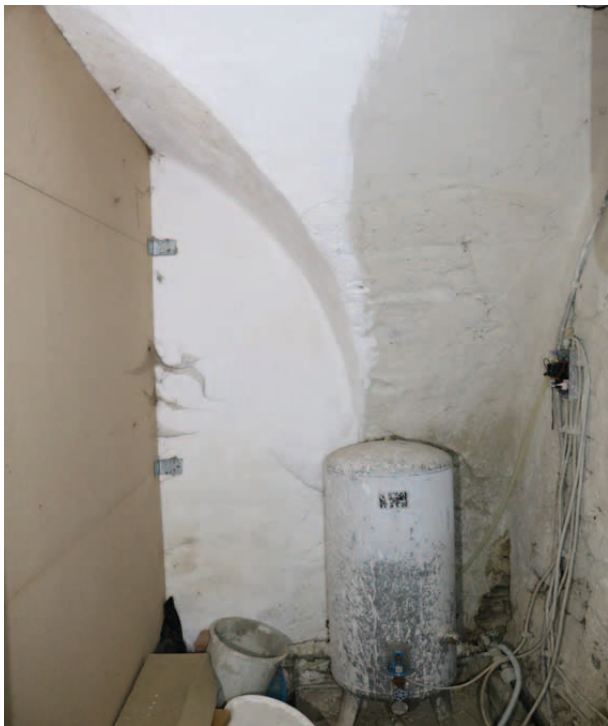
Übersicht EG.25 Blick nach Osten
