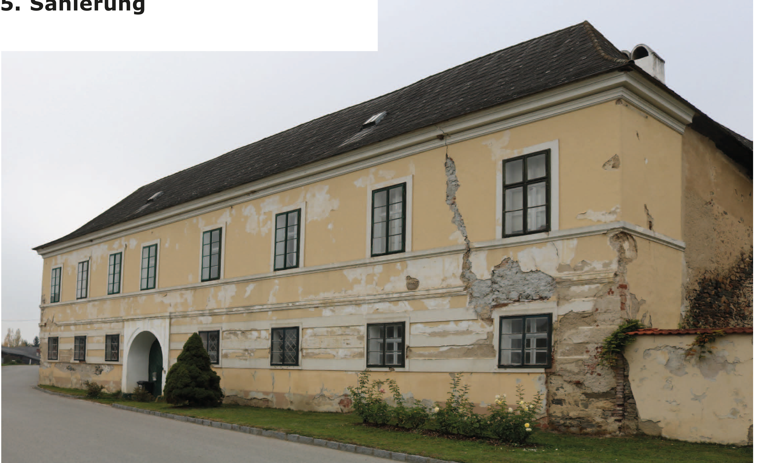
Abb.100: Foto der Südfassade des Schlosses Felling zur Zeit dieser Untersuchung
