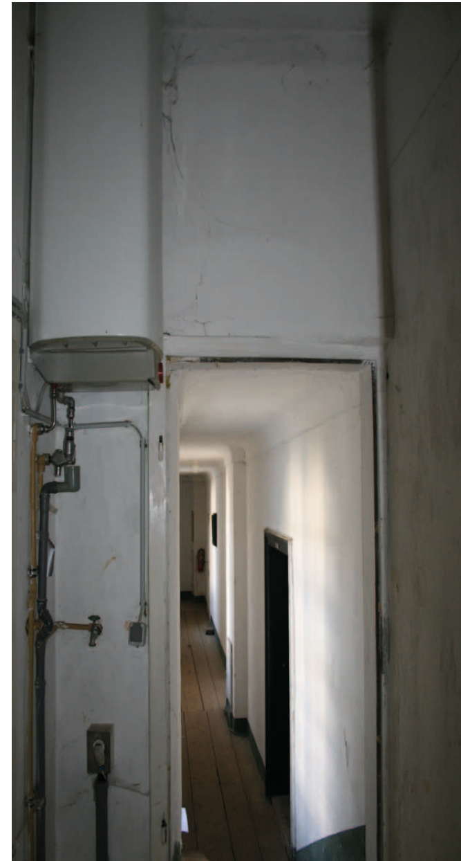
Übersicht 1.OG.13 Blick nach Süden
