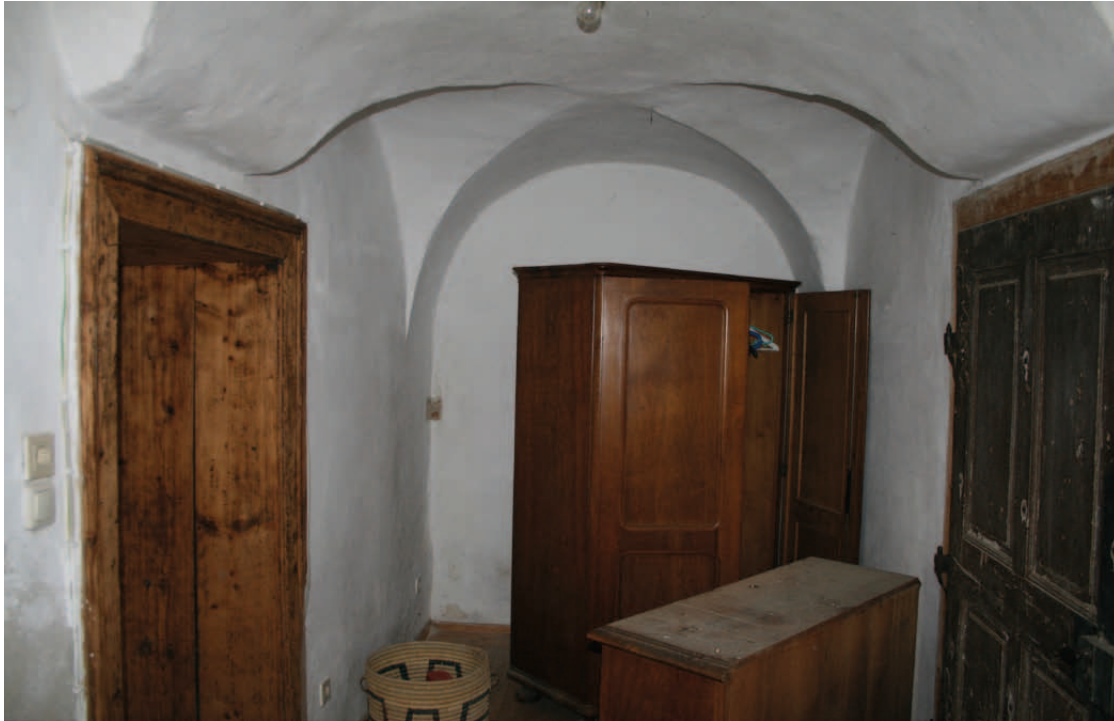
Übersicht EG.29 Blick nach Nordwesten
