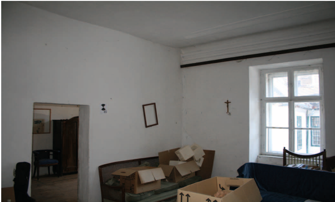
Übersicht 1.OG.17 Blick nach Südosten
