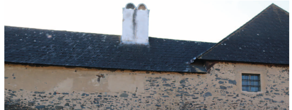
Abb.81: Ostfassade, zugemauerte Fenster sind nicht klar erkennbar.
