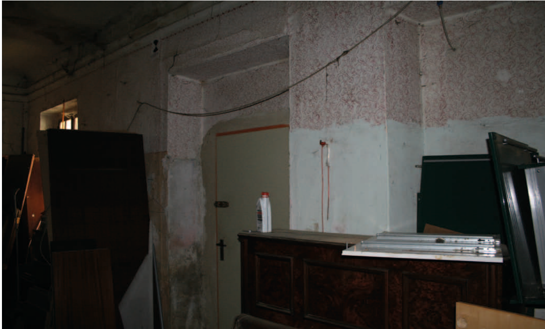
Übersicht 1.OG.26 Blick nach Südosten
