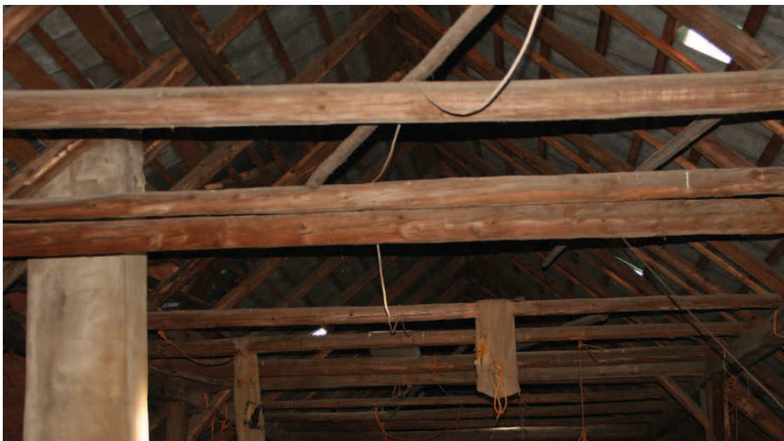
Abb.32: Dachstuhl Nordtrakt, Blick nach Westen
