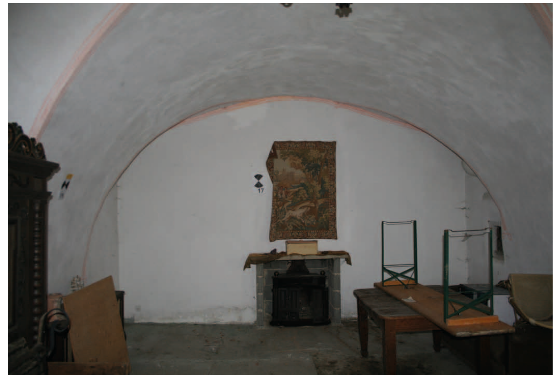
Übersicht EG.16 Blick nach Norden
