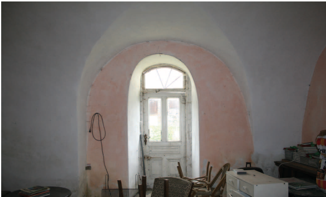
Übersicht EG.14 Blick nach Osten
