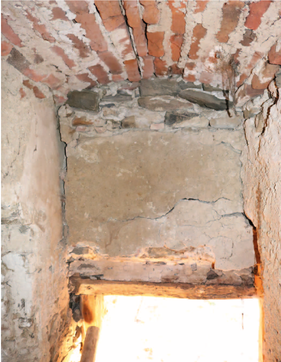
Übersicht EG.31 Blick nach Norden
