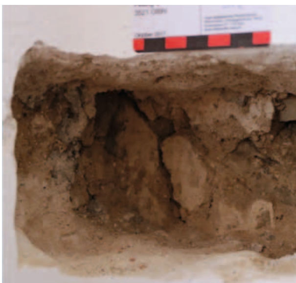
Abb.57: Untersuchungspunkt 2, EG.03, Kompartimentmauerwerk 18 cm hinter aufgestellter Ziegelschar und Putz
