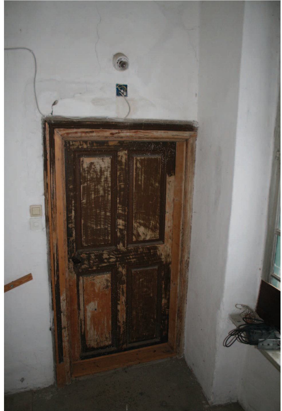
Übersicht 1.OG.28 Blick nach Süden
