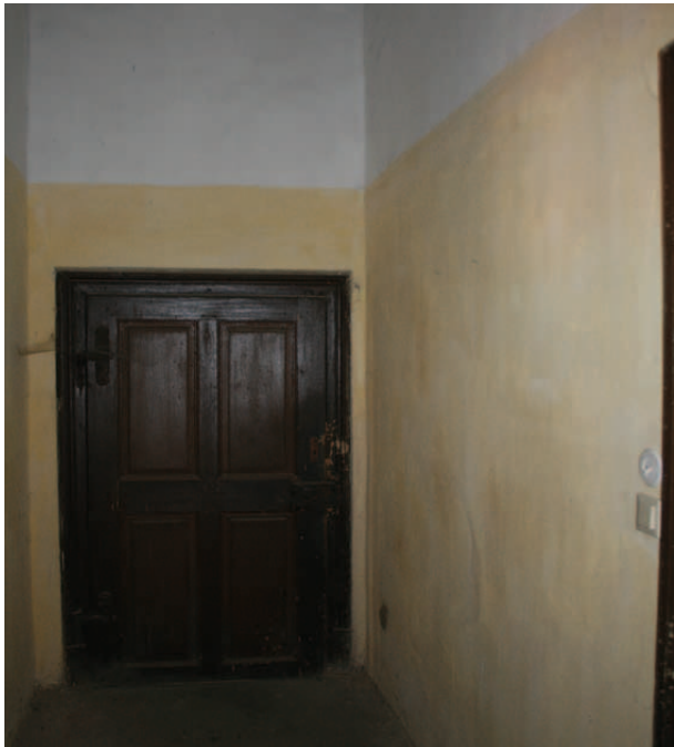
Übersicht 1.OG.21 Blick nach Südwesten
