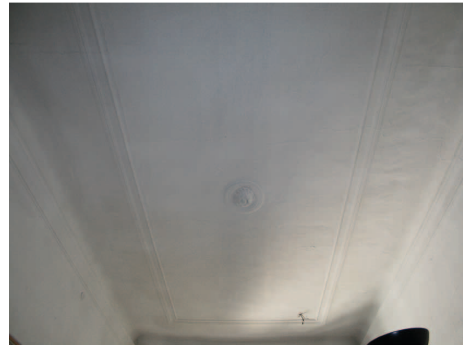
Übersicht 1.OG.20 Decke
