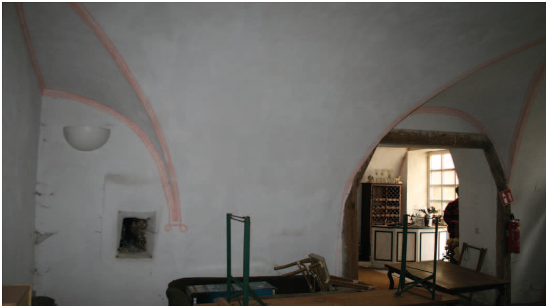
Übersicht EG.16 Blick nach Osten
