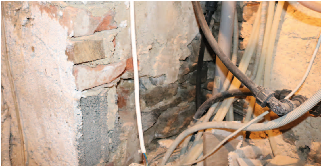
EG.11 älteres Mauerwerk wurde mit Ziegeln überbaut
