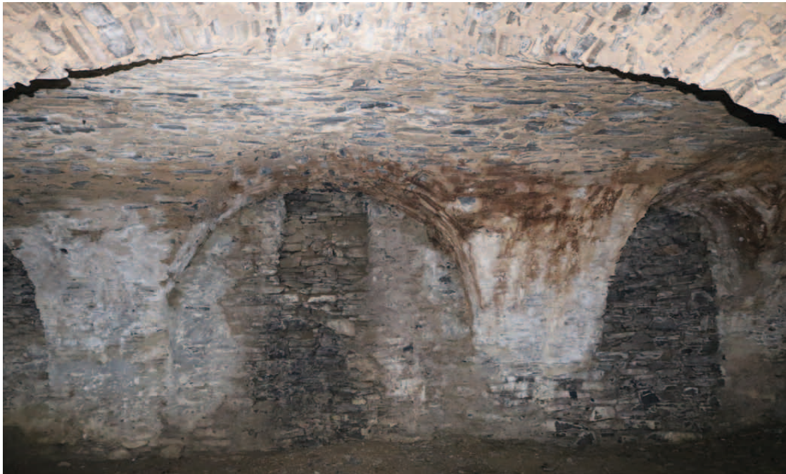
Abb.24: Wirtschaftsbau im Norden, Kellergewölbe, Blick nach Norden
