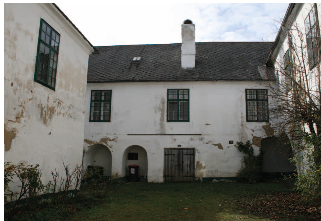
Abb.95: Innenhoffassade des Westtraktes, Aufgemauert im 19.Jahrhundert. Am Nordtrakt (rechts am Bild) konnten keine Abbruchspuren eines ehemaligen Ganges im Obergeschoß festgestellt werden
