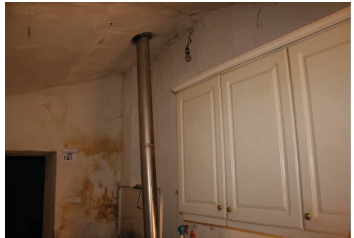
Übersicht EG.18 Blick nach Nordwesten
