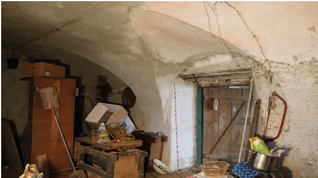
Übersicht EG.23 Blick nach Osten
