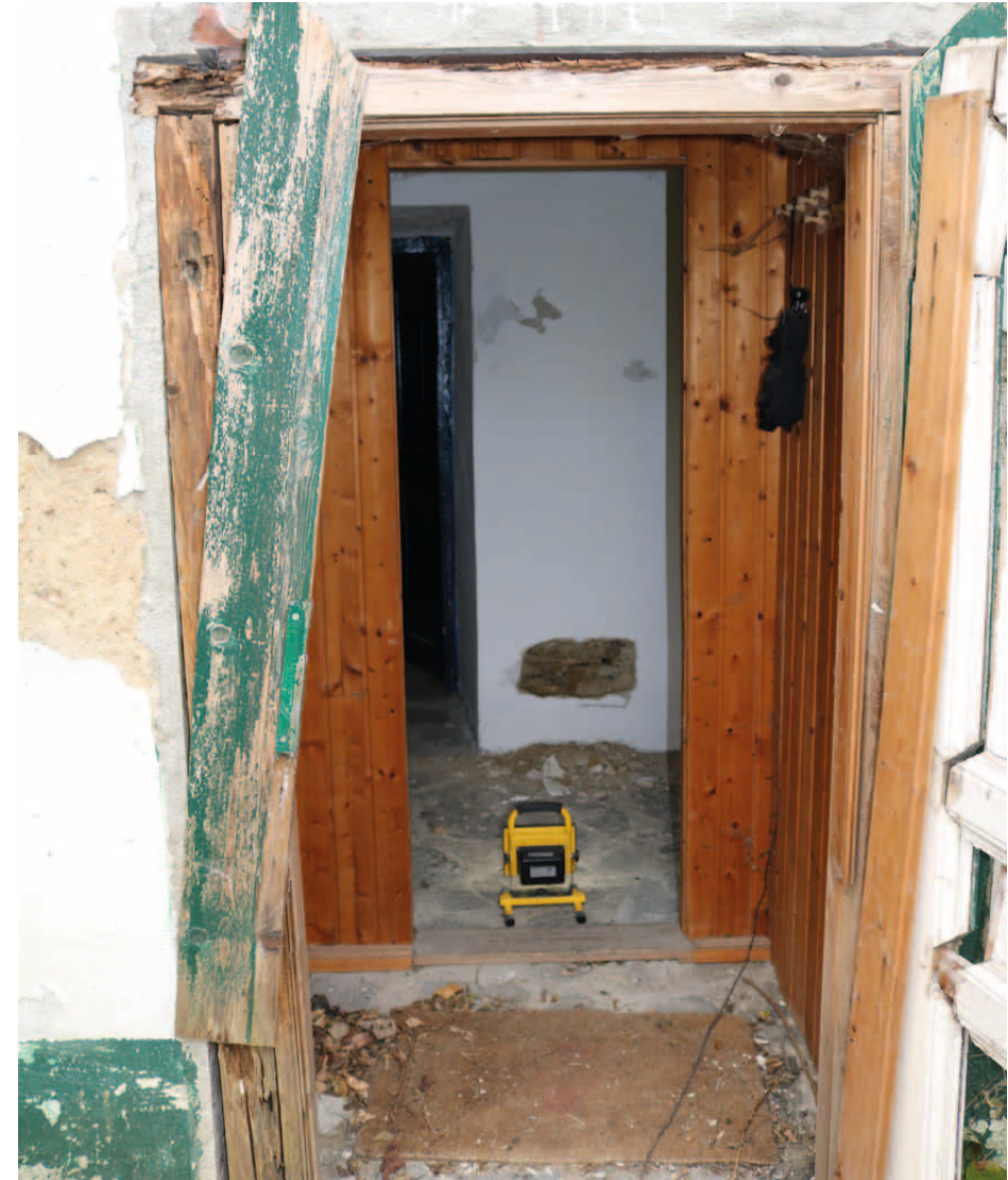
EG.07 Zugang vom Innenhof
