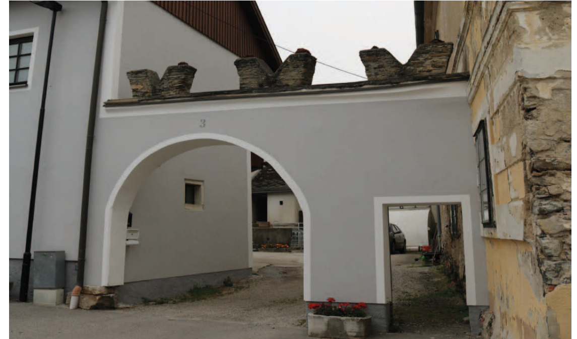
Abb.14: Wirtschaftsbau im Norden, Wandreste im EG, Blick nach Osten
