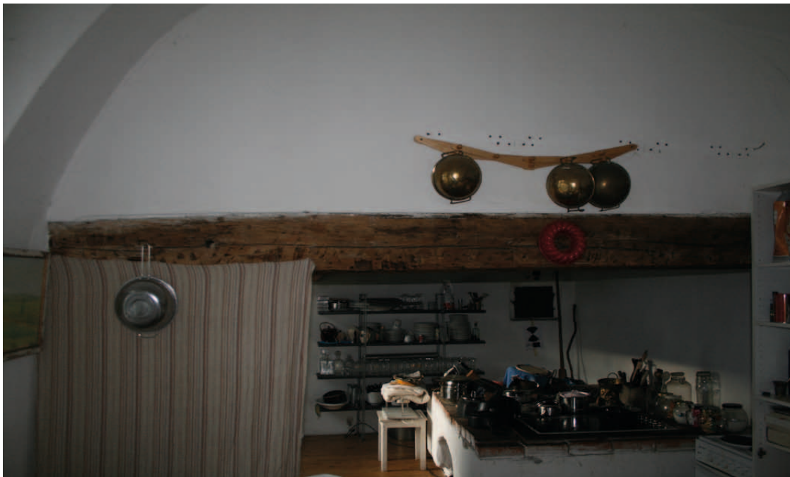
Übersicht 1.OG.29 Nordwand vor der Rauchküche
