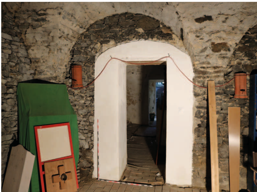
EG.20 Blick nach Osten, Durchgang zu EG.19
