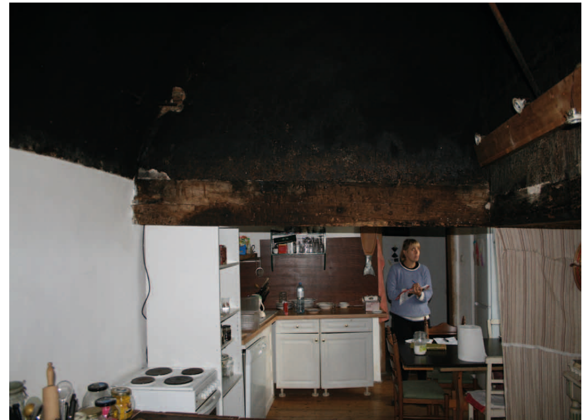
Übersicht 1.OG.29 Südwand vor der Rauchküche
