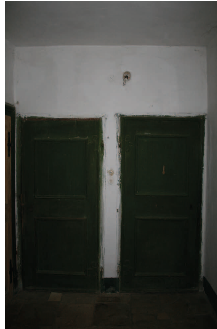
Übersicht 1.OG.30a Blick nach Osten
