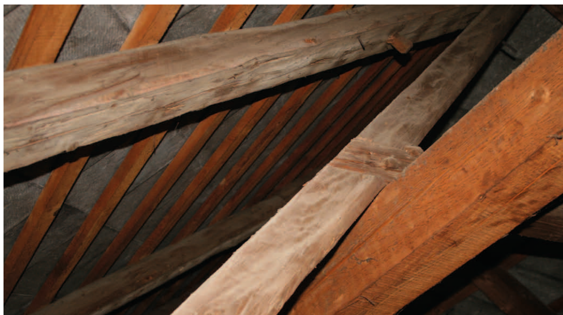
Abb.27: sekundäre Tragkonstruktion trägt direkt die primäre
