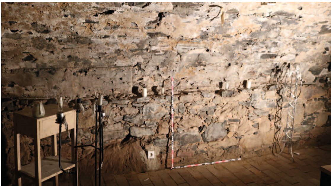
Übersicht EG.21 Blick nach Osten
