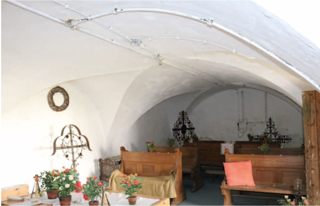
Übersicht EG.24 Blick nach Norden
