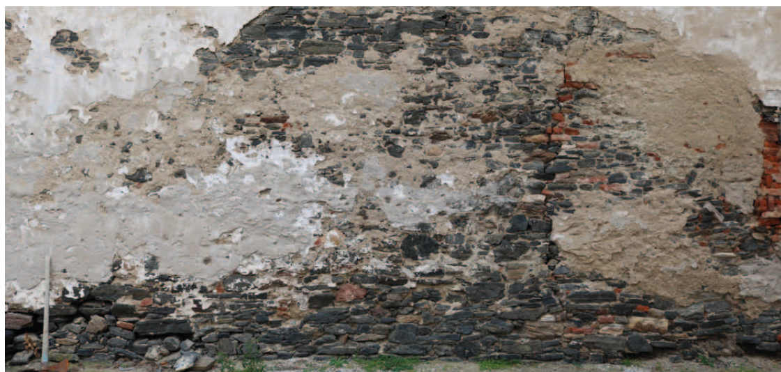
Abb.60: Westfassade, Detailfoto Netzmauerwerk
