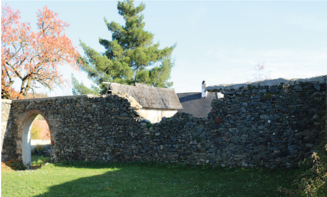
Abb.12: Wirtschaftsbau im Norden, Wandreste im EG, Blick nach Süden
