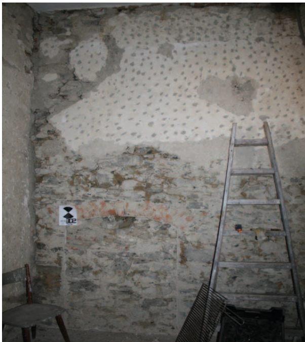
Übersicht 1.OG.22 Südwand
