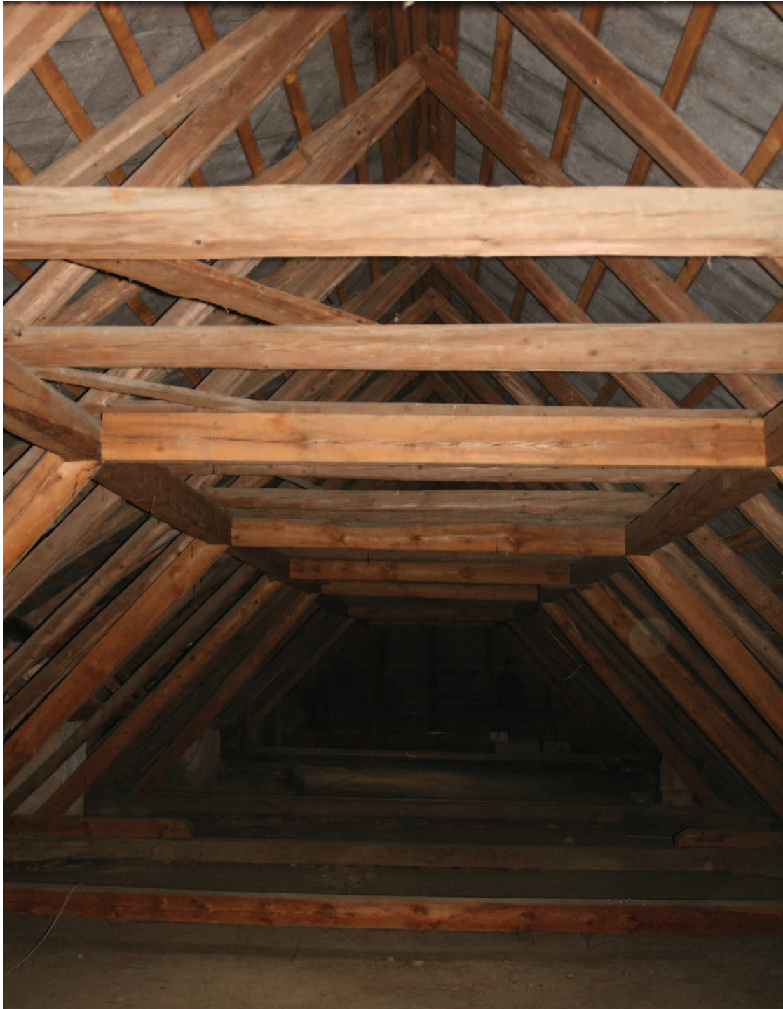
Abb.26: Dachstuhl Südtrakt, Blick nach Osten, primäres und sekundäres Tragwerk erkennbar
