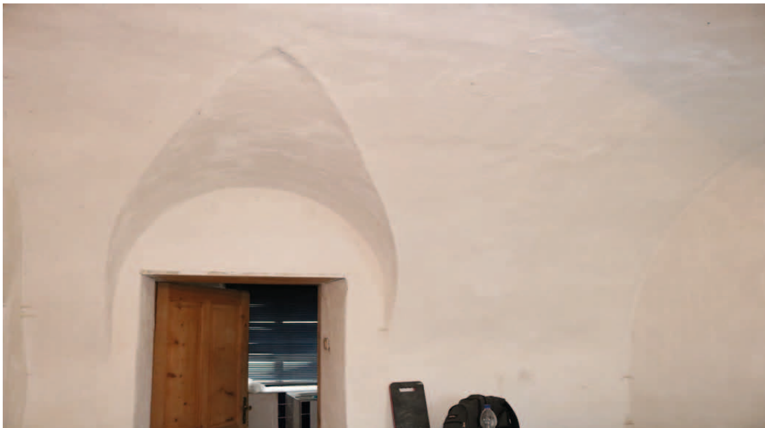
Übersicht EG.26 Blick nach Osten
