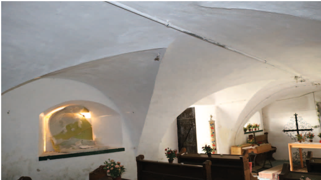
Übersicht EG.24 Blick nach Osten
