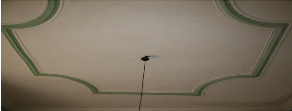
Übersicht 1.OG.10 Decke
