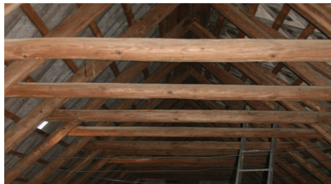
Abb.31: Dachstuhl Westtrakt, mit Blick in Richtung Norden
