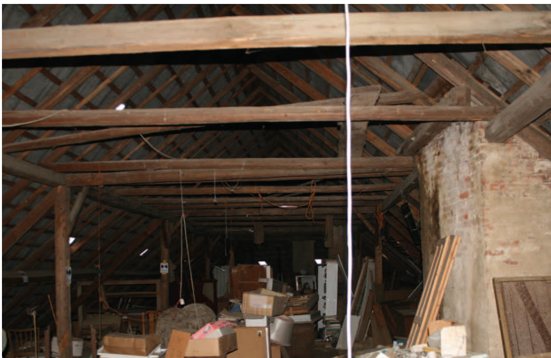
Abb.33: Dachstuhl Nordtrakt, Blick nach Osten
