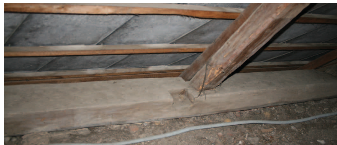
Abb.39: westlicher Fußpunkt mit Ausnehmung in der Bundtram, möglicherweise für einen vorherigen Bundtram
