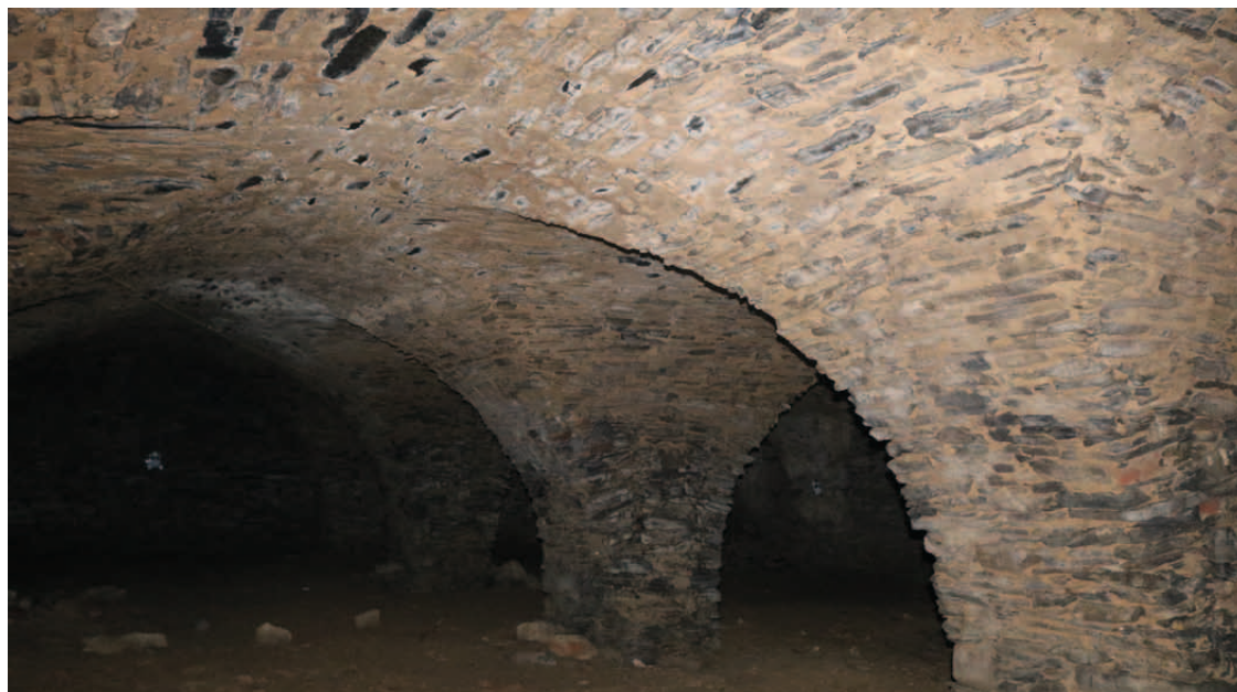
Abb.66: Kellergewölbe des nördlichen Wirtschaftsbaus, Blick von der Stiege aus nach Nordwesten
