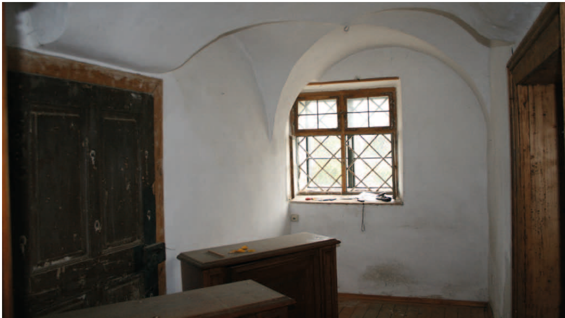
Übersicht EG.29 Blick nach Südosten
