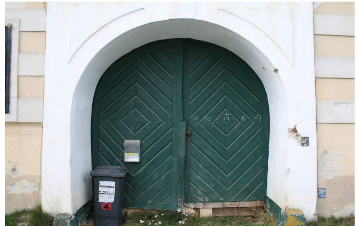
EG.30 Einfahrtstor von außen, Südfassade
