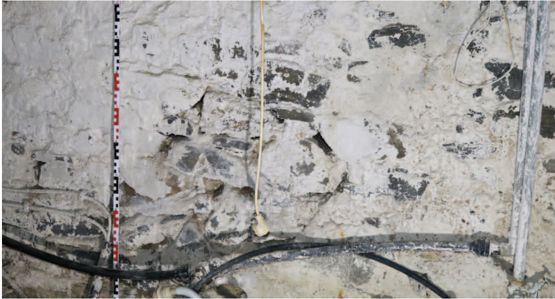
Übersicht EG.25 Blick nach Norden
