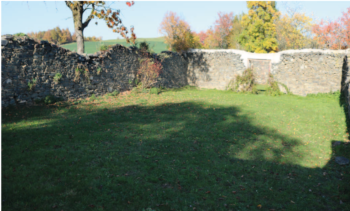
Abb.13: Wirtschaftsbau im Norden, Wandreste im EG, Blick nach Osten
