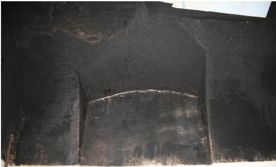
Übersicht 1.OG.29 Ostwand, verschlossenes Fenster
