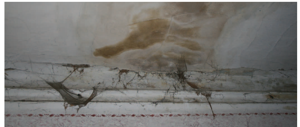
Abb.102: Detailaufnahme der Decke in 1.OG.26
