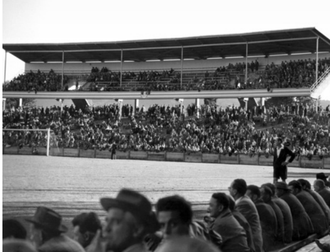
Abb. 2.5.2 Blick auf die in den 50er Jahren erstellte Tremli-Tribüne des Hardturmstadions. (KEYSTONE/Walter Scheiwiler)
