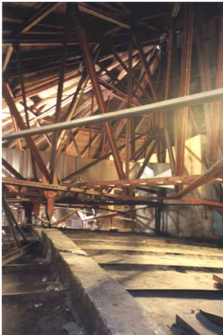
Abbildung 54 Stahlfachwerk als Tragkonstruktion des Dachs über dem Auditorium. Nach unten ist die Monierdecke des Zuschauerraums über Stahlstangen punktweise abgehängt.
