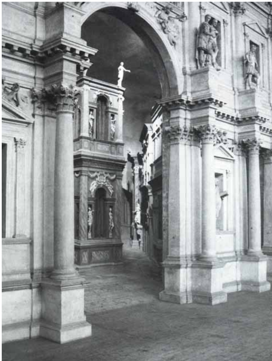
Abbildung 22 Eine der Bühnengassen im Teatro Olimpico in Vicenza. Durch den nach hinten stark ansteigenden Bühnenboden sollte eine größere Tiefenerstreckung vorgetäuscht werden.
