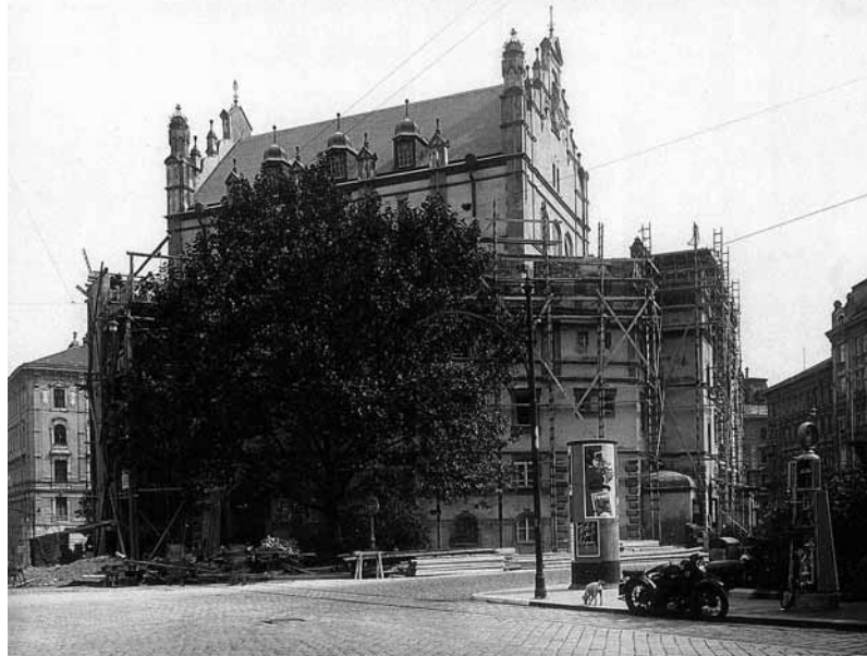
Abbildung 35 Beginn der Um- und Aufbauten. Erste Aufstockungen über der Hinterbühne
