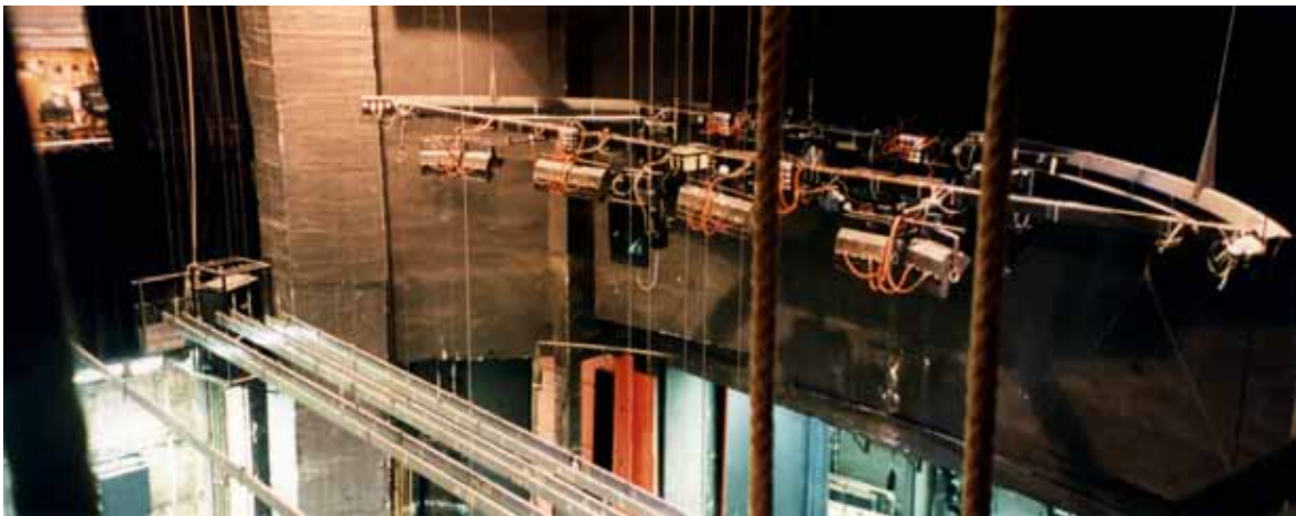
Abbildung 50 Der Prospektzug für den Raffhorizont / Abschlussprospekt des Bühnenbilds
