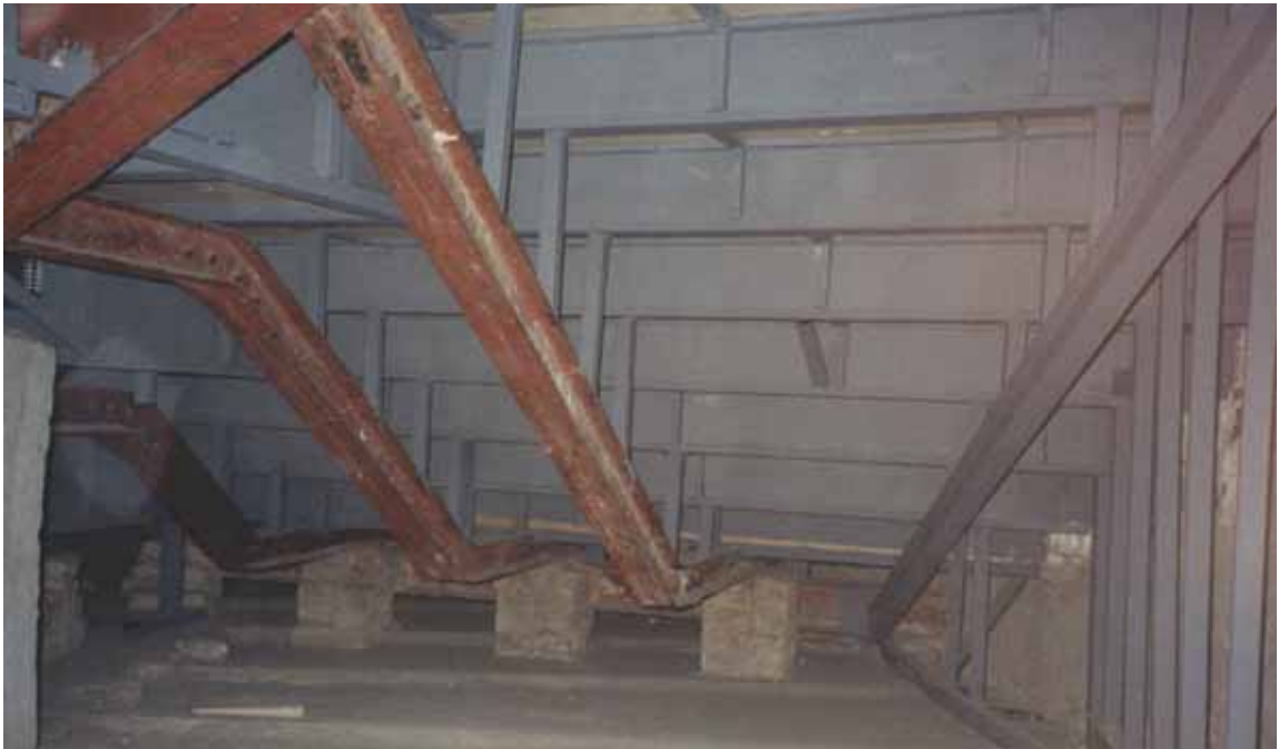
Abbildung 56 Unterbau der Galerien
