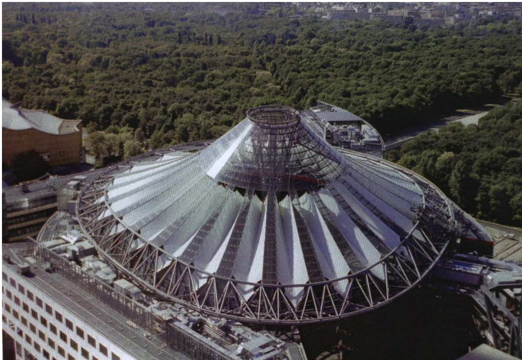
Abb.15.30: Außenansicht des Daches im Endzustand; aus /14/
