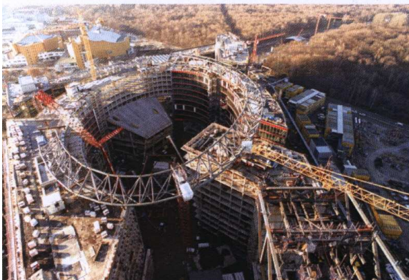
Abb.15.21: Ring in der Bauphase; aus /14/
