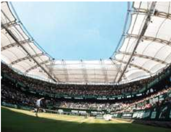
Abb.10.4: Innenansicht des Center-Court in Halle; aus /26/
