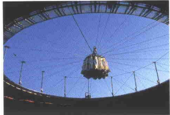
Abb.15.4: Inneres Speichenrad(mit mobiler Dachhaut); aus /7/
