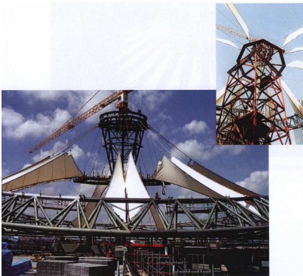
Abb.15.24: Montage der Membrane; aus /14/
