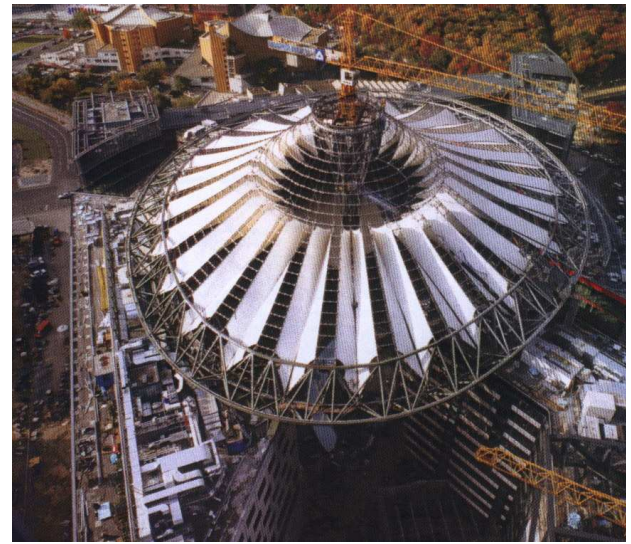
Abb.15.25: Abgeschlossene Montage der Membrane; aus /14/
