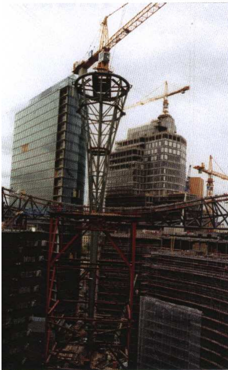
Abb.15.23: Zwei Ansichten des Krans auf dem zentralen Mast: aus /14/
