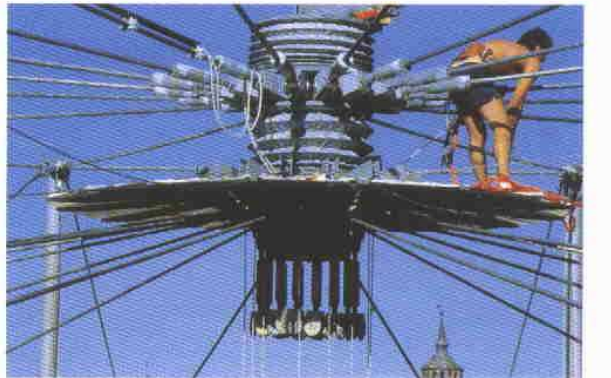
Abb.6.3: Innerer Knotenpunkt der Überdachung der Arena von Zaragoza aus /7/
