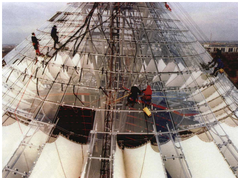
Abb.14.28: Glasmontage im steilen Bereich des Daches; aus /14/
