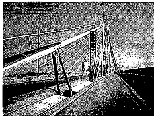
Abb. 1.6: Schwingungsdämpfer bei der Erasmusbrücke
