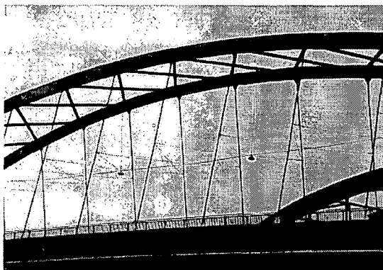
Abb. 6.17: Störseile bei der Nordbrücke B1 in Magdeburg
