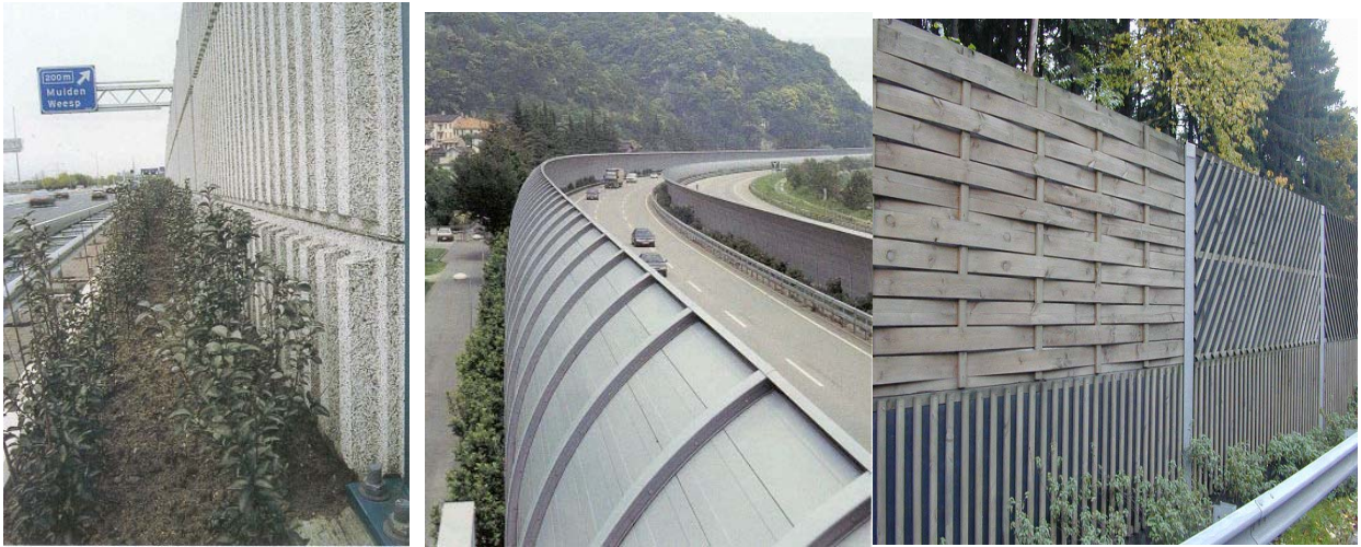
Abb. 6-7 Lärmschutzwände (v.li. Beton, Aluminium und Holz)
