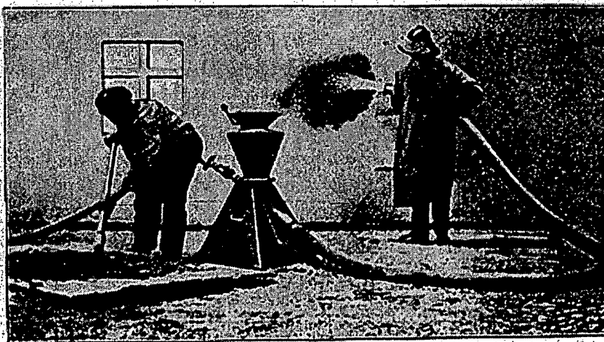
Abbildung 11: Mörtelspritzmaschine – Bauart Moser-Kraftbau aus dem Jahr 1918 [25]
