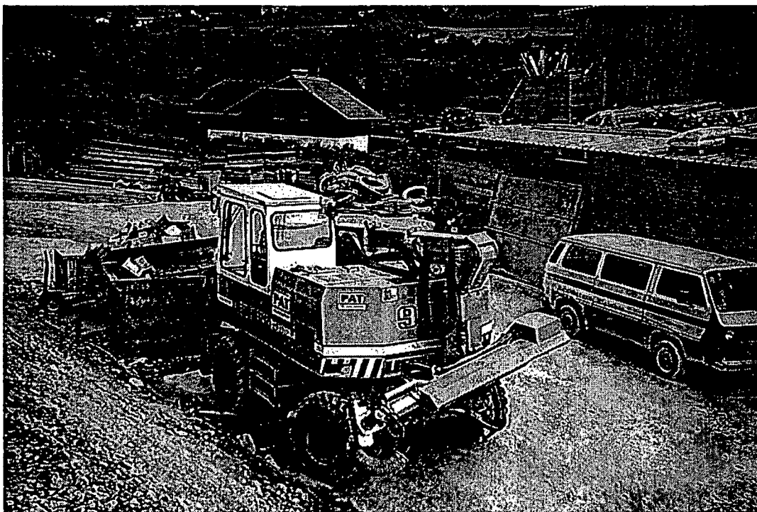
Abbildung 44: Spritzmobil [Fotoarchiv Institut für Baubetrieb und Bauwirtschaft an der TU - Wien]
