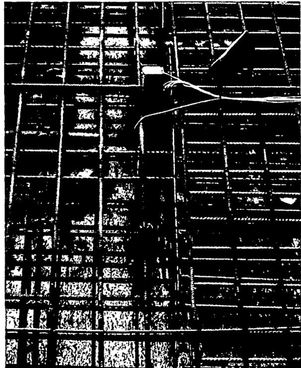
Abbildung 11-2: Einbau einer Thermosonde in die Schalung (bestehend aus 10 Thermoelementen)
