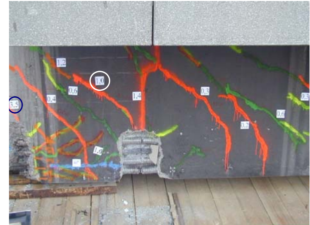
Bild 5.18 Rissbild der Segmente 7 und 8, Seite Wien, nach dem 10. Versuch
