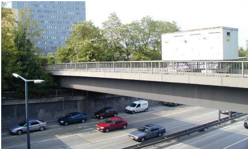
Bild 1.1 Ansicht der PORR Brücke
