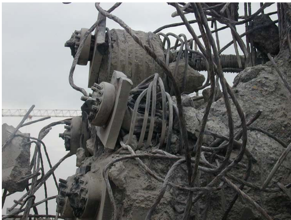
Bild 4.4 Verankerungen mit Wendelbewehrung, Steg Seite Wien
