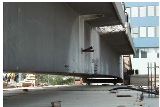
Bild 3.3 Abgesenktes Tragwerk und Sicherungsmaßnahmen
