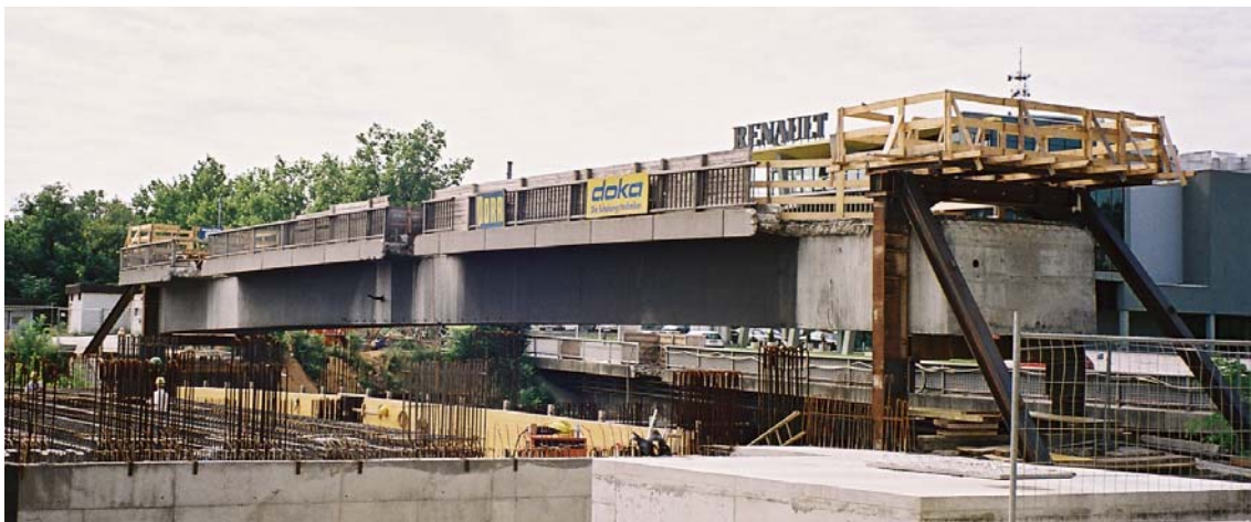
Bild 3.1 Brücke nach dem Anheben
