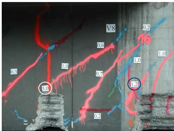
Bild 5.12 Rissbild der Segmente 7 und 8, Seite Graz, nach dem 8. Versuch
