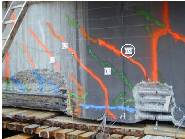
Bild 5.16 Rissbild der Segmente 7 und 8, Seite Wien, nach dem 7. Versuch
