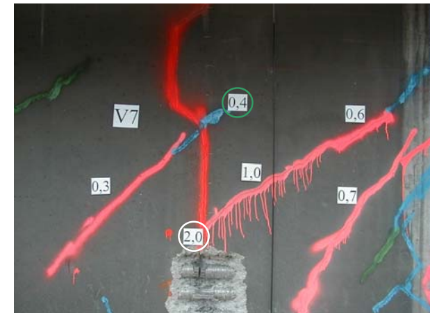
Bild 5.15 Rissbild der Segmente 7 und 8, Seite Graz, nach dem 7. Versuch
