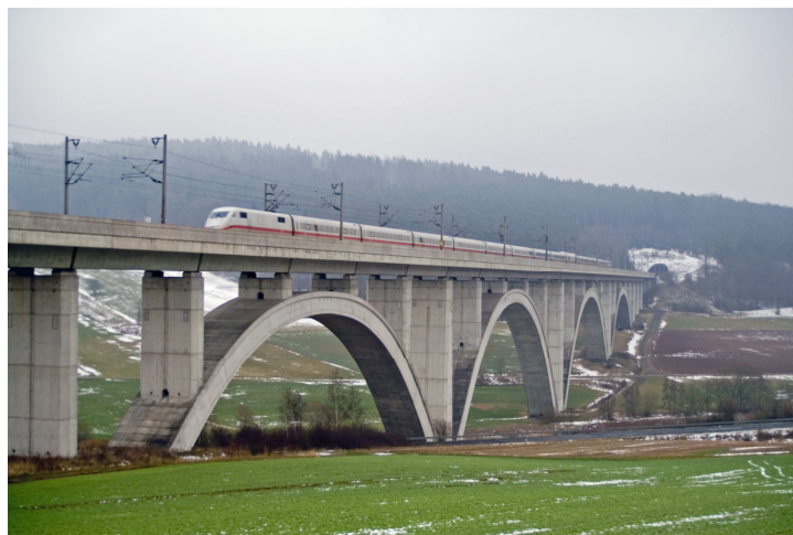
Abb.15: Wälsbachtalbrücke Ausbaustrecke: Hannover-Würzburg 46
