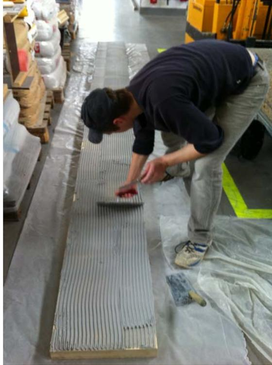
Abbildung 4.32: Auftragen des Klebefilms mit der Zahnschachtel
