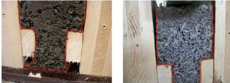
Abbildung 3.5: Stellen mit schlechter Verdichtung und Fugen aus Schwinden des Holzbetons [19]
