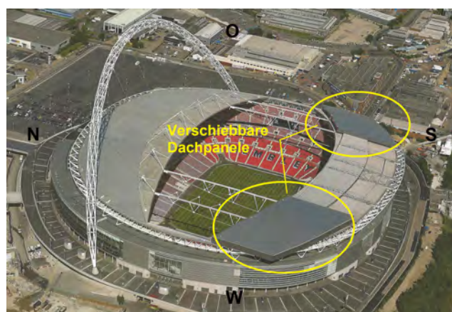
Abb. 3.26: Übersicht des Daches [41, S. 155]
