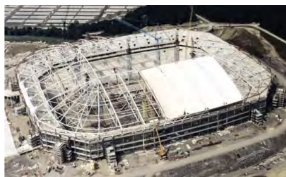
Abb. 3.8: Fertiggestelltes Dachtragwerk [17, S. 213]
