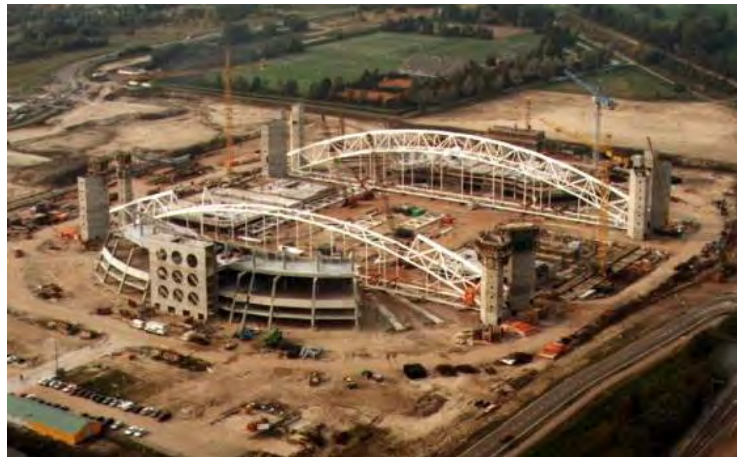
Abb. 3.18: Montage der Dachkonstruktion [32]
