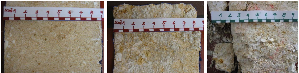
Abbildung 2-8: visuelle Zustandsbeurteilung des Gesteinsgefüges nach Verwitterungssimulationen. Li: Sumpfkalkbeschichtung – keine Zerstörung der Gesteinssubstanz nach Verwitterungssimulationen, Mitte: Silikonharzbeschichtung – große Zerstörung vor allem der oberen Gesteinsschichte nach Salzkristallisationsuntersuchungen, Re: Beschichtung auf Basis Nanotechnologie – Sprengung des Gesteinsgefüges nach Frost-Tauwechselfersuchen 135
