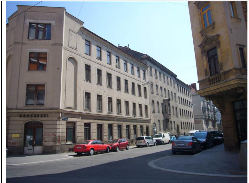
Abb. 24: 1150 Wien Künstlergasse – vor der Sanierung (Foto: Brandl)
