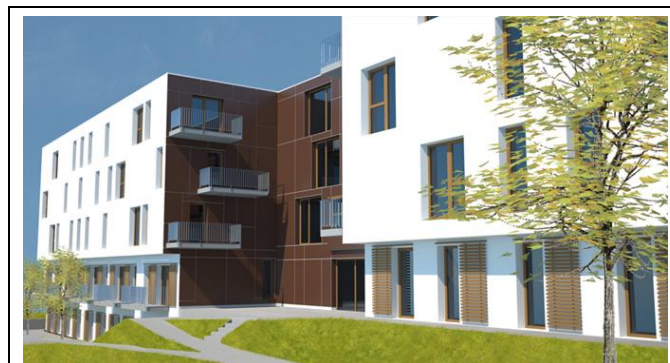
Abb. 17: Frauenwohnprojekt „rosa“, 1220 Wien, A.-Sattlergasse (Quelle: Architekten Koeb & Pollak, Wohnbauvereinigung wbv-gpa)
