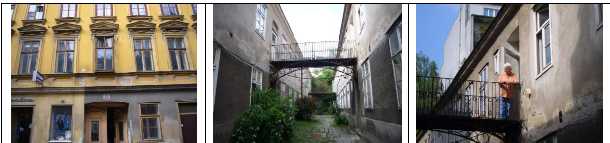
Abb. 23: Wohnprojekt, 1160 Wien Grundsteingasse – vor der Sanierung (Fotos: Brandl)
