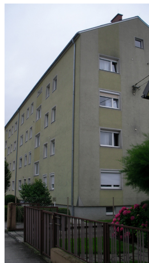
Abb. 014: Wohnbau bei „alter Säge“ (#01)
