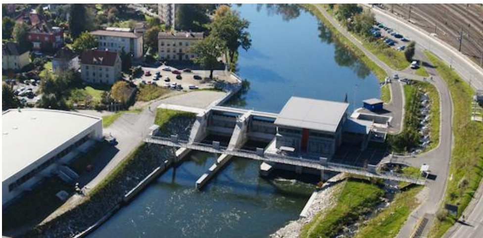
Abbildung 2.12: Laufkraftwerk in Leoben an der Mur mit einer Leistung von 10MW. [VER12]
