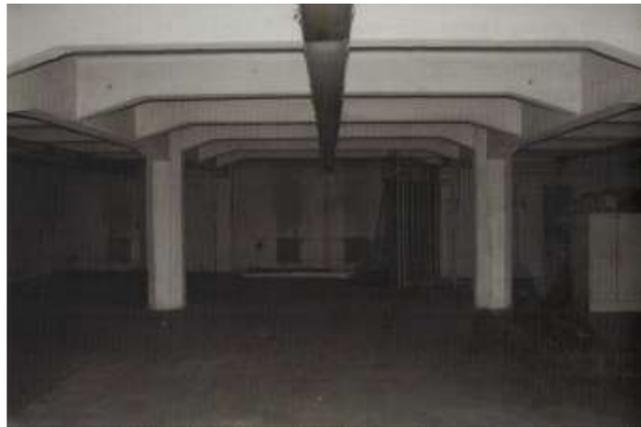
Abb. 117 Eisenbetonkonstruktion im Lagerhaus (erbaut 1922)
