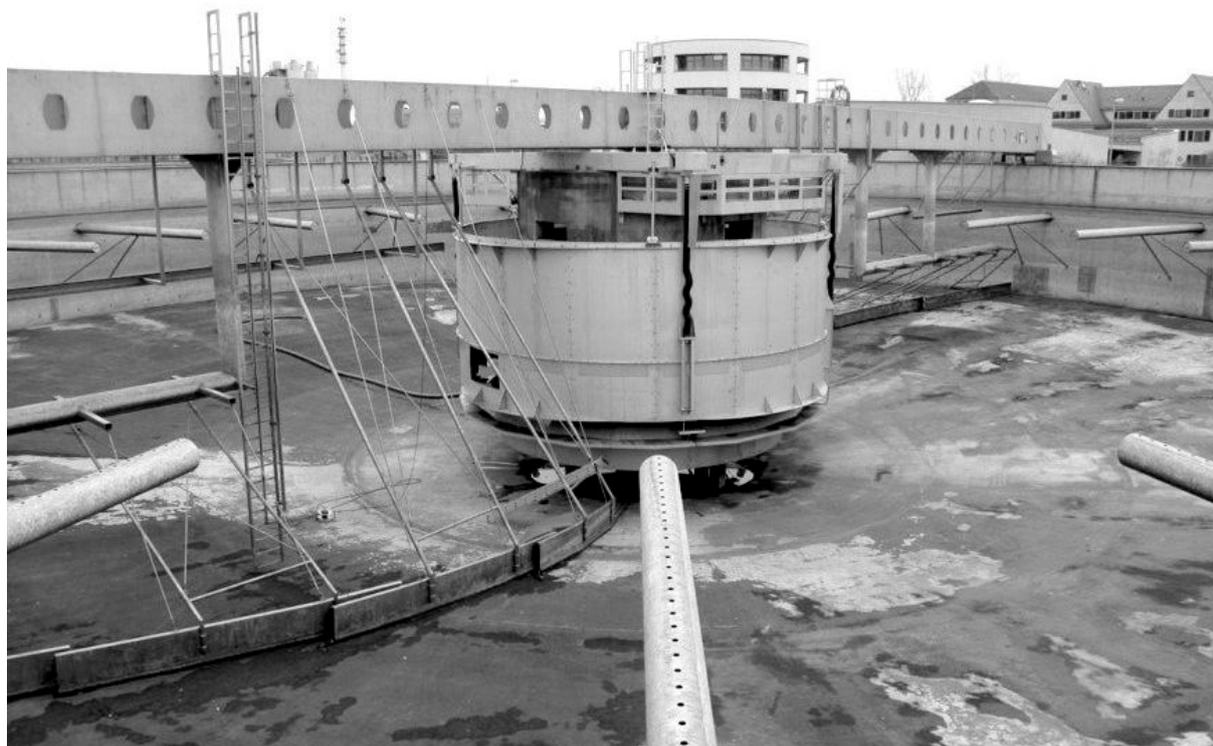
Abbildung 8: Höhenverstellbares Einlaufbauwerk ('hydrograv adapt') an einem NKB
