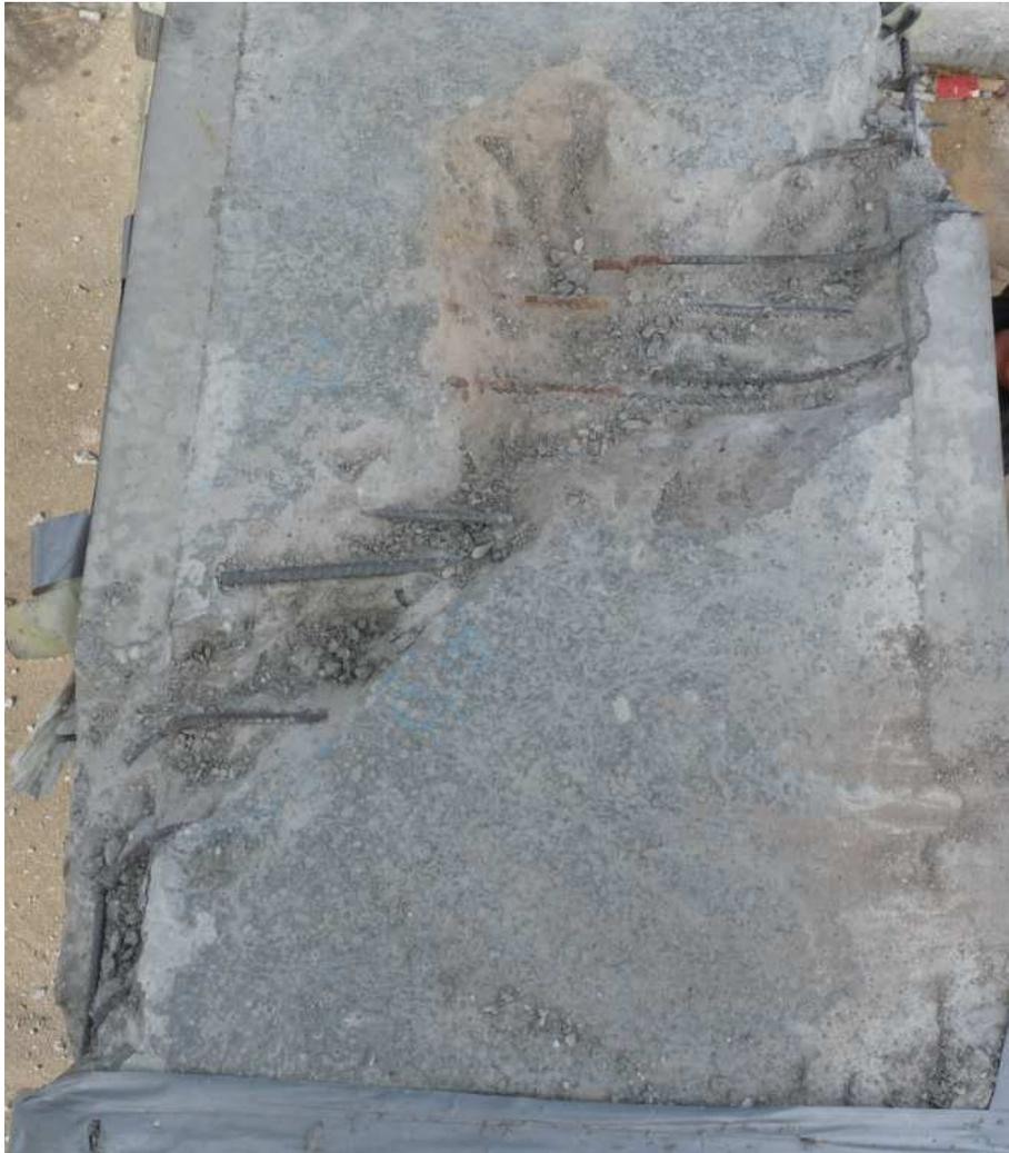
**Abbildung 141: Freigelegte Bewehrung im Bereich des Bruches**
