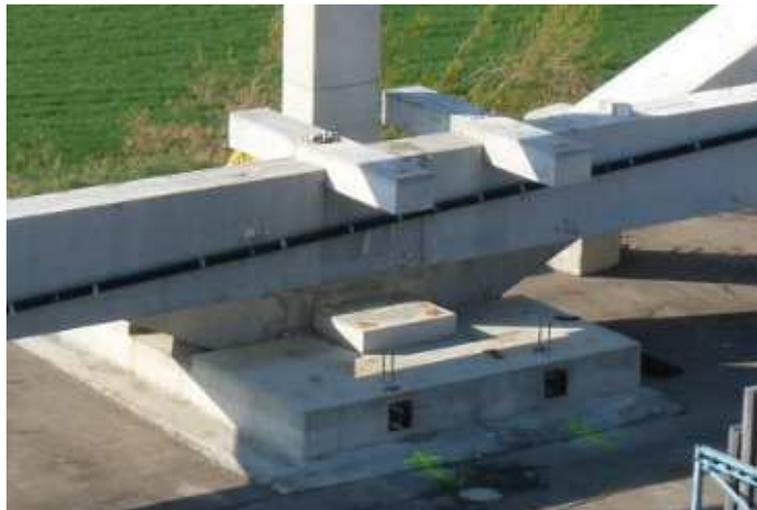
Abbildung 89: Die Konsolen zur Einleitung des Torsionsmomentes [4]
