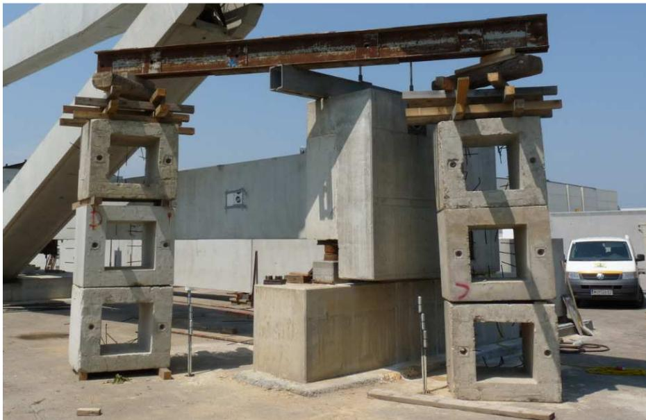
Abbildung 92: Herstellung der Absicherung gegen Abheben
