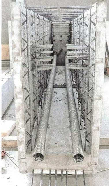
Abbildung 86: Fertigteil U-Querschnitt [4]
