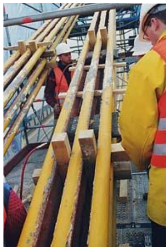
Abbildung 2-7 Herstellen einer Seilspreizung
