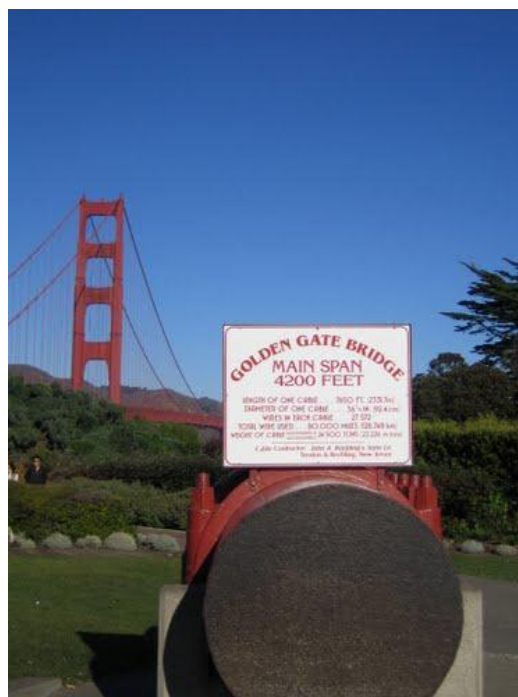
Abbildung 2-6 Querschnitt eines Kabels der Golden Gate Bridge [7]
