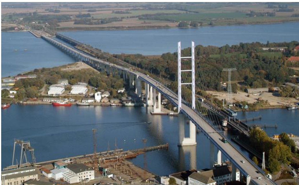
Abbildung 3-8 Rügenbrücke mit dem danebengelegenen Rügendamm [18]
