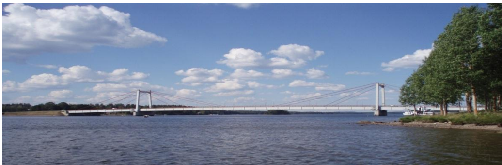
Abbildung 3-6 Strömsundbrücke in Schweden [15]
