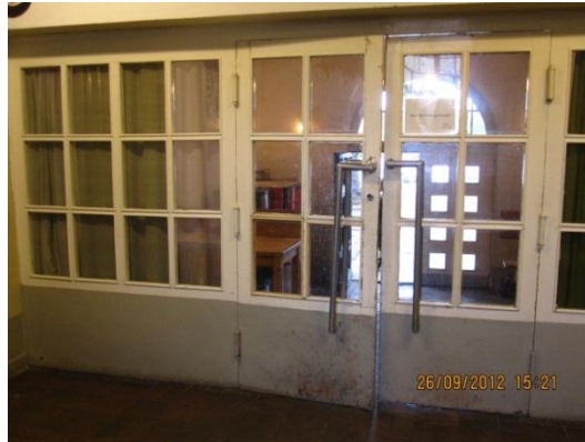
Abbildung 3-10: Windfangbereich und Aufenthaltsraum sowie Raucherbereich - Ausgang straßenseitig
