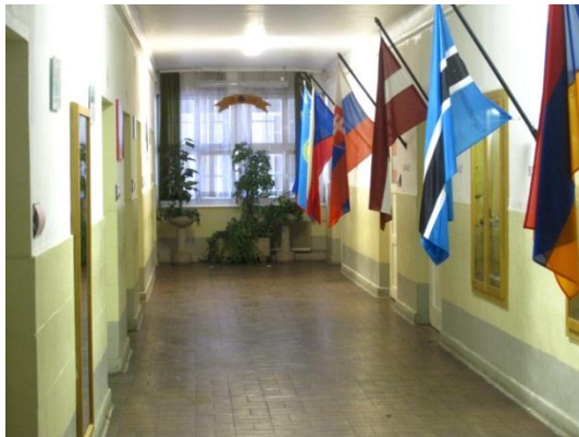
Abbildung 3-4: Gangbereich im Erdgeschoss mit Klinkerziegel - links und rechts tragendes Ziegelmauerwerk mit Innenverputz und Anstrich
