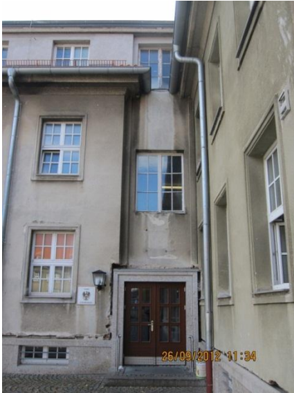
Abbildung 3-15: Tür 01 - Doppelflügel-Holztür sowie Fenster FE06 im Treppenhaus
