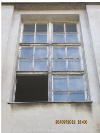
Abbildung 3-24: Frontansicht des Holzverbundfensters FE05 im Treppenhaus
