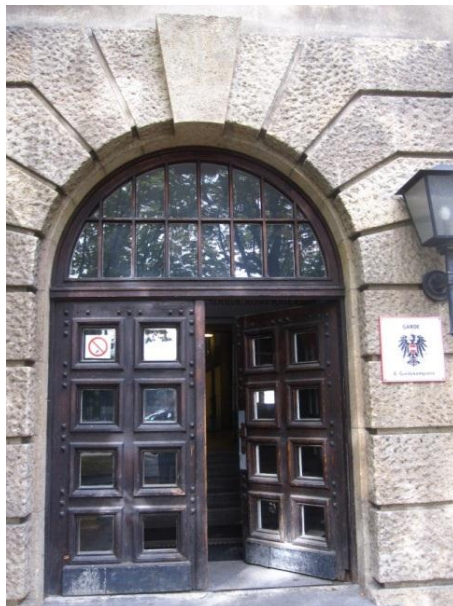
Abbildung 3-17: Tür 03 - Doppelflügel-Holztür - straßenseitiger Zugang zu den Treppenhäusern
