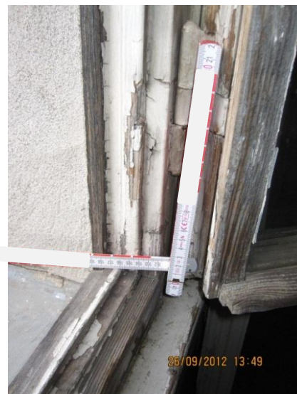
Abbildung 3-25: Detailansicht des Fensters FE05 im Treppenhaus
