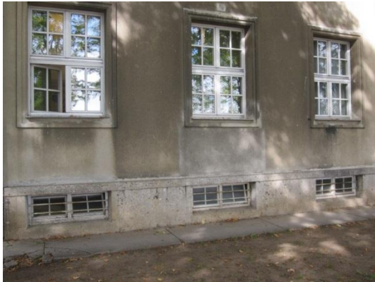
Abbildung 3-18: Holzkellerfenster FE01 bzw. Regel-Holzverbundfenster FE03 ostseitig
