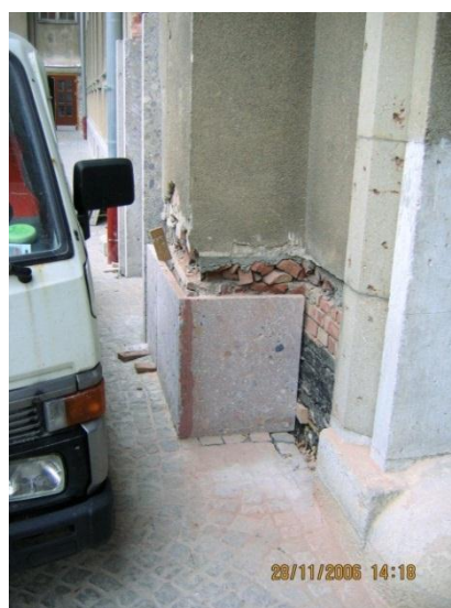
Abbildung 3-43: Innenhofsanierung des Sockelbereichs im Jahr 2006
