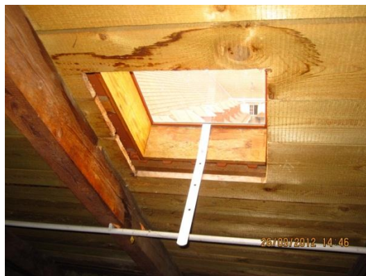
Abbildung 3-14: Typisches Kaltdach mit Hinterlüftung und Dachschrägenfenster
