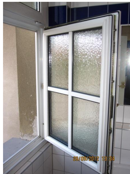
Abbildung 3-21: Fenster FE 03 – Kunststofffenster mit außenliegendem, nicht glasteilemdem Fensterkreuz
