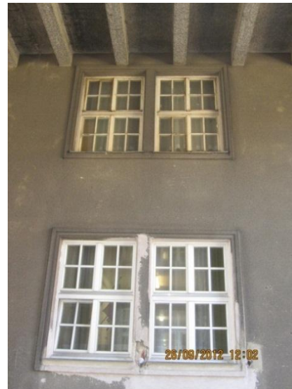
Abbildung 3-23: Alte Fenster FE 04 im Durchfahrtsbereich
