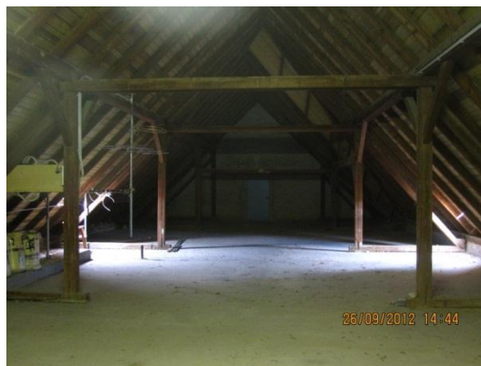
Abbildung 3-11: Dachraumbereich mit doppelt stehendem Stuhl
