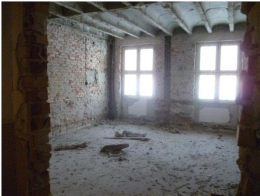
Abbildung 3-6: Ausgeräumtes Zimmer mit Ast-Mollins-Decke und sichtbarer Mauerwerksinnen- und Außenwänden - Block B [22]
