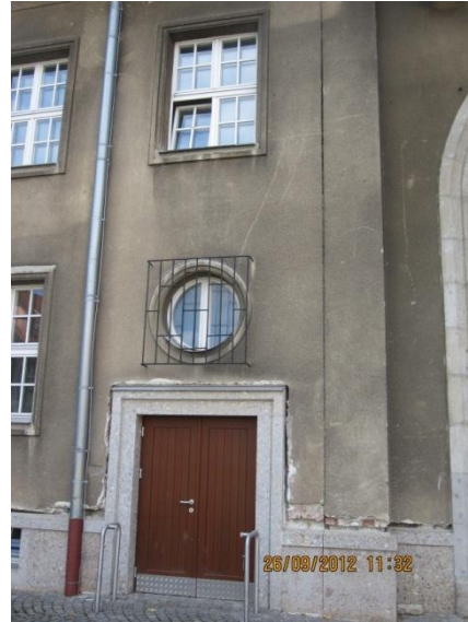
Abbildung 3-16: Tür 02 - Doppelflügel-Holztür und rundes Holzverbundfenster FE10
