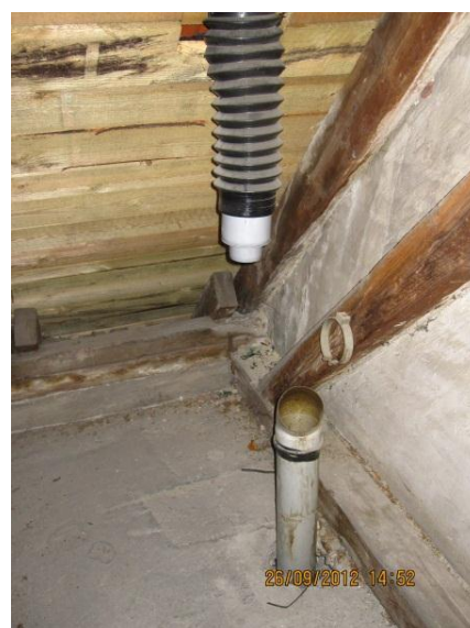
Abbildung 3-41: Alte Abluftleitung des Sanitärbereichs bzw. WC-Anlage
