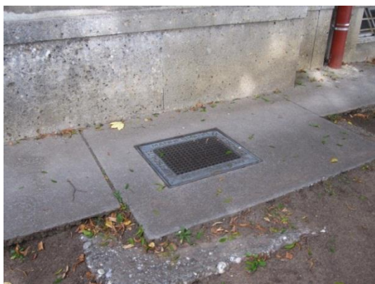
Abbildung 3-2: Rundumlaufender Isoliergraben mit Lüftungsgitter des Notausstiegs der Magazinräume
