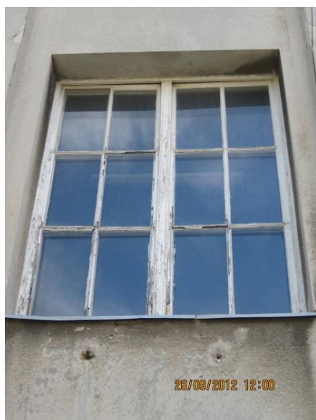
Abbildung 3-26: Frontansicht des Holzverbundfensters FE06 im Treppenhausbereich von außen
