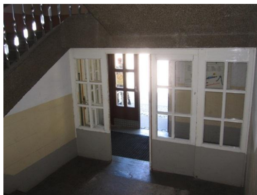
Abbildung 4-11: Windfangsituation im Treppenhausbereich
