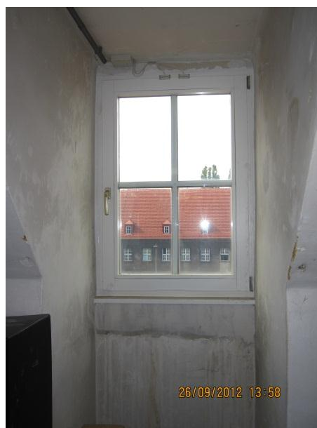
Abbildung 3-27: Fenster FE 08 – Holzverbundfenster im Gaupenbereich - von innen
