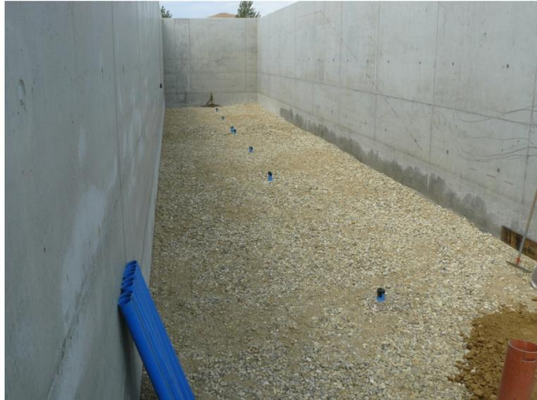
**Abb. 3.28:** In das Versuchsbecken eingebauter Grundwasserleiter.
