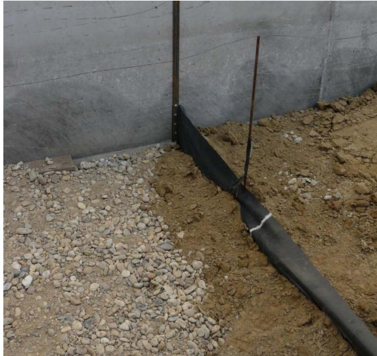
**Abb. 3.33: Folie als Verlängerung der Dichtwand (sog. Tauchwand) in den Grundwasserleiter.**
