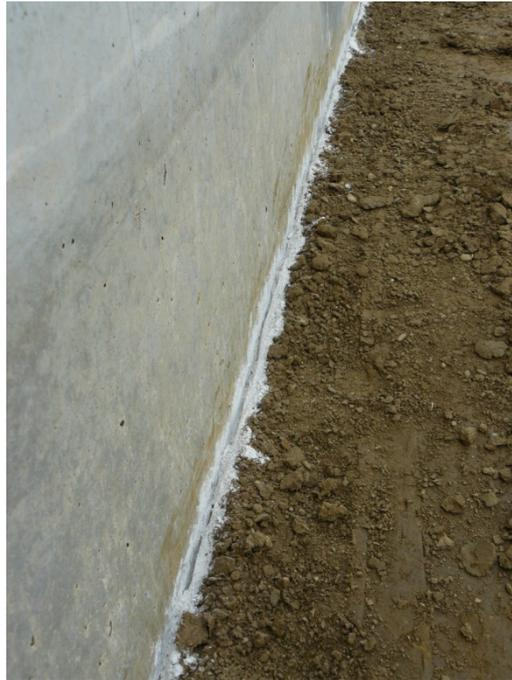
**Abb. 3.31: Abdichtung der Randbereiche der Deckschicht mit Bentonit.**
