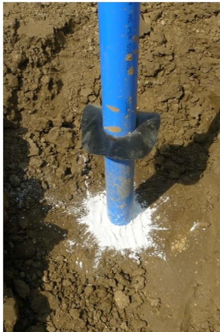
**Abb. 3.32: Manschettenring zur Sickerwegverlängerung am Pegelrohr.**
