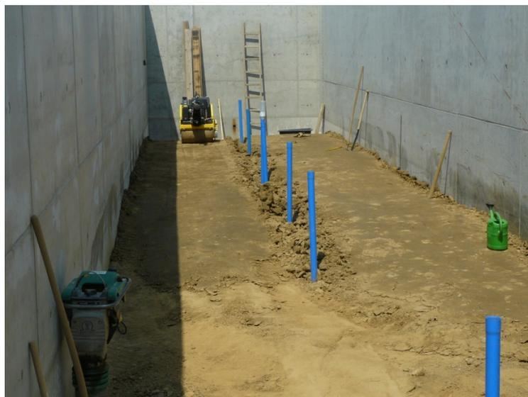
**Abb. 3.34: Bindige Deckschicht mit den bis zum Beckenboden reichenden Pegelrohren.**
