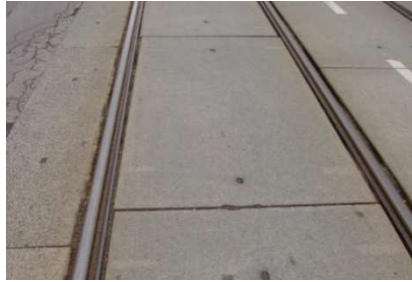
Abbildung 1-12: Wiener Rillenschienenoberbau [23]
