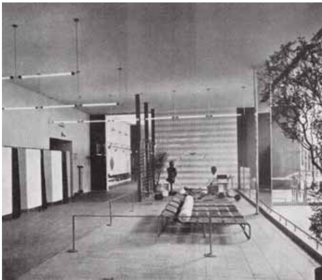
Abb. 55: Gemeinschaftsraum im Boardinghaus, Ruhebereich, Gropius, Berlin 1931
