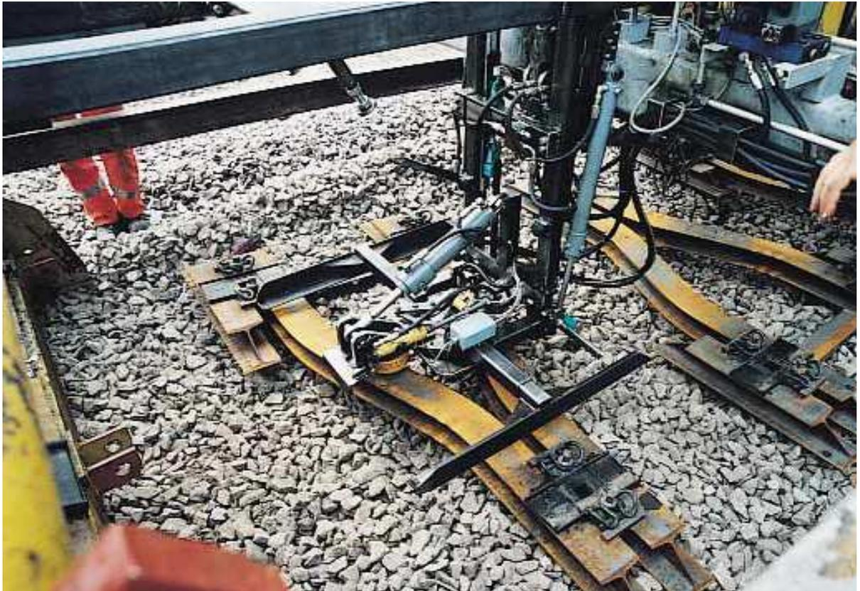
Abb. 2.1 Y-Schwellenverlegung mit Hilfe des Umbauzuges UM-1
