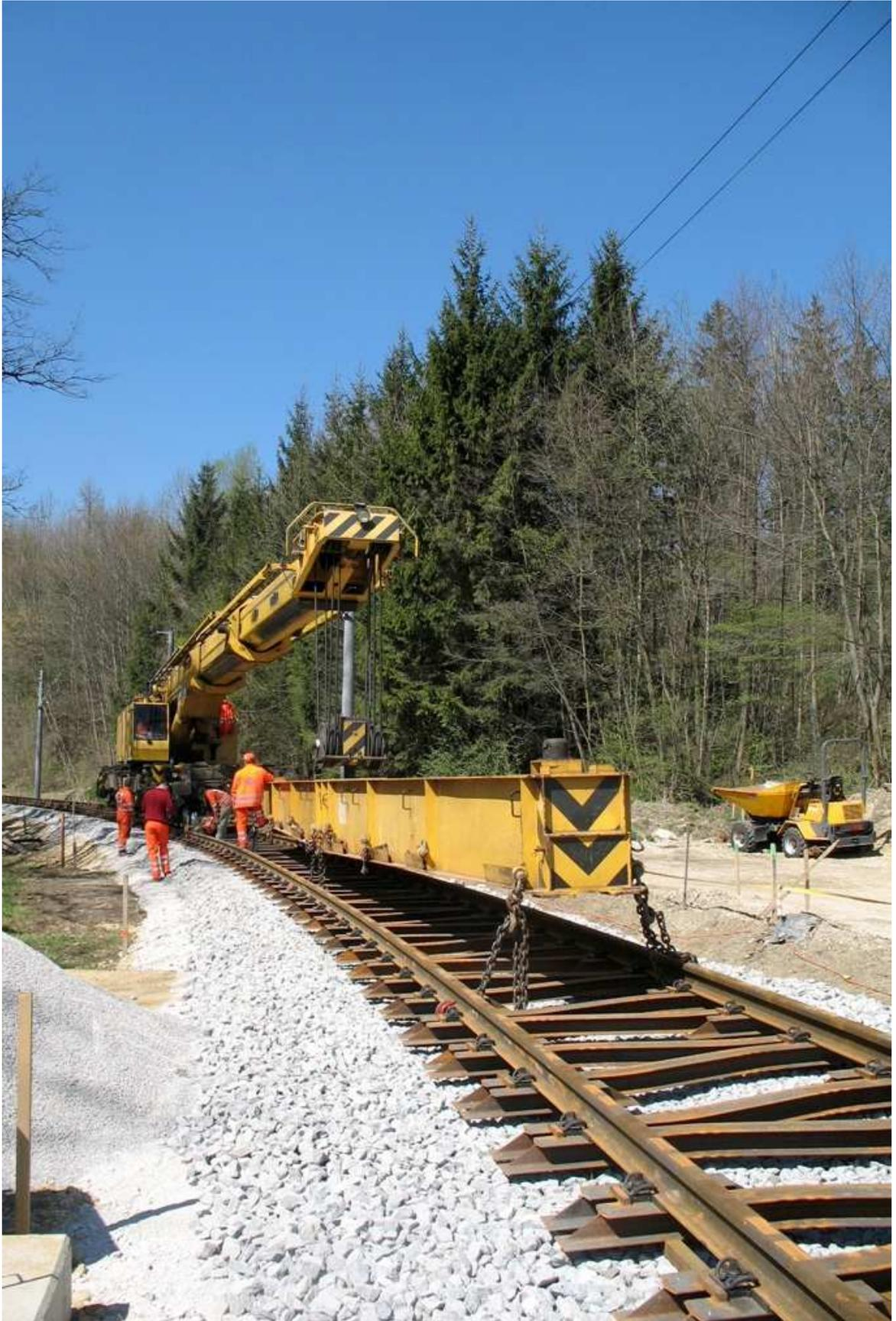
*Abb. 3.4 Verlegung der vormontierten Joche mit der Hilfe vom Gleiskran*
