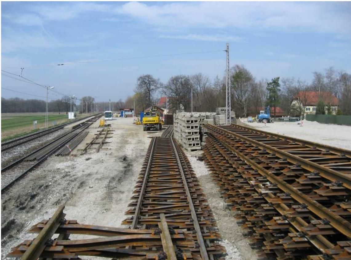
Abb. 3.1 Baustelle für Herstellung der Gleisjoche
