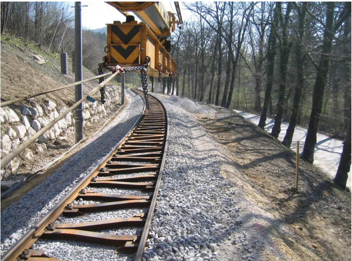
*Abb. 3.3 Gleisjoche nach dem Einbau ins Gleisbett*
