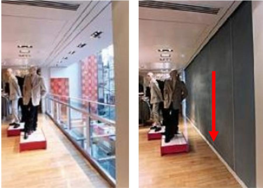
Abbildung 3.10: Flexibler Rauchschutzvorhang als Rauchabschnittsgrenze zwischen Atrium und Verkaufsfläche [Quelle: Eckart Feuerschutz]
