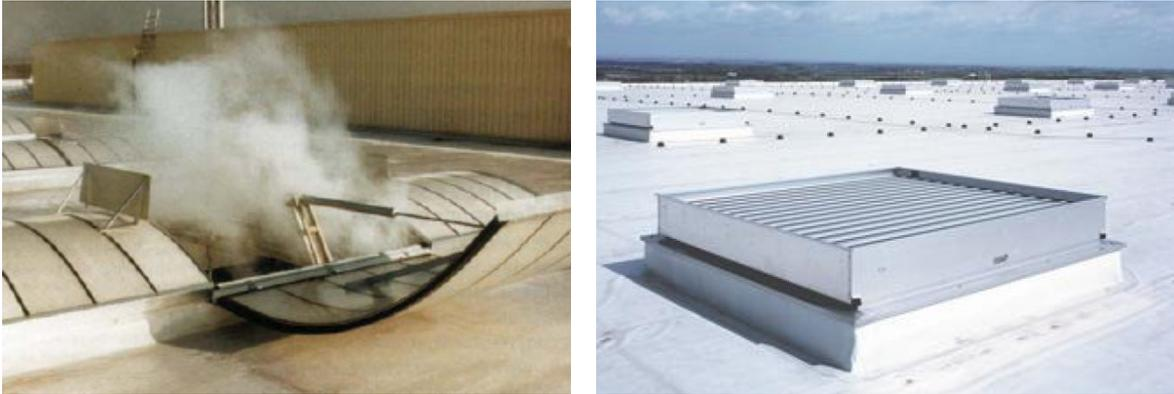
Abbildung 2.1: Lüfter von Brandrauch-Entlüftungs-Anlagen (BRE) auf Gebäudedächern
