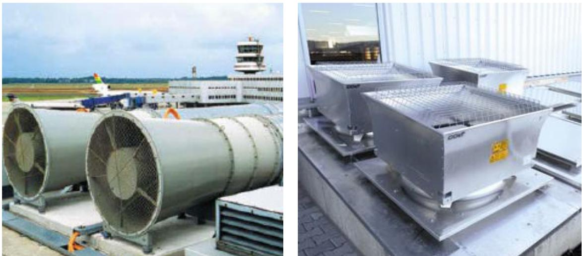
Abbildung 2.2: Lüfter von Brandrauch-Absaug-Anlagen (BRA) auf Gebäuden
