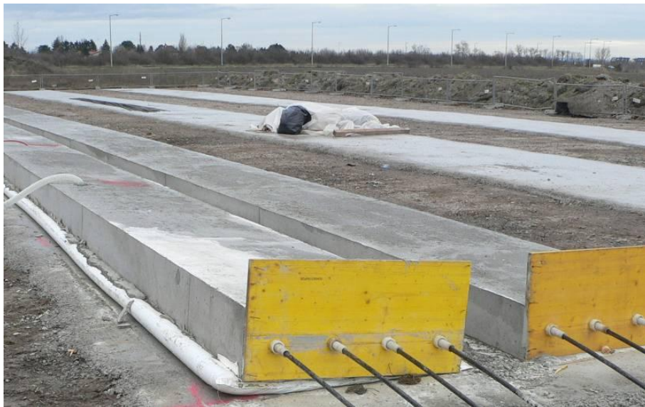
Abb.4.20 Luftlagerung kurz nach dem Abheben
