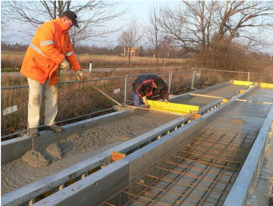
Abb.4.12 Betonieren der Bodenplatte 1 und 2
