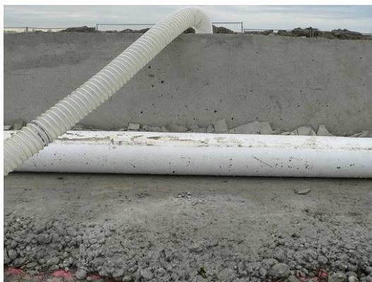
Abb.4.18 Luftlagerung der Betonplatte
