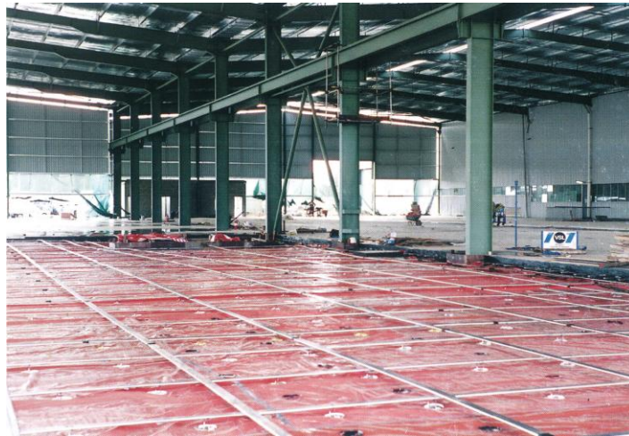
Abb.1.9 Vorgespannte Bodenplatte (Photo by VSL)
