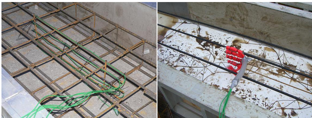
Abb.4.36 Einbau der Temperaturfühler in die Schalung der Bodenplatte
