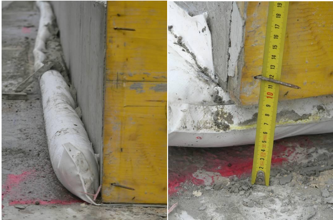
Abb.4.19 Luftlagerung kurz vor dem Abheben (links) und abgehobene Platte (rechts)
