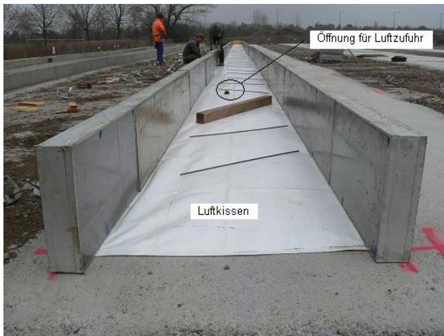
Abb.4.14 Verlegung des Luftkissen und Schalung von Platte 3
