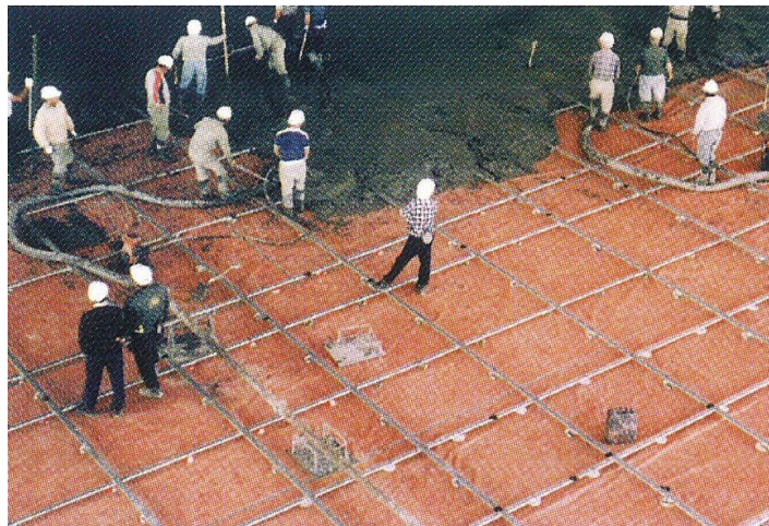
Abb.1.8 Herstellung der Bodenplatte (Photo by VSL)
