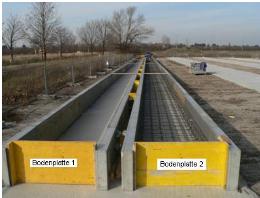
Abb.4.10 Verlegung der Bewehrung in Bodenplatte 2
