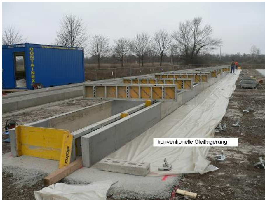
Abb.4.15 Konventionelle Gleitlagerung Bodenplatte 4
