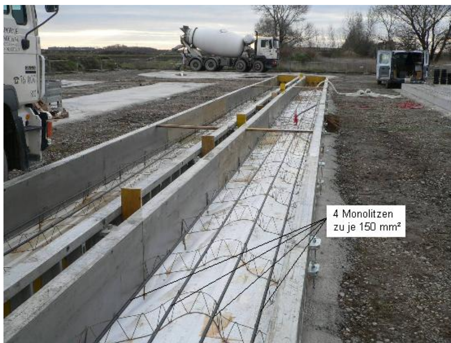
Abb.4.16 Spannbewehrung in den Bodenplatten 3 und 4
