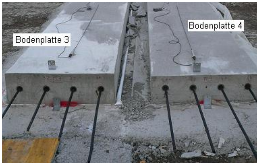
Abb.4.79 Vorspannung in Bodenplatte 3 und 4
