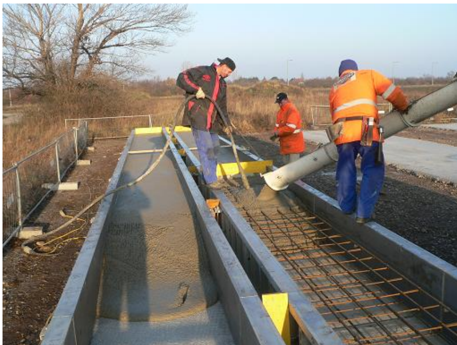
Abb.4.11 Betonieren der Bodenplatte 1 und 2
