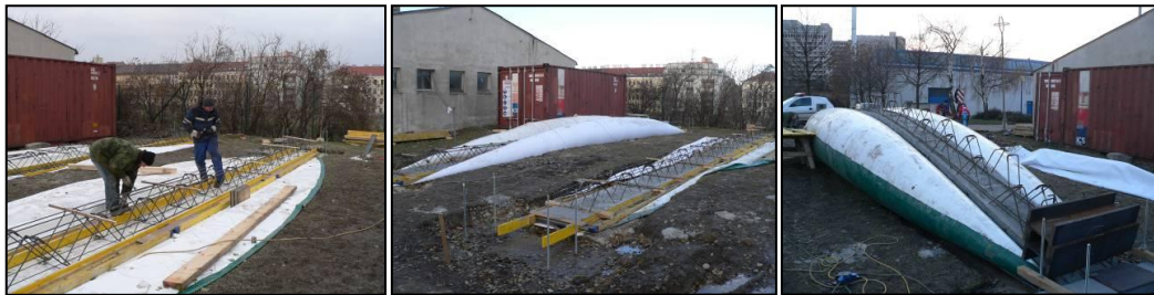
Abb.4.4 Anwendungsbeispiel: Luftkissen zur Verkrümmung einer Betonplatte
