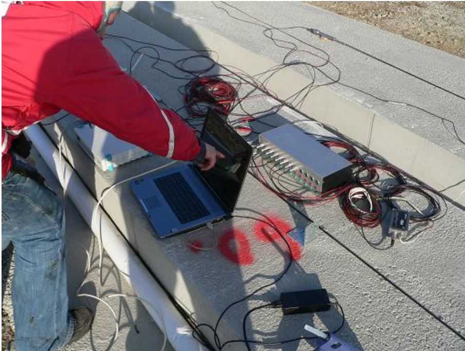
Abb.4.65 Dehnungsmessung an den Bodenplatten
