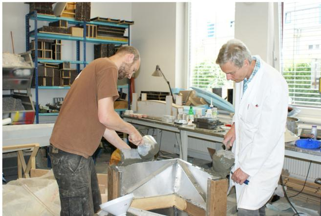
Abb.138 Betoneinbringung in die Schalung
