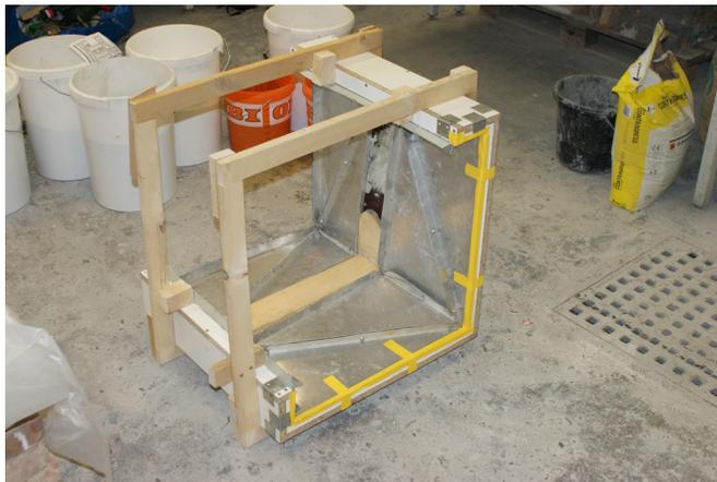
Abb.145 verstärkter Schalungskörper
