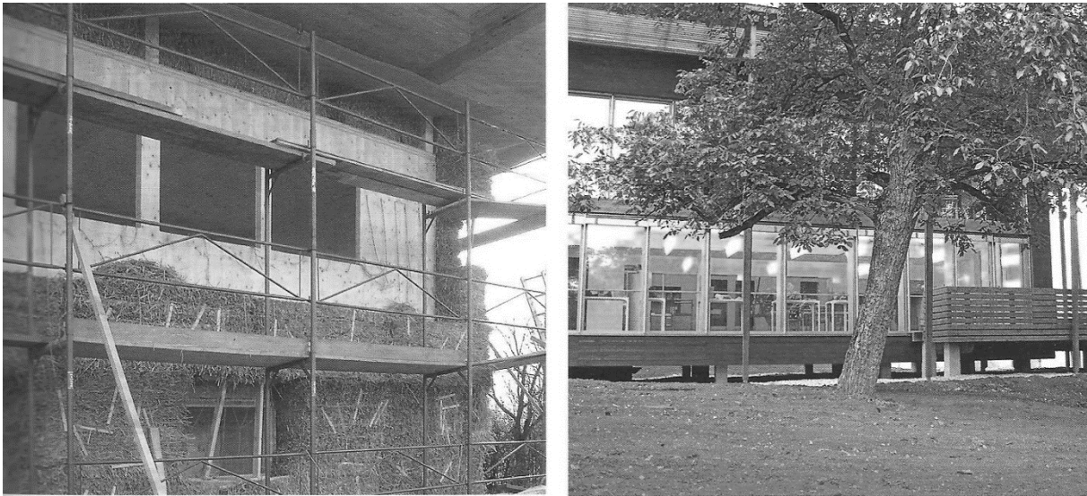
Abbildung 51: S-HOUSE, Baustelle und fertiggestellt
