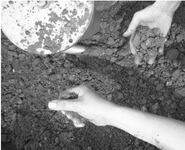
Abbildung 24: Lehmmischung für eine Stampflehmwand
