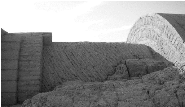
Abbildung 28: Nubisches Tonnengewölbe, Ägypten
