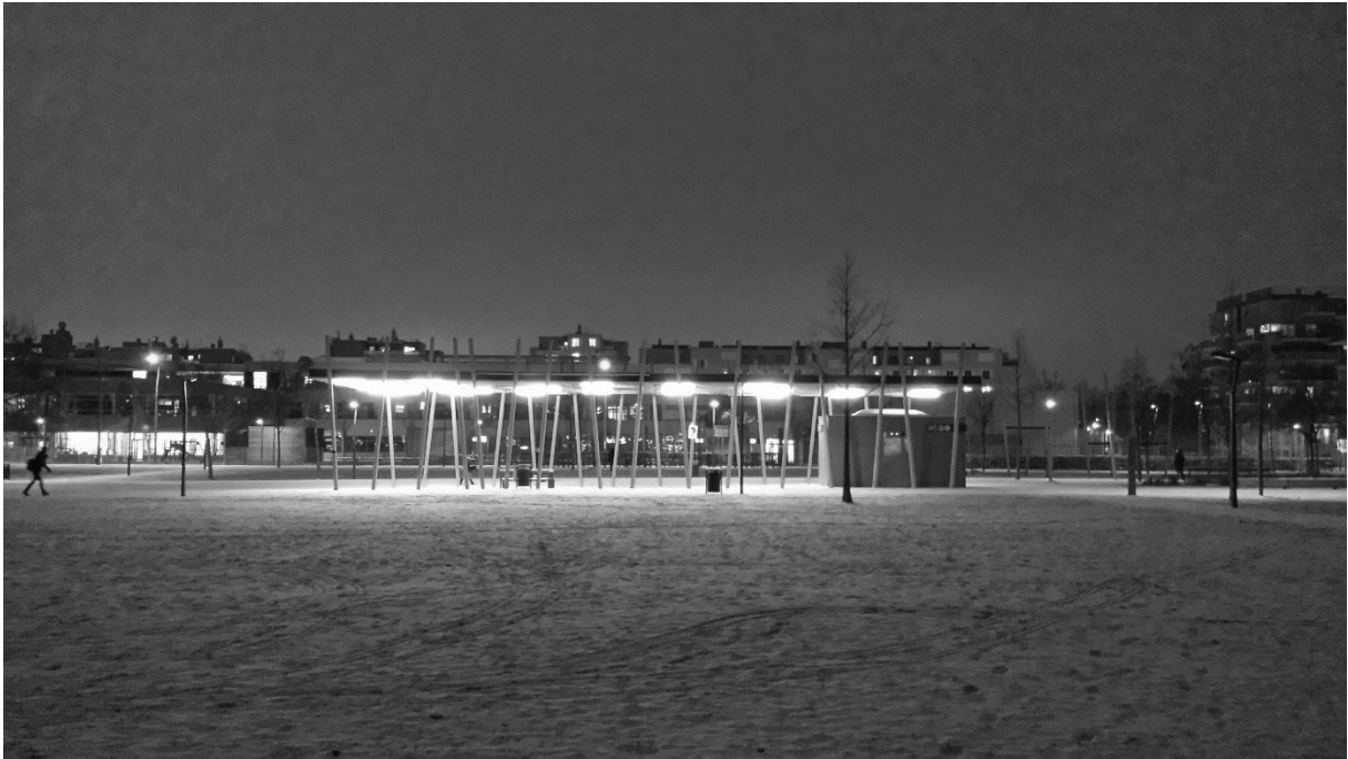
Abbildung 17: Pergola Süd-West Ansicht
