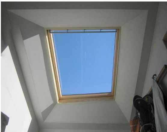
Abbildung 55: Dachflächenfenster Haus Hirsch, 2014
