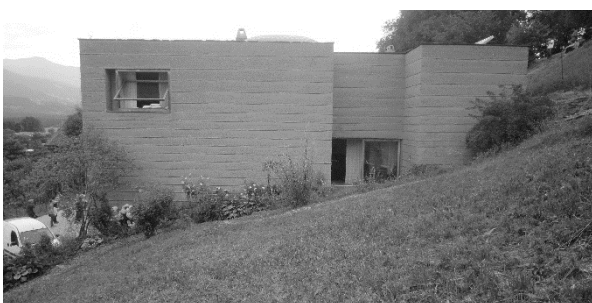
Abbildung 30: Haus Rauch, Vorarlberg
