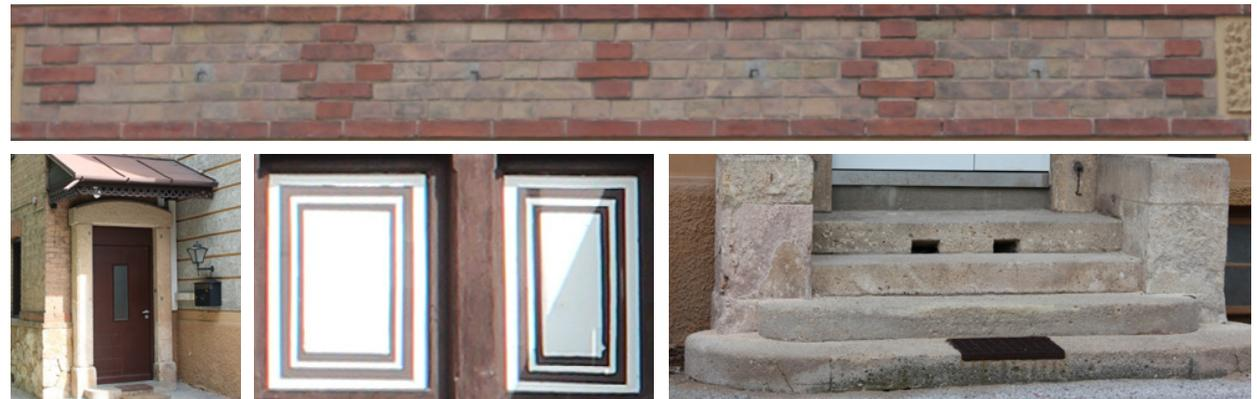
Abb. 119 | Gurtgesims aus Ziegelornamentik, Eingang Seitenrisalit, Kassetten auf verbretterten Giebel, Luftöffnungen für Keller
