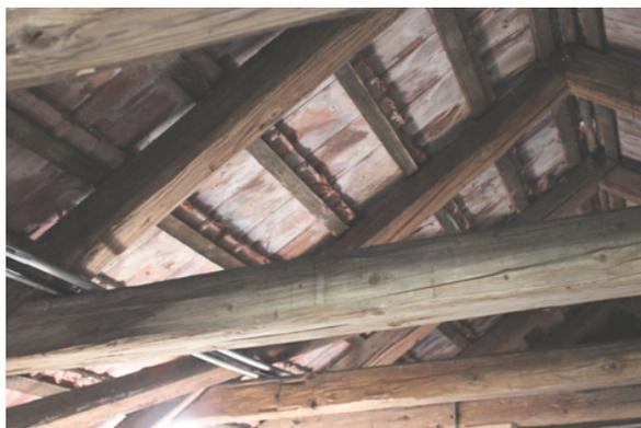
Abb. 83 | Entlüftungsöffnungen im Dachraum, Häuser am Schlossberg
