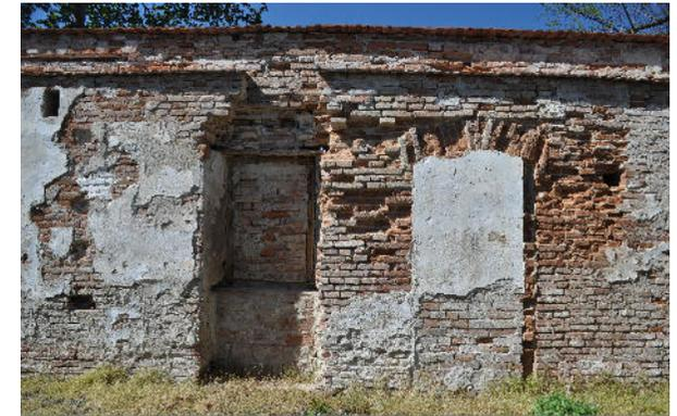
Abb. 100 Zugemauertes Fenster und Tür
