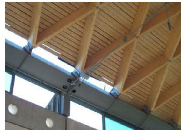
Abb. 151 Randträger mit Auflagerung und Zugband
