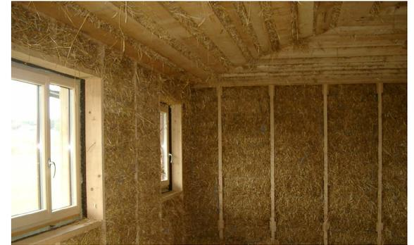
Abb. 46. Strohdämmung
