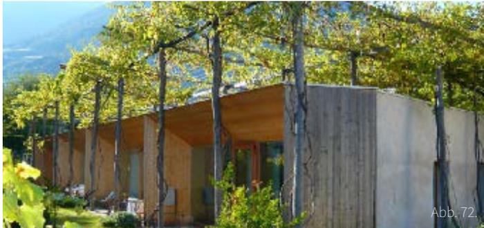
Lasttragender Strohballenbau mit direkt verputzten Ballen
