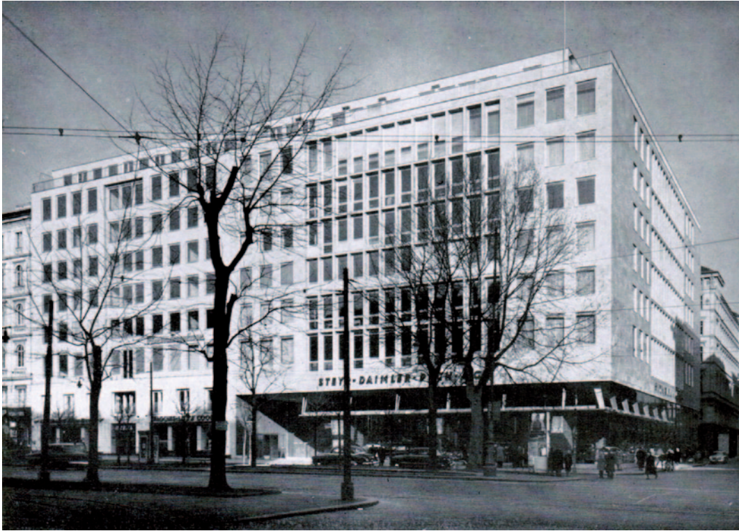
Abb. 4.42 Fotografie des nach einem Brand im Jahr 1987 abgebrochenen Steyr-Hauses am Kärntnerring 7
