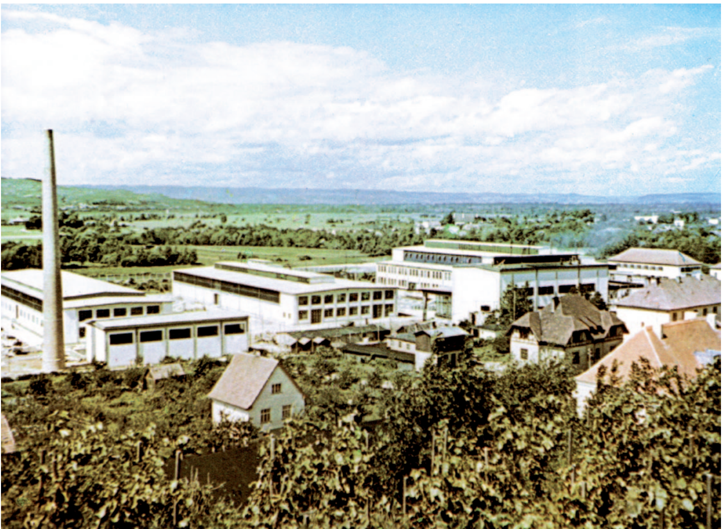
Abb. 2.9 Martin Miller-Stahlwerke Traismauer (NÖ) Carl Appel 1939-44
