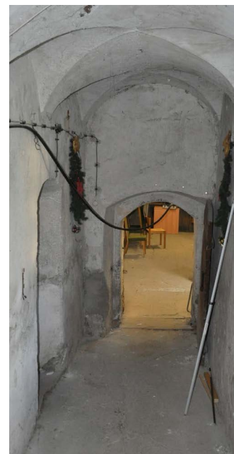
Abb. 24: Einbau von Fussbodenheizung
