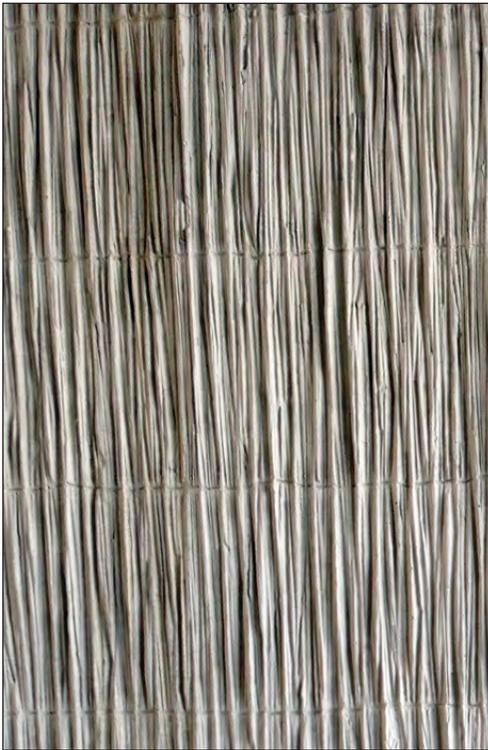
Abb.73: strukturierter Sichtbeton
