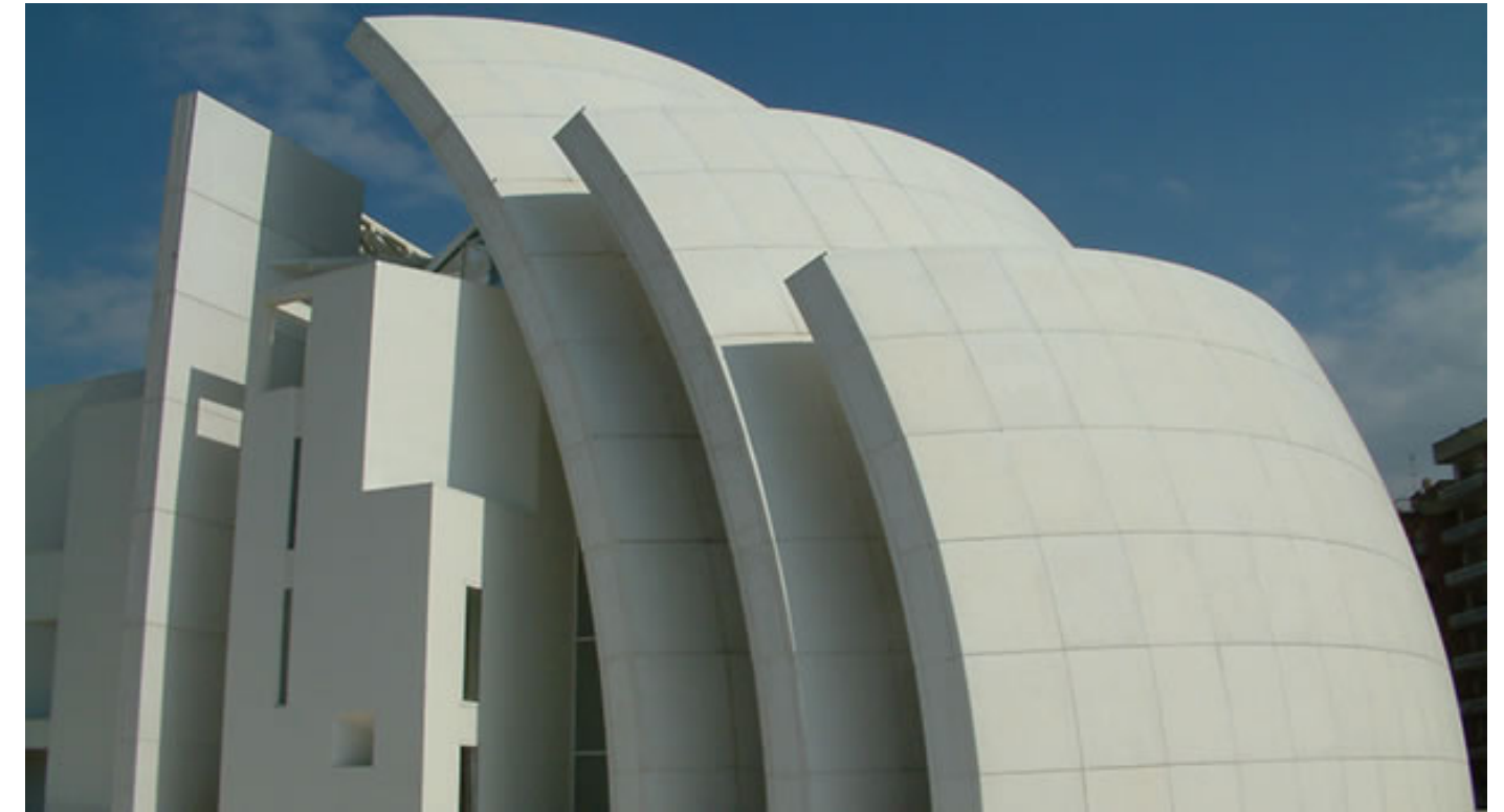
Abb. 105 Kirche „Dives in Misericordia“ in Rom (Bj. 2003 - Richard Meier) aus TiO 2 -angereichertem, selbstreinigendem Beton
