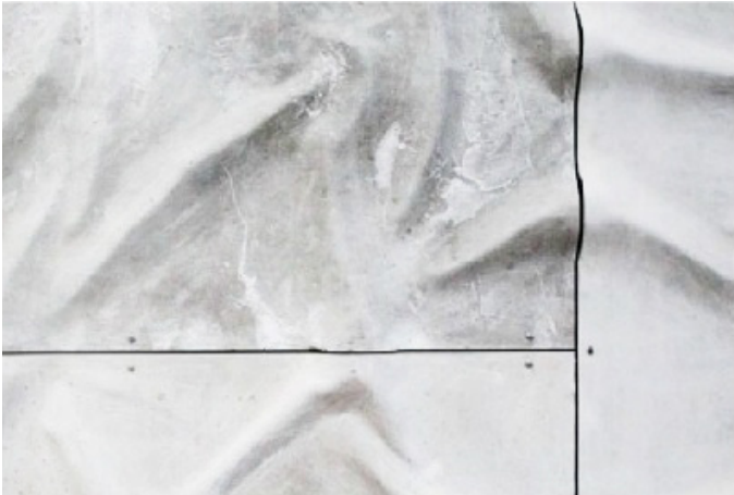
Abb.102 Fassadenplatten aus geformtem, photokatalytischem Faserzement
