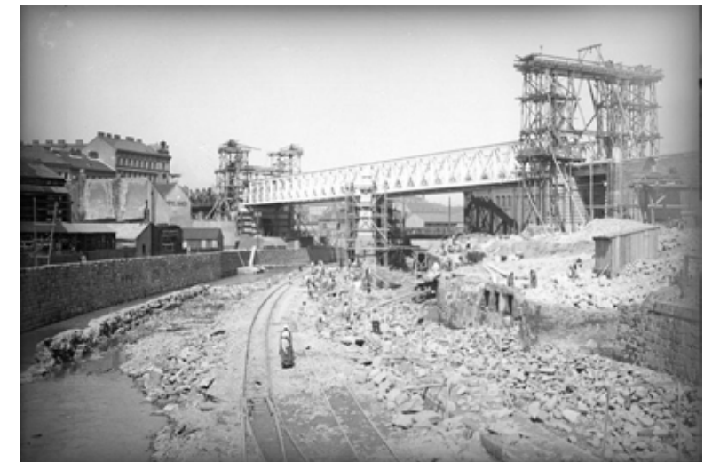
Abb. 24 Regulierungsarbeiten und Brückenbau um 1899
