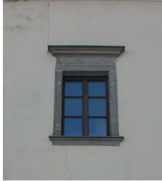
Abb_105: Fenster Obergeschoss Kreuzgang
