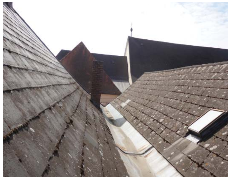
Abb_144: Dachverschneidung mit Blick zur Pfarrkirche
