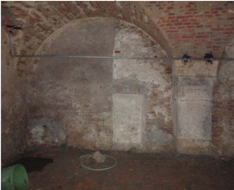
Abb_203: Keller der Remise mit Vermauerung zum Gasthauskeller
