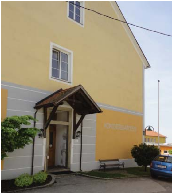
Abb_123: Eingang in den Kindergarten
