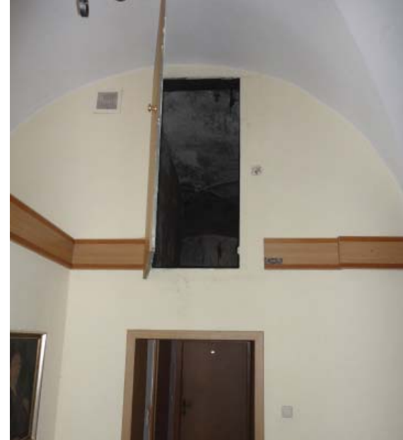
Abb_156: Aufgang zum Dach mit angegratetem Gewölbe
