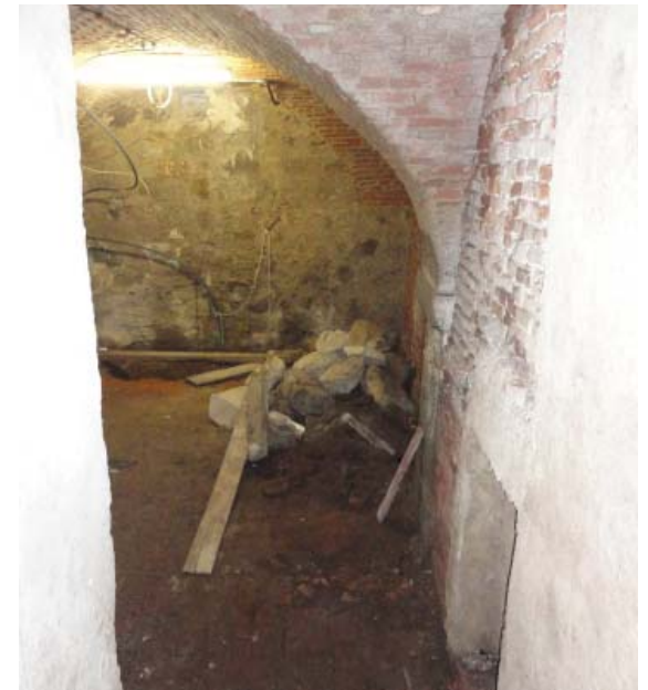
Abb_165: vormaliger Kellerabgang mit Abmauerung rechts
