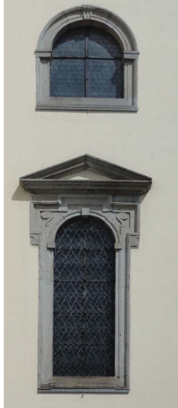
Abb_108: Fensterkombination Kirchenraum Südseite
