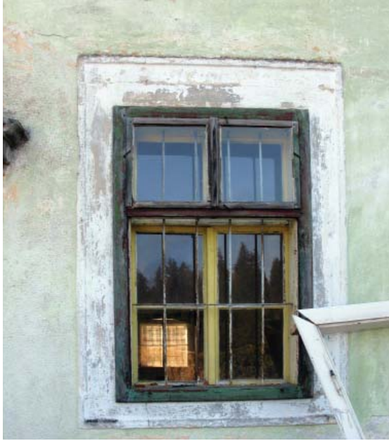
Abb_176: EG, Vorreiber außen, Aufdopplung im Sturz
