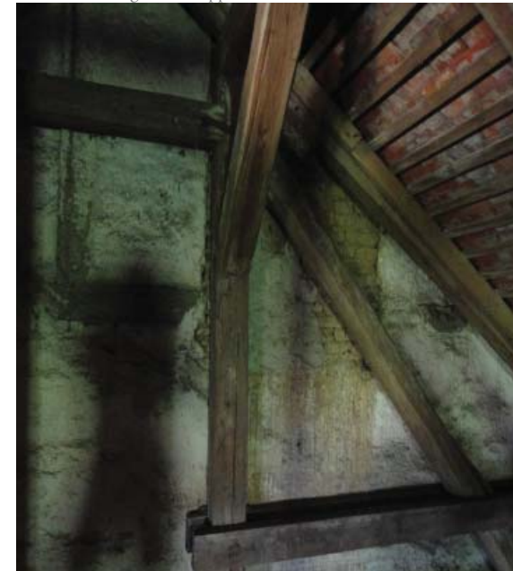
Abb_181: Mögliches Doppelfenster im Dachraum der Remise
