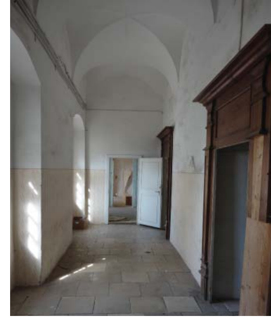
Abb_185: Prioratsgang mit Solnhofer Platte
