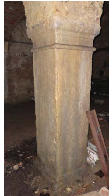
Abb_204: Abweichend profilierte Stütze
