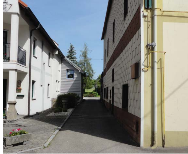
Abb_81: Weg am Gasthaus vorbei in den früheren Kuchlgarten, links sind Spolien des Schlosses zu erkennen, Fassadengestaltung mit Eternit und Wellblech.
