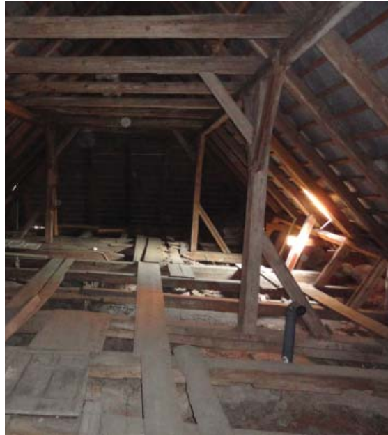
Abb_161: nachträgliche Stützen hin zum westlichen Satteldach
