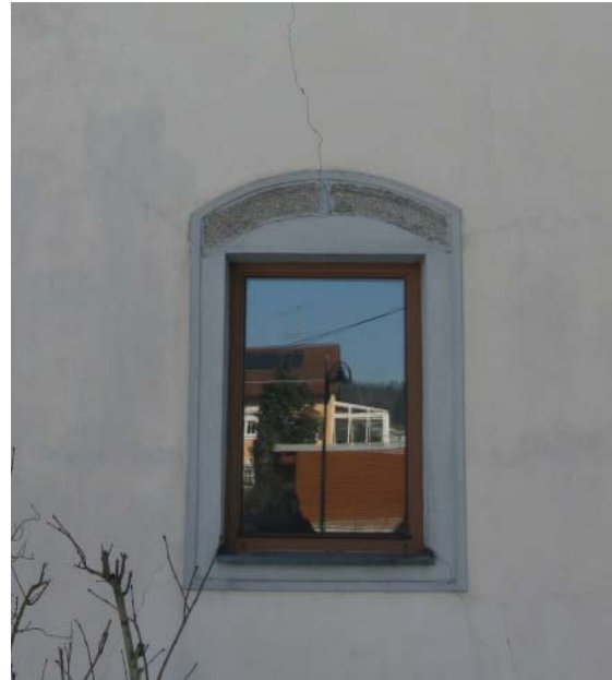
Abb_107: Fenster Erdgeschoss Kreuzgang
