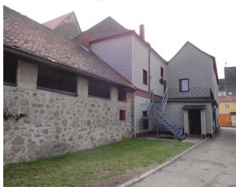
Abb_146: Nordfassade mit Fluchttreppe über das Extrastüberl, links Remise
