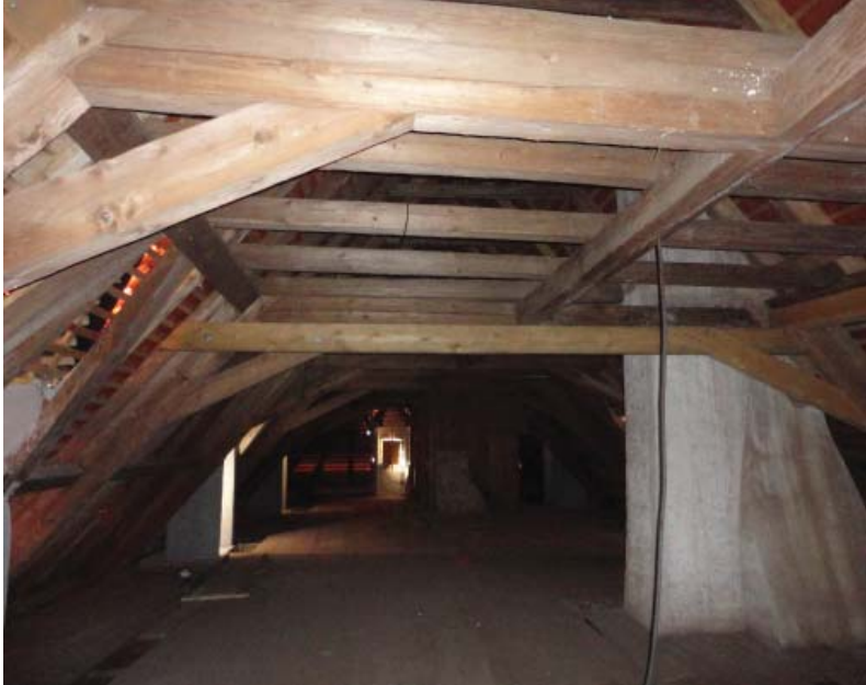
Abb_201: Dachraum nach Süden
