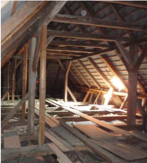
Abb_160: Dachraum mit nachträglich gestützten Mittelpfetten
