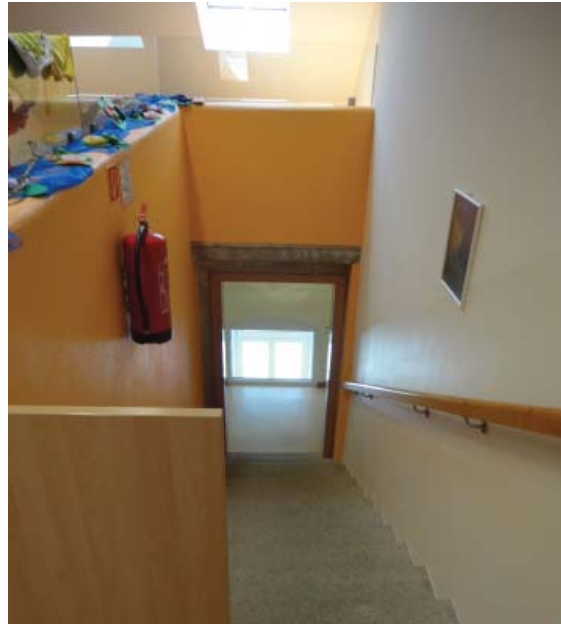
Abb_130: Aufgang zum Gruppenraum DG
