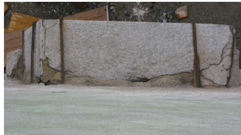
Abb_175: Grobe Steinfügung mit Fehlstellen des Dreiecksgiebels des südlichsten Portals der Ostfassade
