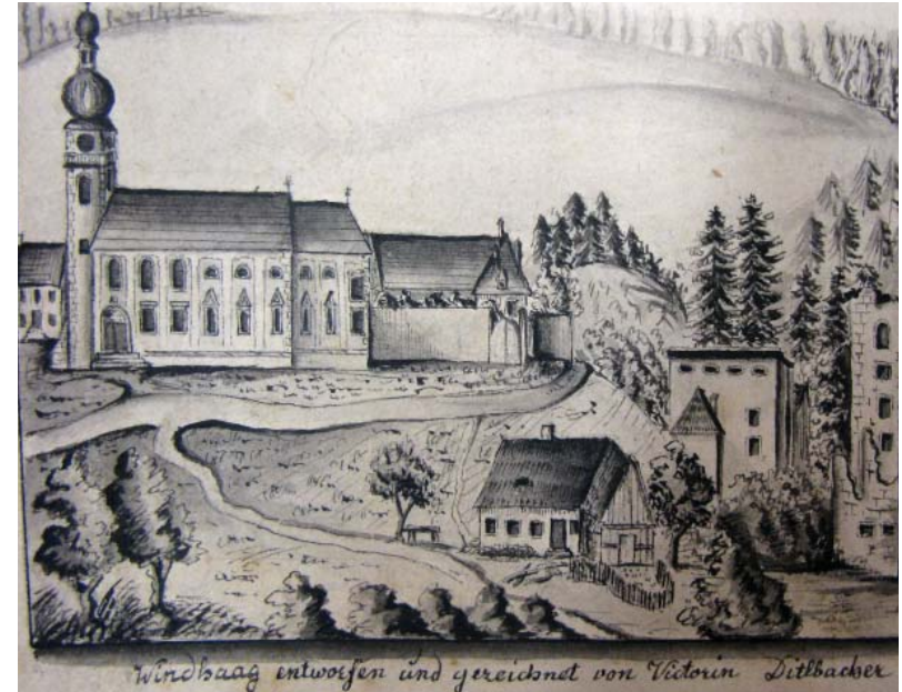
Abb_102: Ansicht von Viktorin Dirlbacher, ersichtlich sind die Klostersaußenmauer vor dem Priorintrakt, sowie eine Eckquaderung am Kirchturm und der gestreckte Turmhelm
