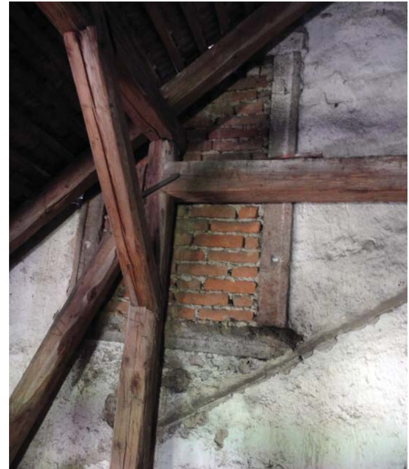
Abb_182: Vermauertes Fenster im Dachraum der Remise mit abgeschlagener Sohlbankecke und angeputztem ehemaligen Dachanschluss
