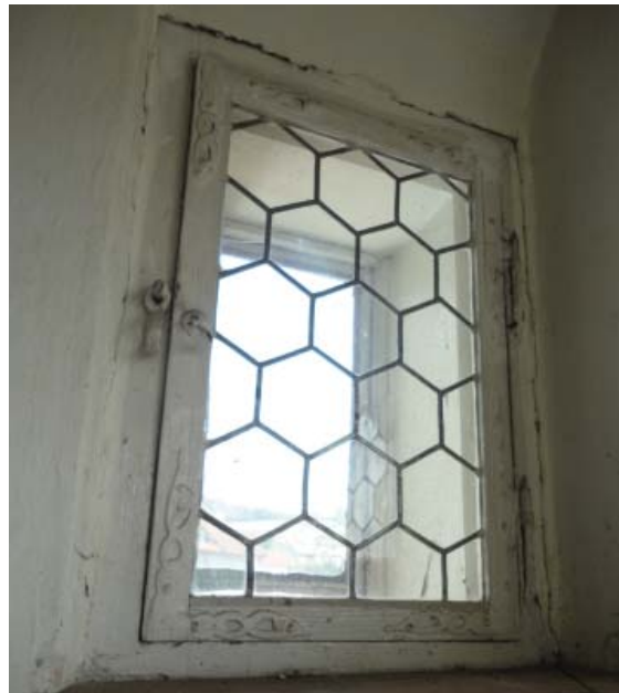
Abb_187: Nur die Oberlichte wurde als Fenster ausgeführt
