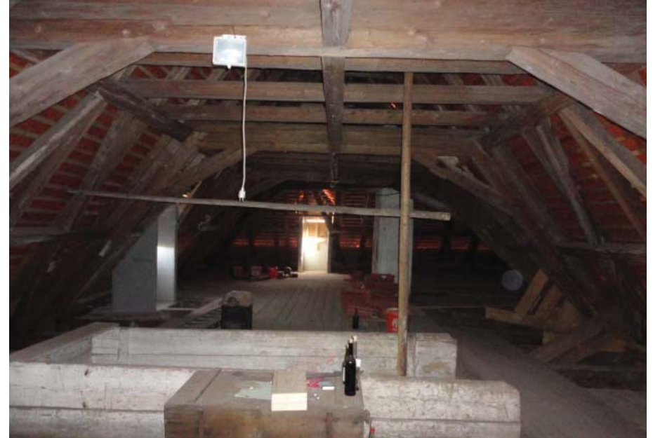
Abb_202: Aufgang in den Dachraum, links: neue Gaupen, rechts: Verstärkungen der Ichsen
