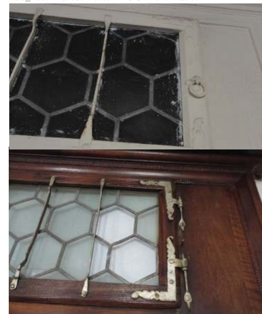
Abb_197: Zelle im Priorinrakt Abb_200: Türoberlichte im OG mit Windeisen
