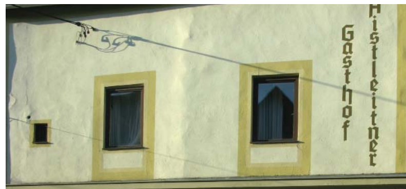
Abb_153: Im Streiflicht sind die Schlafhausgangmauern des OG ersichtlich
