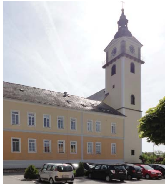
Abb_124: "Schauseite" zu Gemeindeparkplatz (Enzmilnerplatz)
