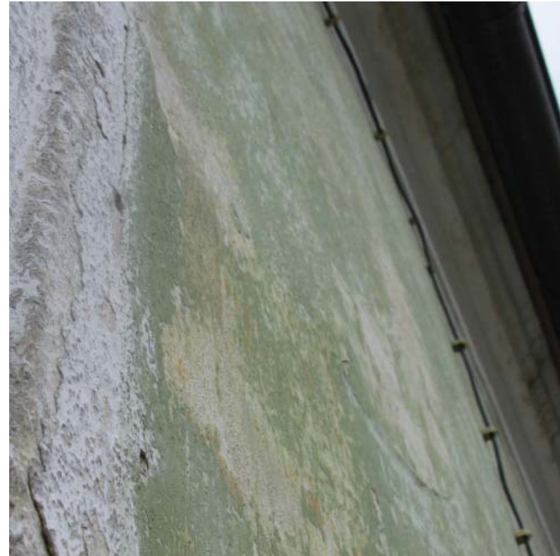
Abb_174: Putzstruktur im Detail als scharfkantige Erhebung
