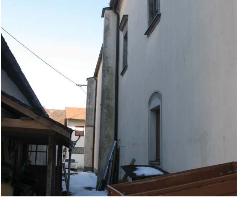
Abb_80: Blick auf die Abbruchkante des Kapitelhauses mit Mauervorlagen
