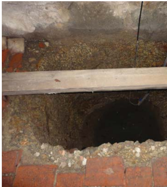
Abb_164: Brunnenschacht in massivem Granit
