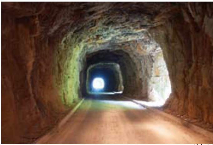
Eisenbahntunnel in Grmeč
