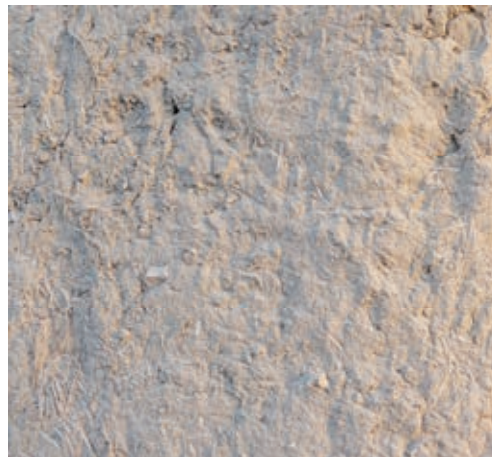
Abb. 64: Nahaufnahme einer mit Lehm verputzten Mauer.
