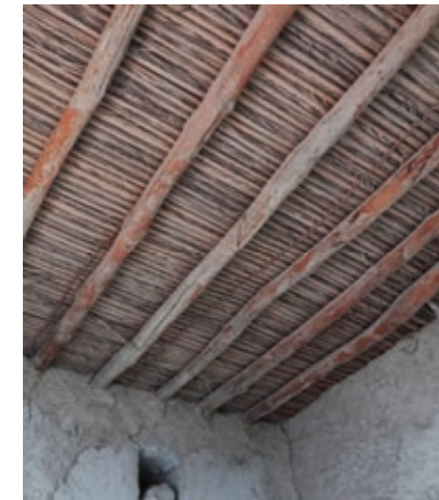
Abb. 72: Flachdach aus geraden Holzstämmen in einem iranischen Hofhaus.
