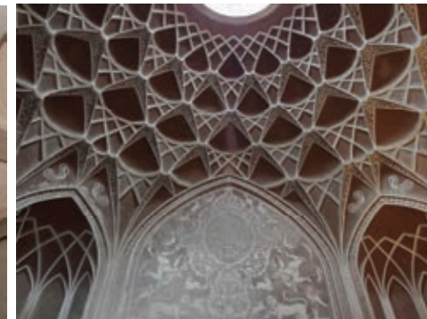
Abb. 86: Trompen und mit muqarnas besetzte Kuppel in einem iranischen Hofhaus.
