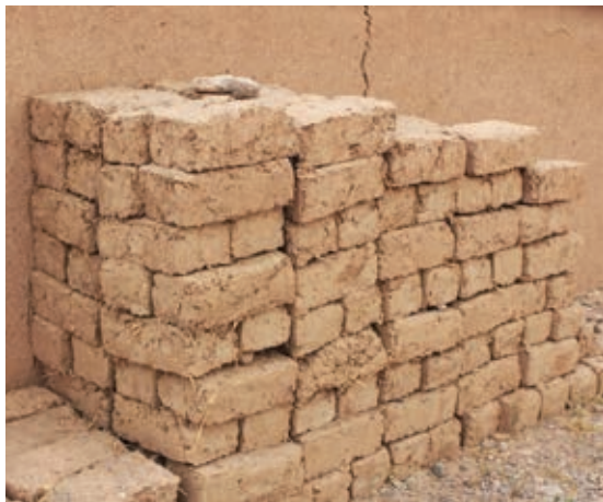
Abb. 56: Gestapelte Lehmziegel auf der Baustelle.
