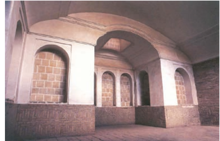
Abb. 247: Iran, Yazd, Rismanian-Haus. – Südlicher serdab mit Öffnung des badgirs .
