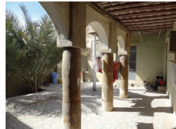
Abb. 157: Luftige Galerie in einem ländlichen iranischen Hofhaus.
