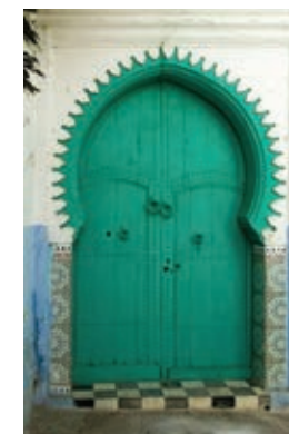
Abb. 113: Doppelflügeliges Portal eines Hofhauses in Marokko. – Die Türflügel sind mit einhängbaren Türblättern ausgestattet.
