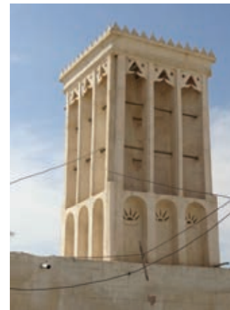
Abb. 180: Außenansicht eines etwas komplexeren Windturmes in einem ländlichen Hofhaus in Iran.
