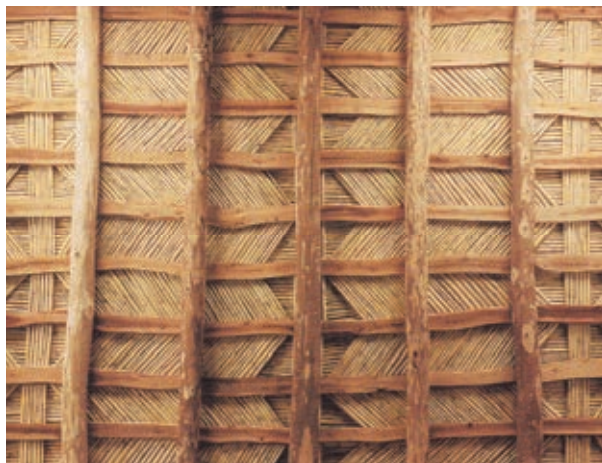
Abb. 73: Geschossdecke aus Holz in einem marokkanischen Hofhaus.
