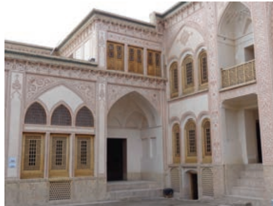
Abb. 133: Symmetrisch positionierte Fensteröffnungen in der Hoffassade fördern die Ordnung im Innenhof. – Ameriha-Haus in Kashan. – Iran.
