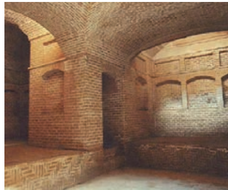
Abb. 125: Unterirdischer serdab mit flachen Ziegelgewölben im Akhavan-Sigari-Haus in Yazd. – Iran.
