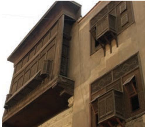
Abb. 194: Verschiedene Erker an der Außenfassade eines Hofhauses in Kairo. – Ägypten.
