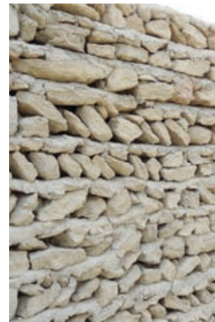
Abb. 58: Hofmauer errichtet in Steinbauweise.
