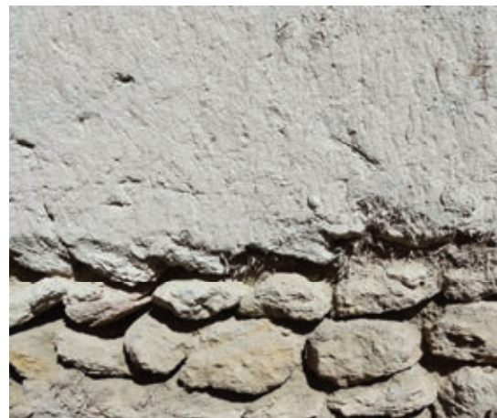
Abb. 66: Nahaufnahme eines Steinfundaments. – Die auf dem Fundament errichtete Außenmauer wurde verputzt.
