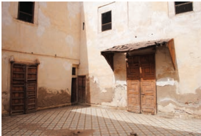
Abb. 63: Verputzte Hoffassaden eines Lehm-Hofhauses in Marrakesch.
