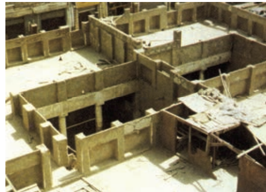
Abb. 129: Private Dachterrassen in Dammam. – Saudi Arabien.
