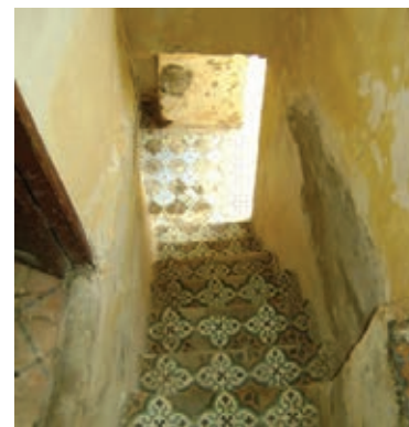
Abb. 120: Steile l-förmige Treppe in einem marokkanischen Hofhaus.
