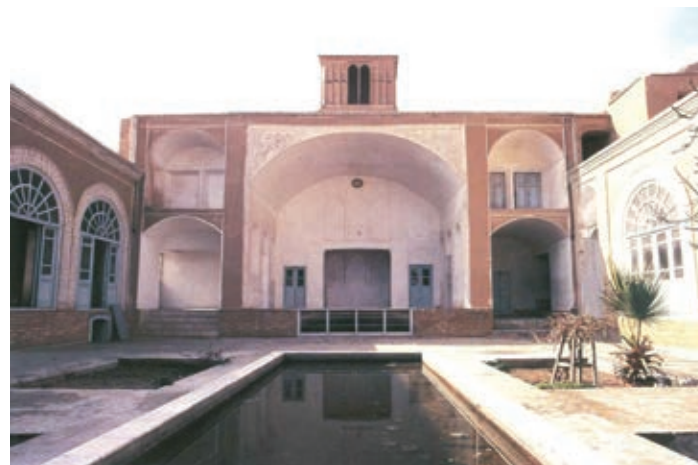
Abb. 260: Iran, Yazd, Rismanian-Haus. – Der südliche iwān mit Windturm.
