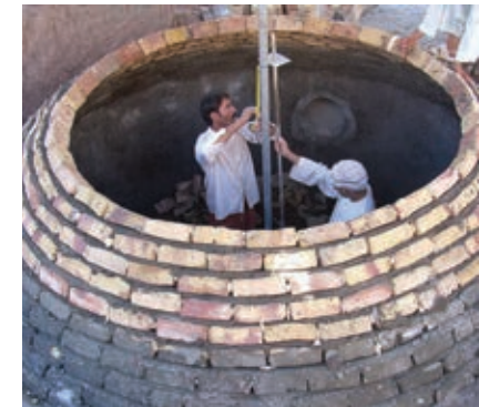
Abb. 90: Bau einer „Nubischen Kuppel“.
