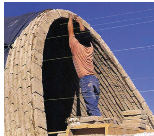
Abb. 82: Bau einer „Nubischen Tonne“.
