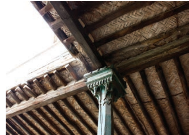
Abb. 62: Einsatz von Holz in einem traditionellen irakischen Hofhaus. – Untersicht der um den Innenhof laufenden Galerie.
