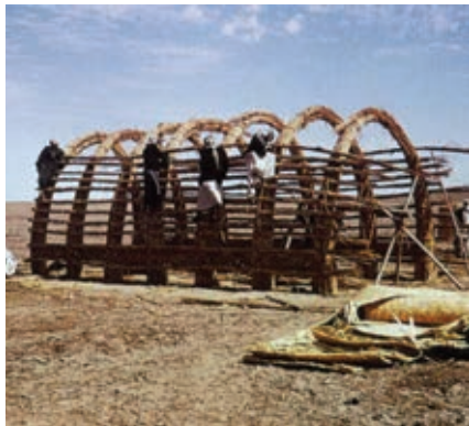
Abb. 31: Bau einer traditionellen Schilfkonstruktion aus gebündelten Schilfhalm-Bögen.
