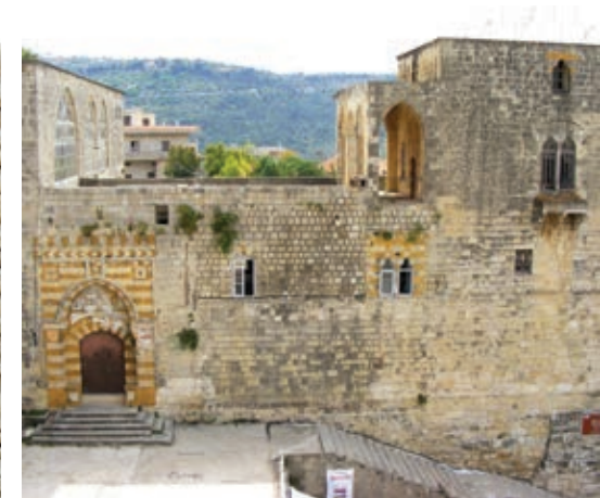
Abb. 59: Hofhaus in Steinbauweise. – Libanon, Deir el-Qamar, Baz-Honein-Haus.
