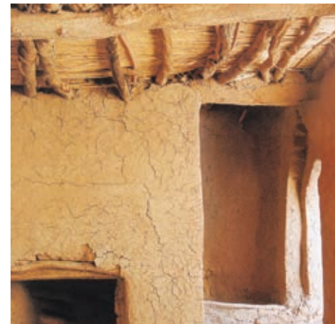
Abb. 71: Flachdach aus Knüppelhölzern in einem Hofhaus in Marokko.
