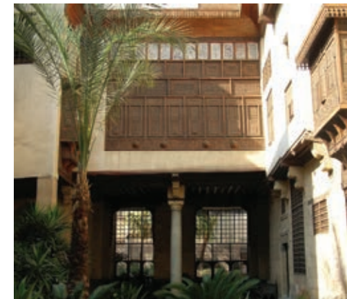
Abb. 192: Vergitterte Fensteröffnungen vom Innenhof betrachtet.
