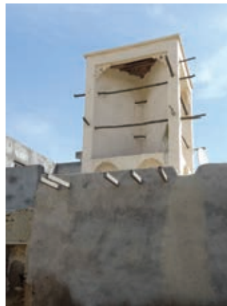
Abb. 178: Außenansicht eines einfachen Windturmes in einem iranischen Hofhaus.
