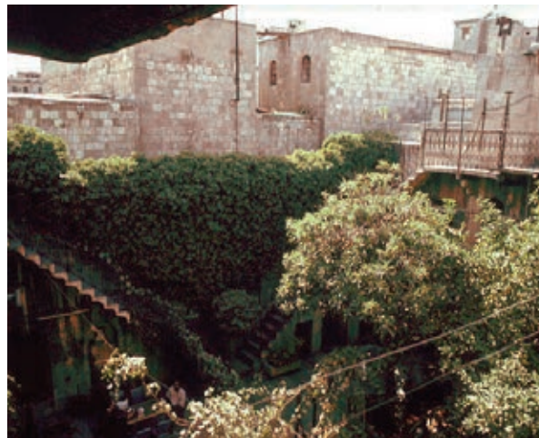
Abb. 226: Syrien, Aleppo, Baasil-Haus. – Stiegenläufe entlang der Hofmauer.
