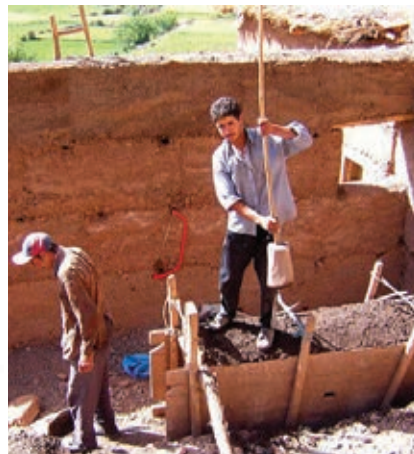
Abb. 53: Herstellung einer Stampflehmwand.
