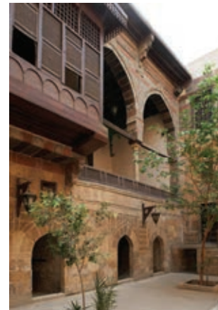
Abb. 156: Maq'ad im Innenhof des Jamal al-Din-Hauses in Kairo. – Ägypten.
