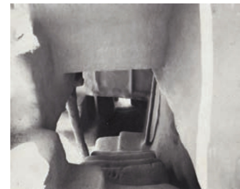
Abb. 121: Lehmtreppe eines einfachen ländlichen Hofhauses.
