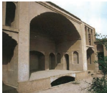
Abb. 93: Das abgesenkte Bodenniveau des Innenhofes ermöglicht auf einfache Weise die Belichtung von Kellerräumen.
