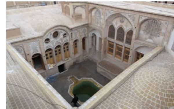
Abb. 96: Nebenhof mit Wasserbecken im Ameriha-Haus in Kashan. – Iran.
