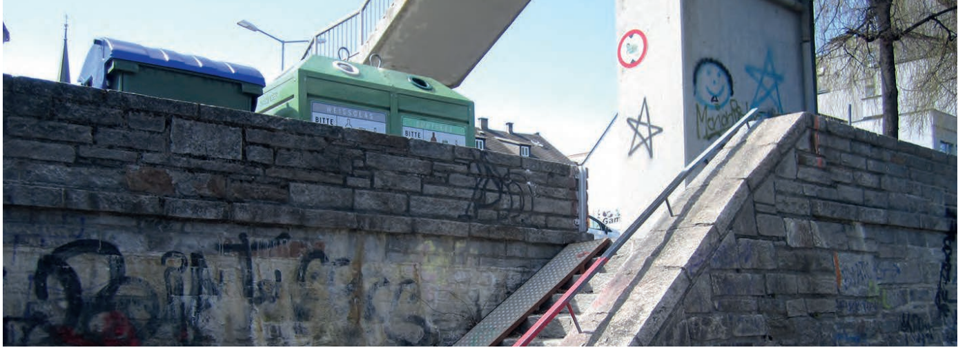
02.05 Treppenaufgang unter der Fußgängerbrücke
