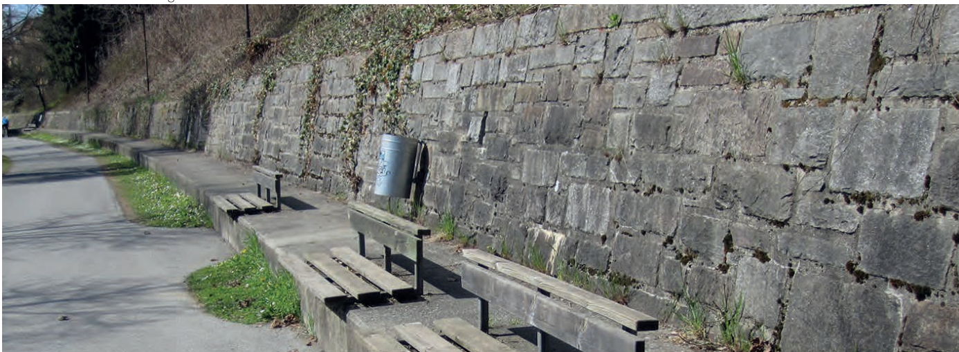
01.28 Sitzbänke entlang der Ufermauer
