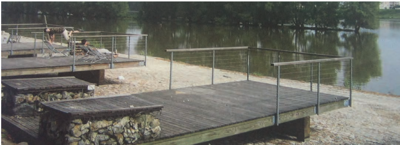
01.39 hölzerne „Loirebalkone“ am Flussufer
