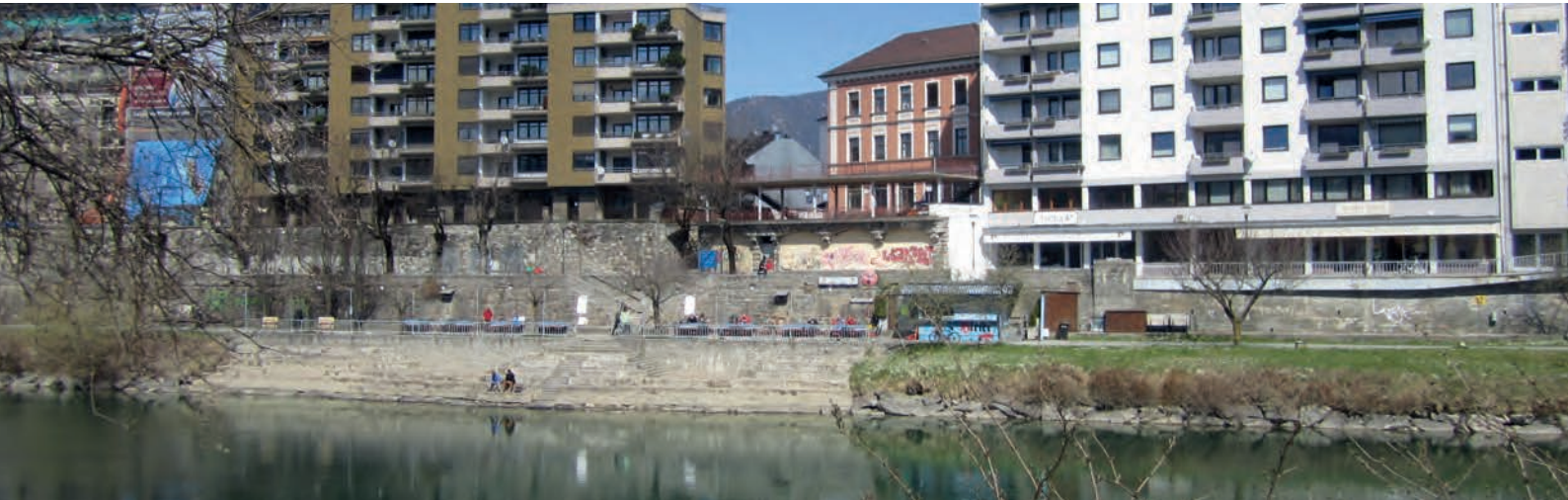
Cafèbereich und Abtreppe auf der Ufermordseite 01.42
