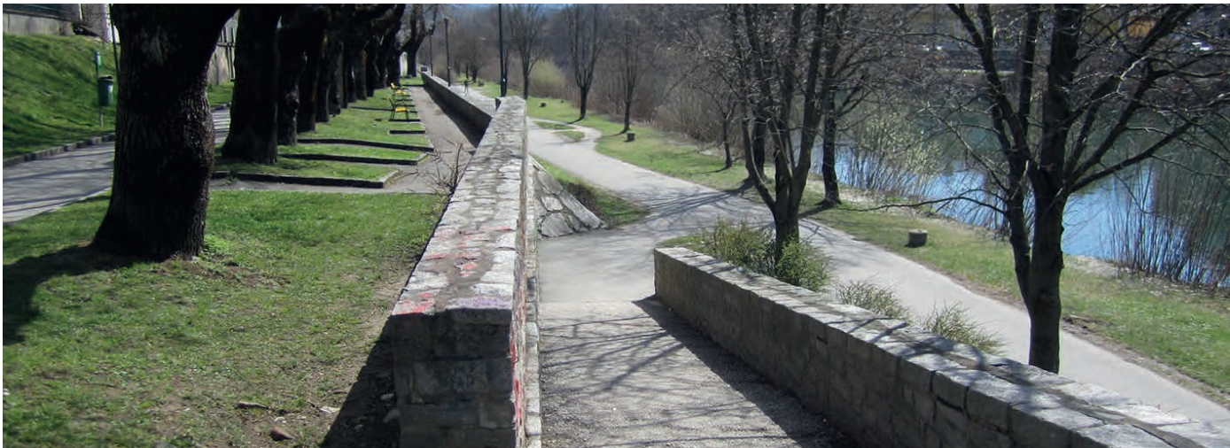
02.07 rechtes Ufer beim Congress Center Blick Flussabwärts, mit Radfahrererrampe
