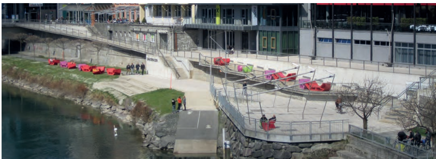
01.36 Blick von der Fußgängerbrücke zu den Drauterrassen
