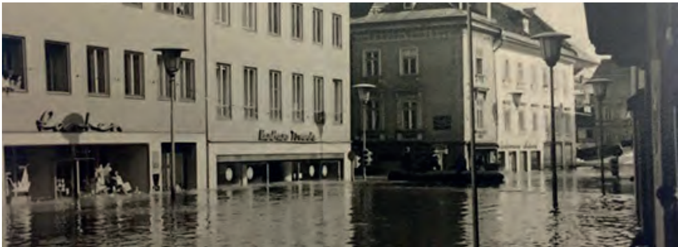
01.24 Hochwasser 1965, unterer Hauptplatz Blick zur Stadtbrücke
