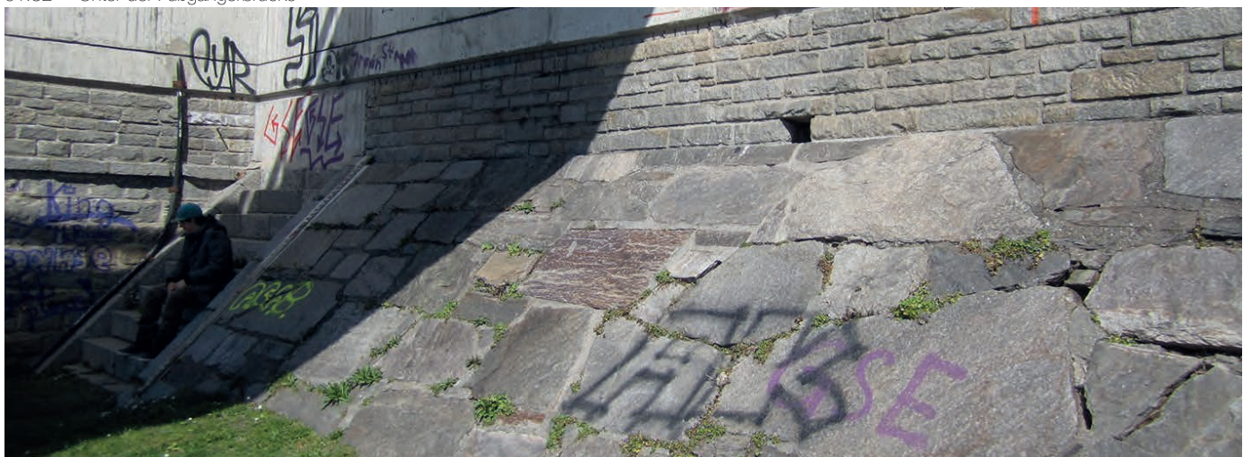
01.32 Unter der Fußgängerbrücke
