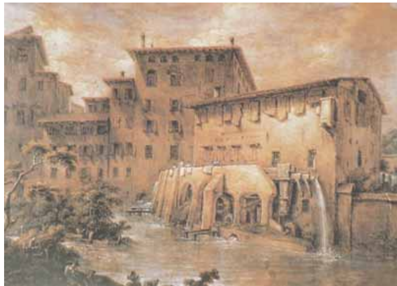
Bild 4. 66 Industrieanlagen sul Canale delle Moline , Ölgemälde Basoli
