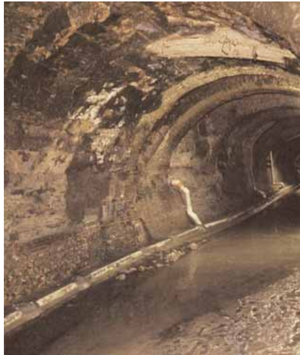
Bild 8. 30 Die römische Brücke über die Via Emilia vor Sanierung des Stollens durch die Gemeinde
