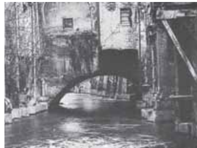
Bild 4. 137 Ponte Via Piella
