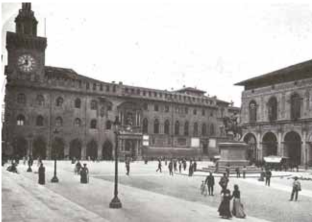
Bild 6. 12 Piazza Maggiore nach Restaurierung des Palazzo Comunale um 1890, Versuche zur Authentizität und Entfernung von Dekorationselementen bei Fenstern und dem portico , dem Balkon „ Ringhiera degli Anziani “, neue Zinnen, Uhr an die Zeit angepasst
