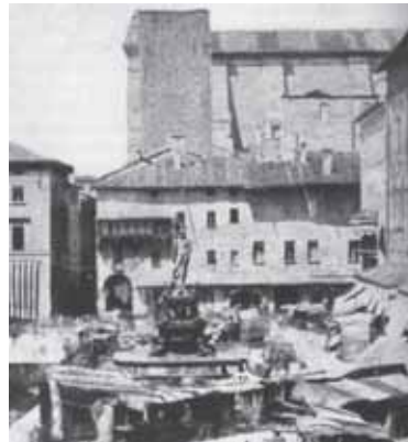
Bild 10. 9 Piazza Nettuno, vor Demolierung
