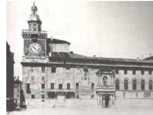
Bild 6. 31 Nach Restaurierung, große Fenster im piano nobile , Foto 1876/ 1877
