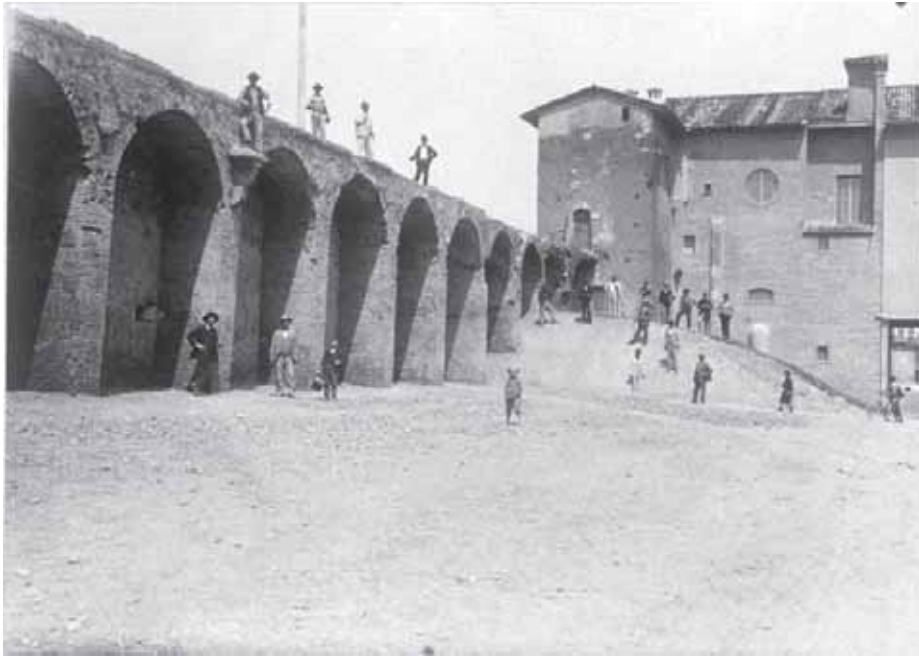
Bild 10. 32 Mauer innen bei Porta di S. Isaia (auch Porta Pia ), Chiesa della Grada
