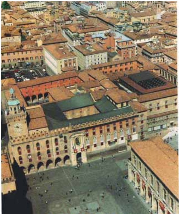
Bild 6. 38 Luftbild Palazzo Comunale, rechts der Komplex der Sala di Borsa
