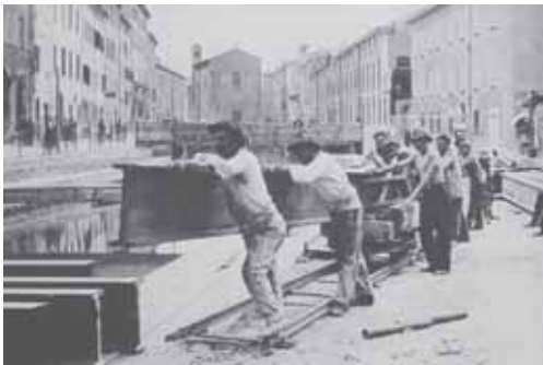
Bild 10. 44 Arbeiten am Reno Kanal
