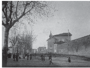
Mauer bei Porta S. 'Isaia – San Rocco
