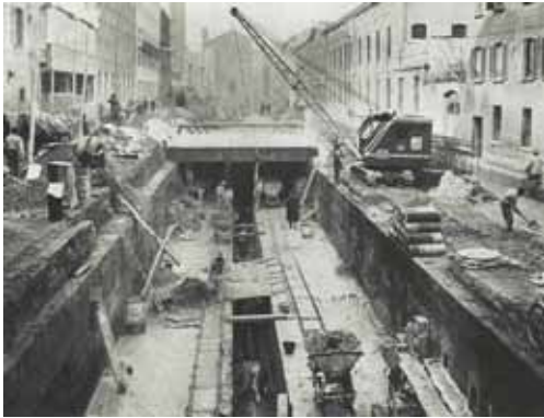
Bild 10. 43 Überdeckung Reno Kanal Santuario di Santa Maria della Visitazione all Ponte delle Lame
