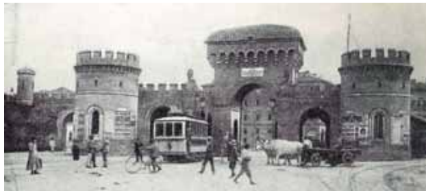
Bild 3. 18 Porta Saragozza , Endstelle
