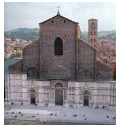
Bild 5. 41 San Petronio nach der Restaurierung des Marmor-Sockels und der Portale aus dem 16. Jahrhundert.
