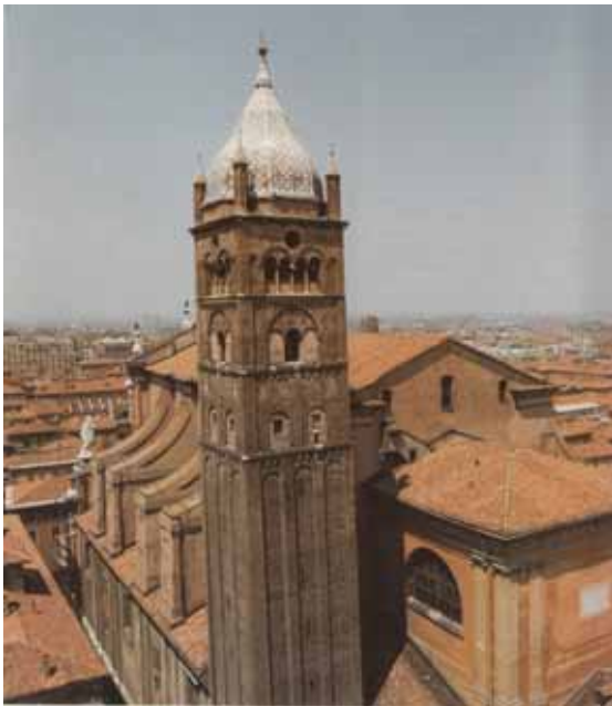
Bild 5. 29 San Pietro, Campanile mit dem Stein-Dach
