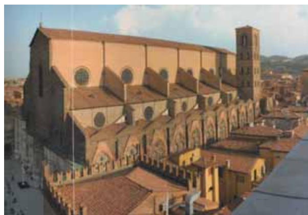
Bild 5. 46 San Petronio , seitliche Flanke, Blick vom Uhrturm
