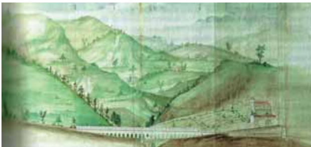
Bild 4. 88 Trinkwasserleitung unter San Michele in Bosco
