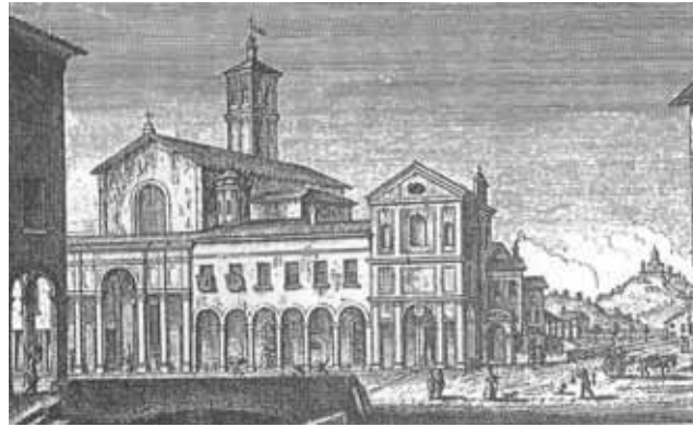
Bild 4. 129 Brücke über den Reno vor der Chiesa S.M. della Carità Panfilii, Stich 1786, der Kanal fließt unterhalb durch
