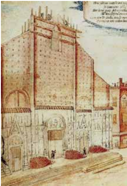
Bild 5. 37 Konstruktion des Gewölbes des Mittelschiffs und Arbeiten an der Fassade 1647, mit Baugerüst und gelagerten Materialien, Ausschnitt Insignia degli Anziani, terzo bimestre, Archivio di Stato di Bologna
