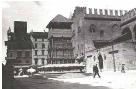
Bild 4. 106 Nettuno eingerüstet , Sandsäcke Bild 1. Weltkrieg, Luftangriffe der Österreicher
