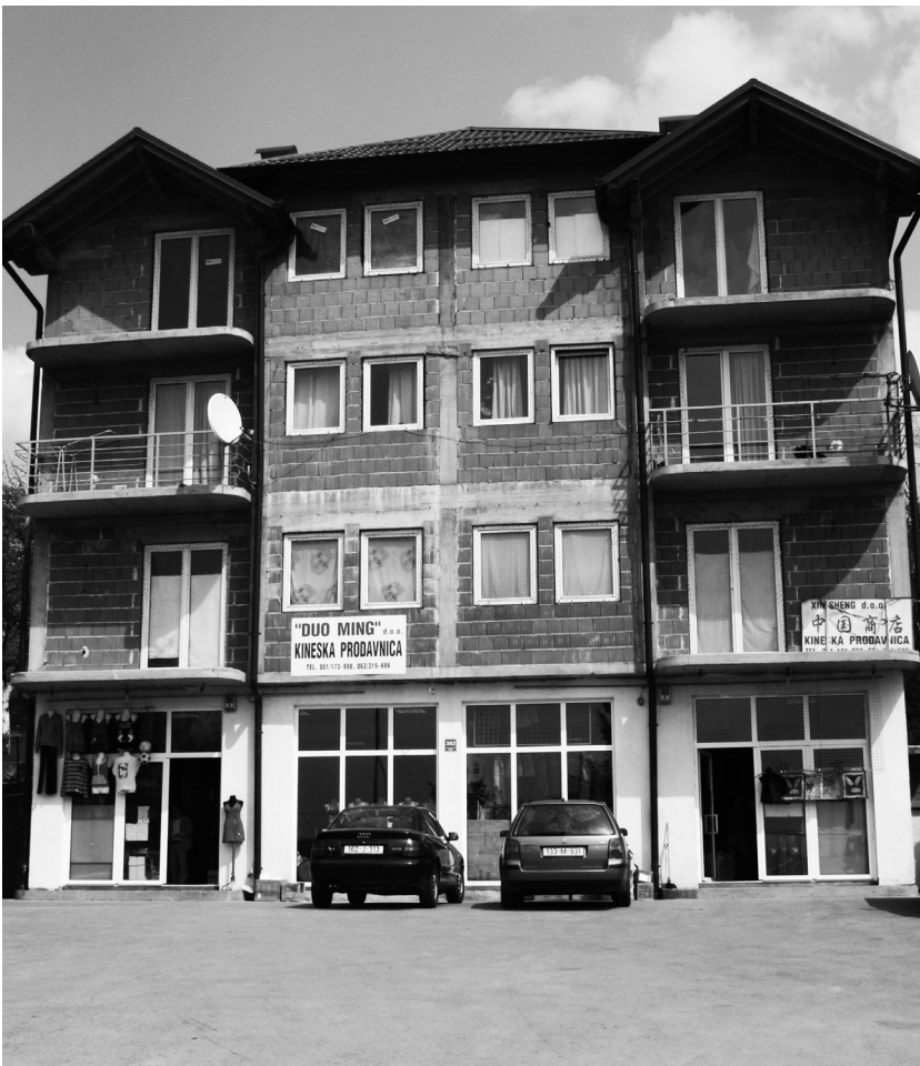
Abbildung 18: Wohn-, Lager- und Geschäftshaus, Sarajevo, Rajlovac
