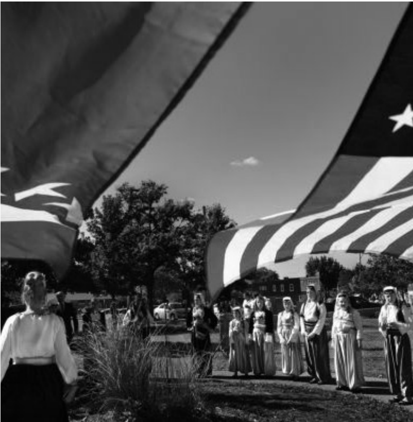
Abbildung 03: Feierlichkeiten zu Grundsteinlegung des Sebiljs (eine Art bosnischer Brunnen) St.Louis, South City, Bevo
