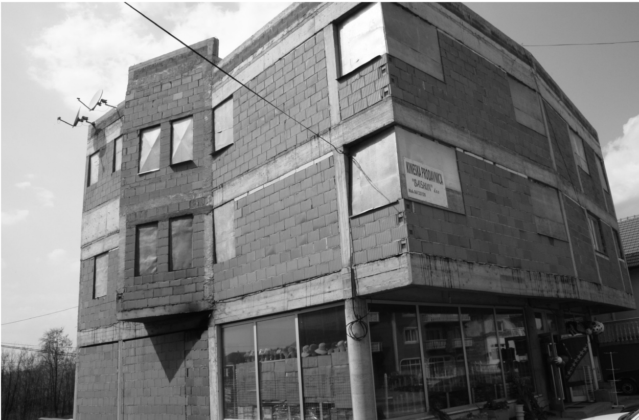
Abbildung 20: Wohn-, Lager- und Geschäftshaus in Rajlovac, Sarajevo.
