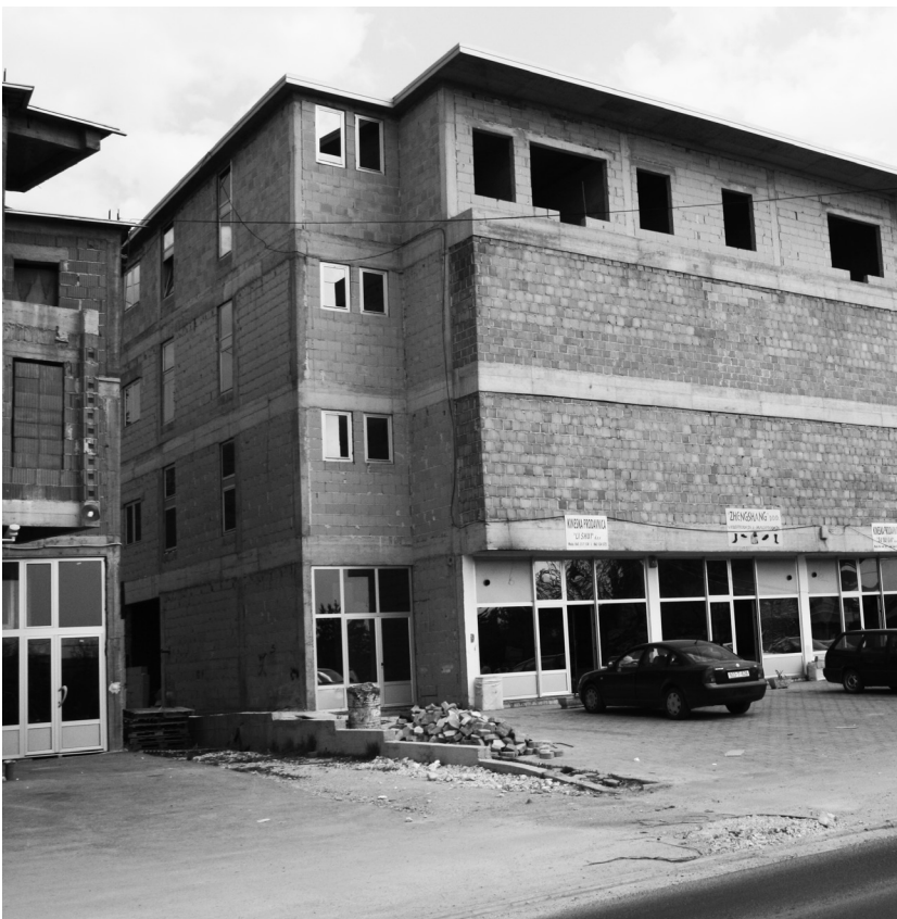
Abbildung 13: Bau eines Minieinkaufszentrums mit Geschäften und Lagerflächen, Sarajevo, Rajlovac
