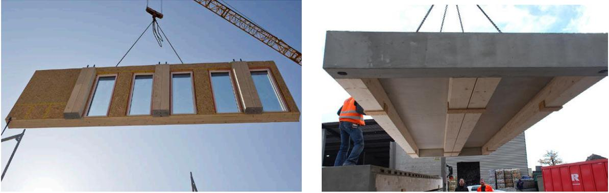
Verheben der Fertigteil- Elemente durch einen Kran, Abb.5.33
