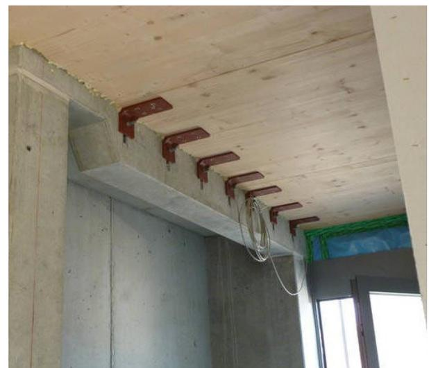
Anschluss Stiegenhauskern aus Betonfertigteilen mit der elementierten Brettspertholzdecke. Abb.5.18
