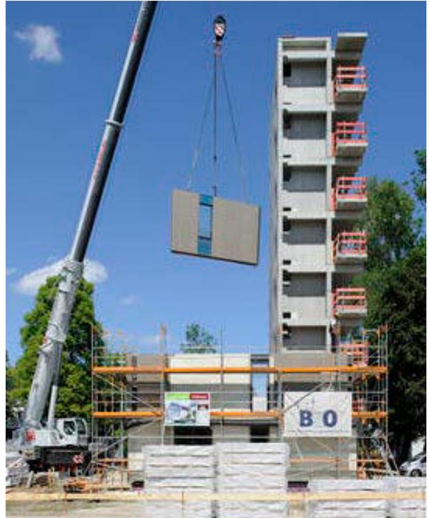
Errichten der vorgefertigten Holz- Wand- und Deckenfertigteile. Abb.5.16
