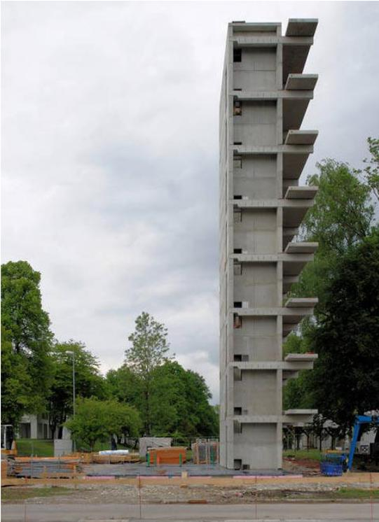
Fertigstellung Betonfertigteil Treppenturm, sowie die Auskragungen für den Laubengang. Abb.5.15
